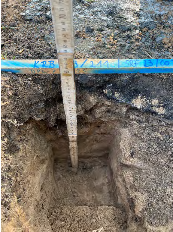
Bild 1: Schurf SRF 23/007, Aufbau von oben nach unten: Asphalt (0,00 bis 0,10 m Tiefe), Tragschicht (Schotter/Granitbruch, graubraun; 0,10 bis 0,30 m Tiefe), Mittelsande (Bodengruppe A [SE], braun; 0,30 bis 0,50 m Tiefe); 01.09.2023
