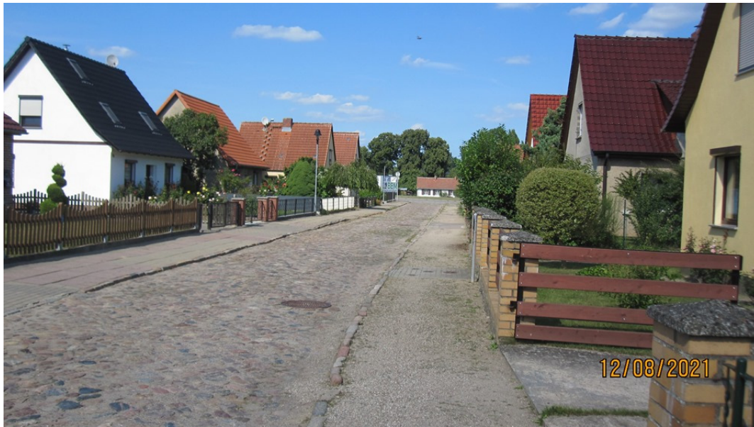
Bild 1: Rosenplansiedlung Blick Richtung Perleberger Straße
