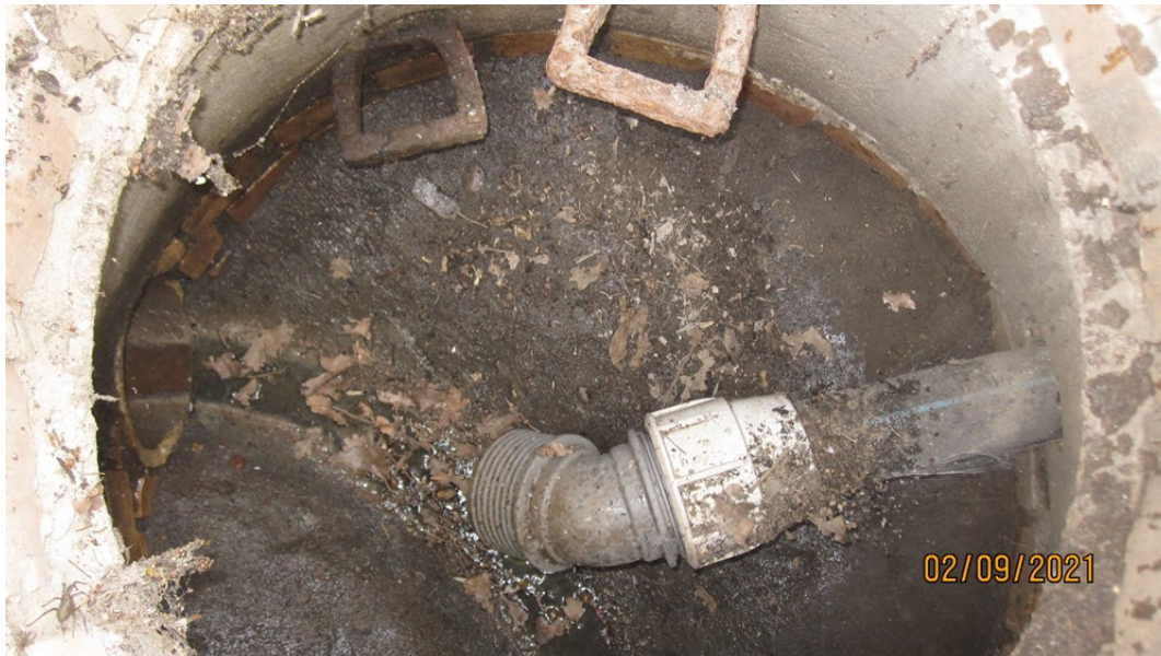
Bild 7: Schacht S51 alt
