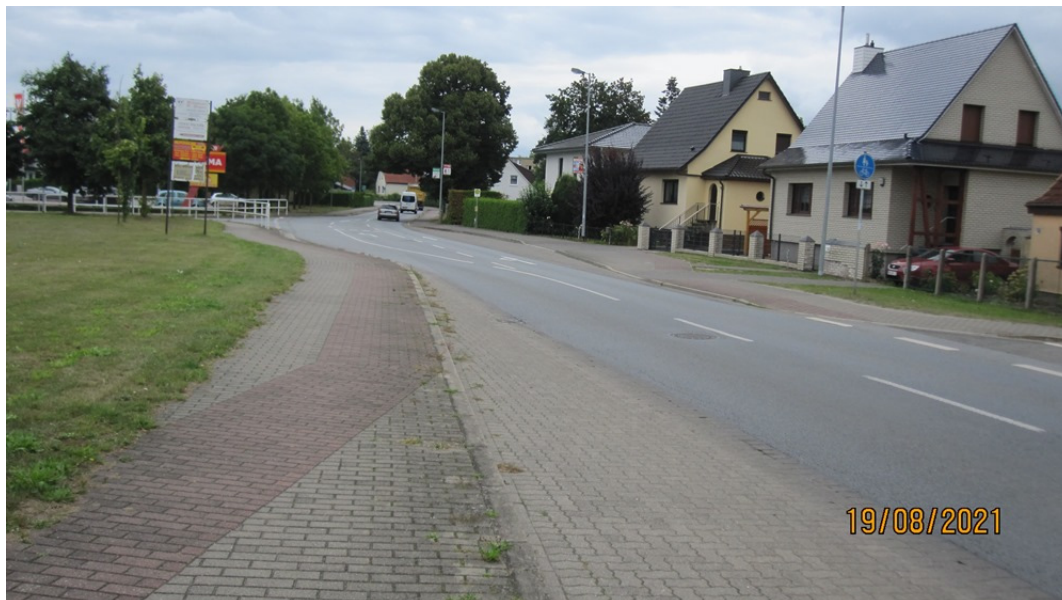
Bild 4: Blick Richtung Bauende BA 1
