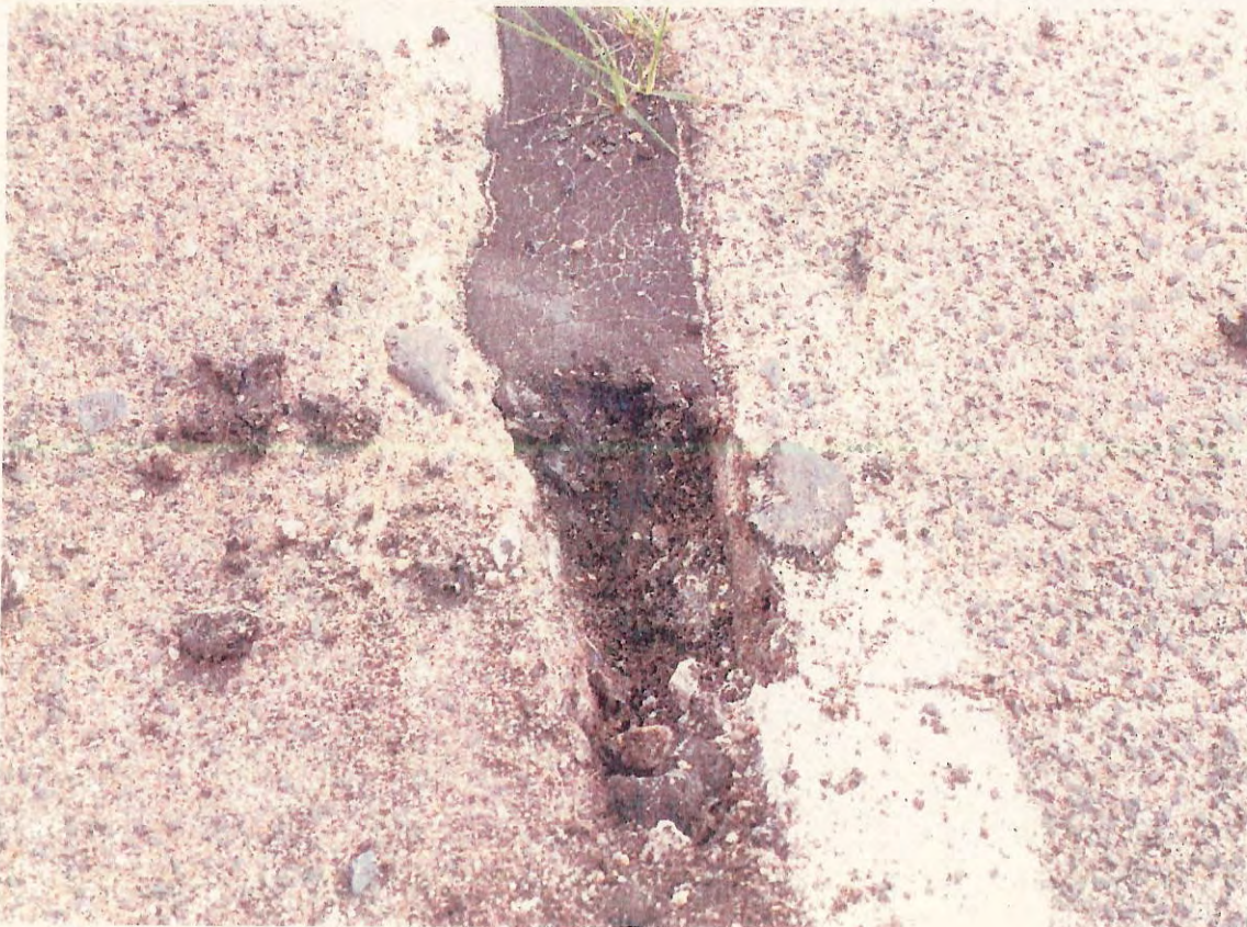
Foto 6: Fugenmaterial auf Kohleteerbasis (Probe P1).
