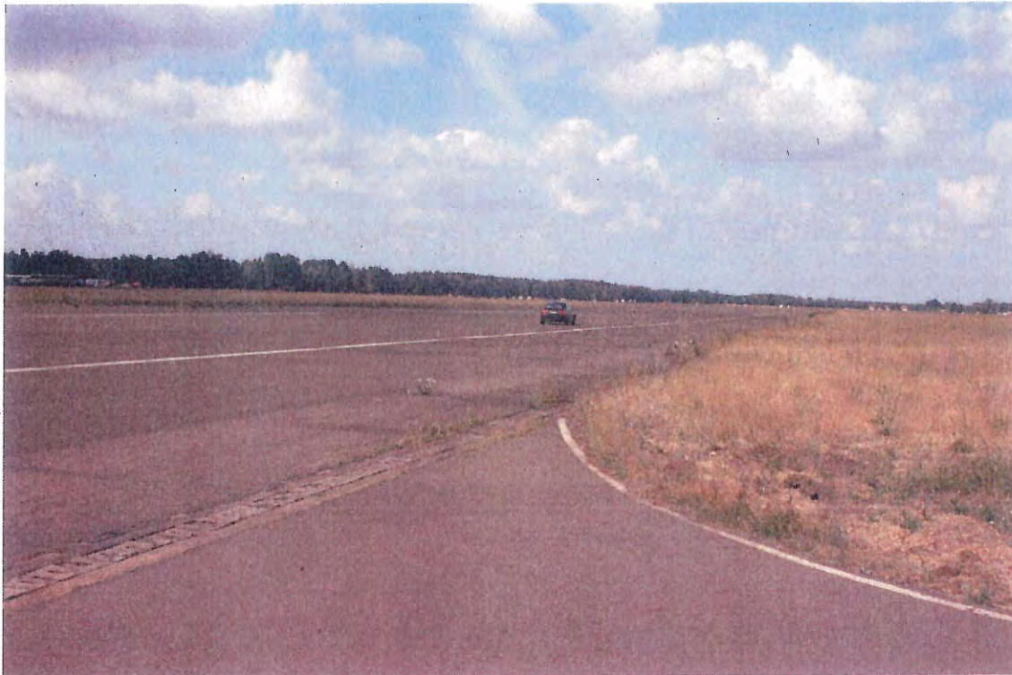
Foto 7: Vorstartlinie (Alllastenverdachtsfläche 8) aus vor Ort gegossene und verfugte Betonplatten sowie flächenanteiliger Bitumen-(P5) bzw. Kunstharzversiegelung (P 6).
