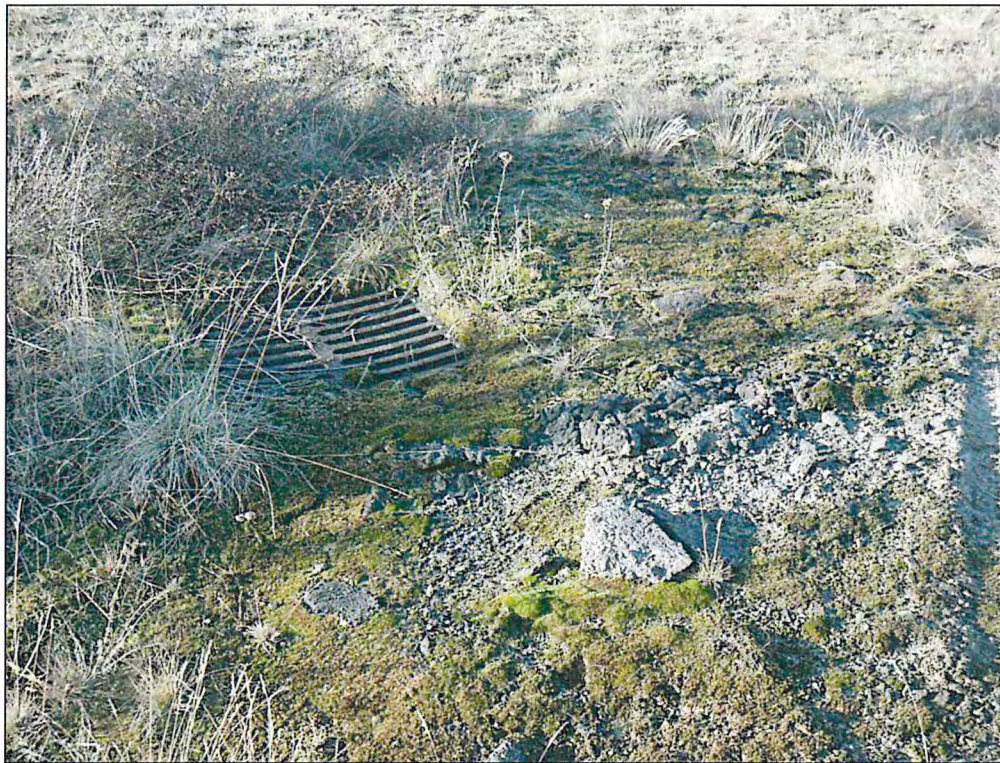
Foto 5: verbliebener Regenwassereinlauf im Zentralteil des Untersuchungsgebietes
