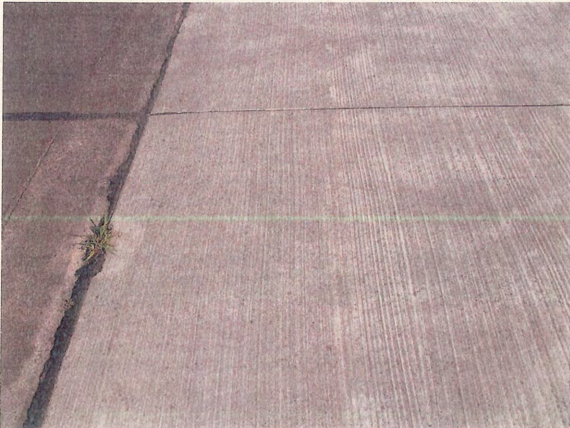
Foto 10: Die Betonversiegelung der Vorstartlinie wurde teilweise erneuert.
