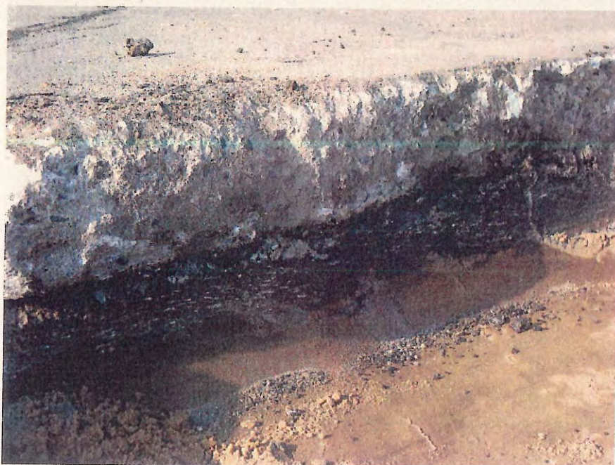
Abbildung 2: Überdeckung der ehem. Kreuzlandebahn durch Betonplatten der neueren Start- und Landebahn
