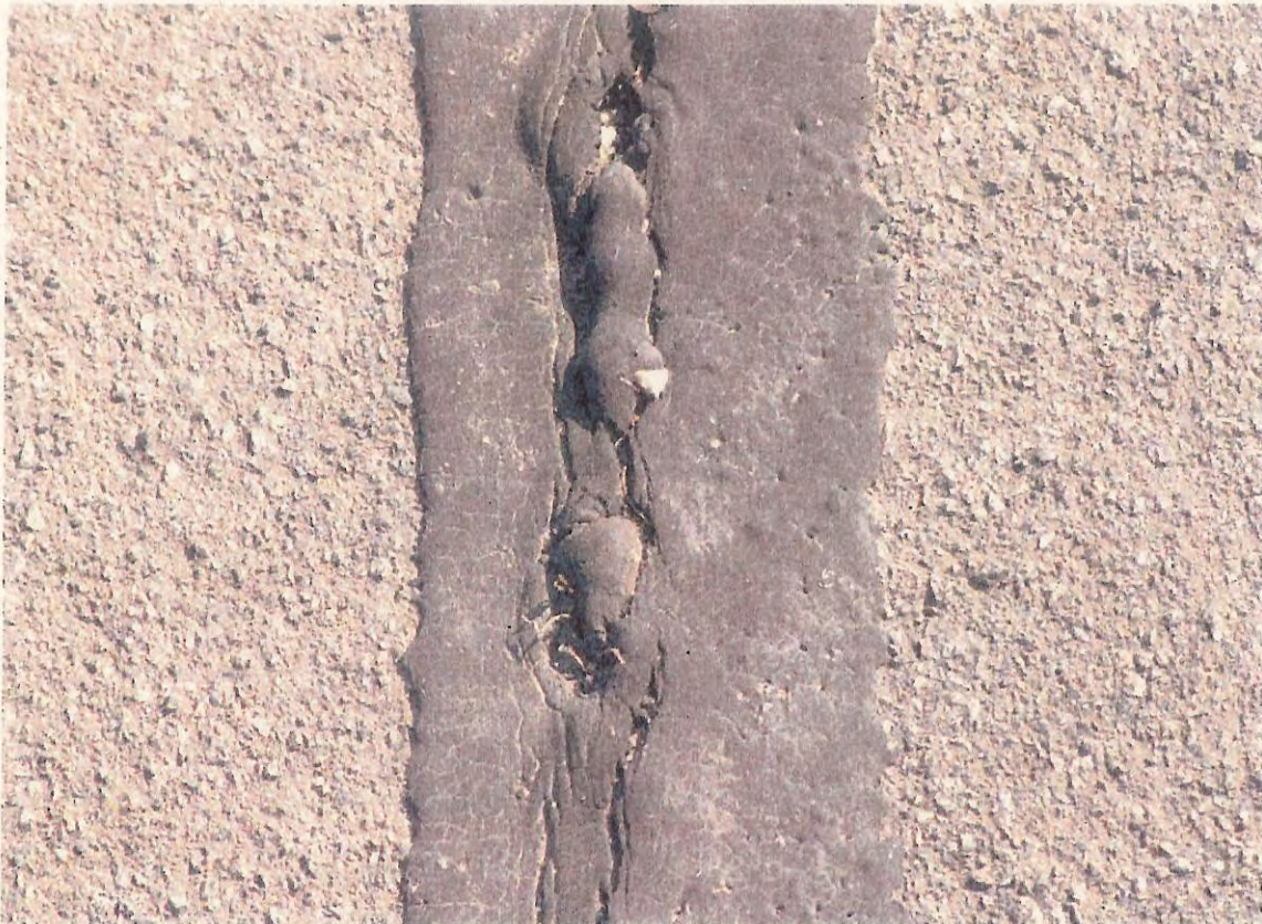
Foto 9: Fugenmaterial auf Kohleteerbasis (Probe P4).
