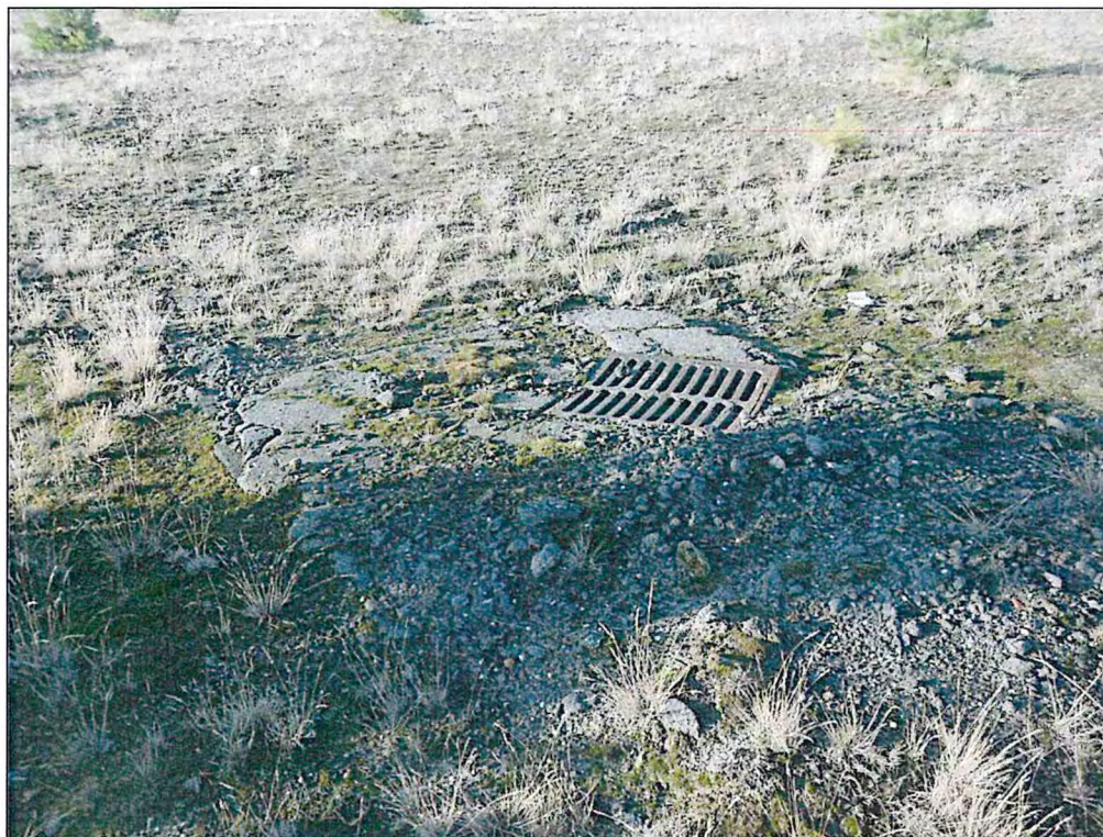
Foto 6: verbliebener Regenwassereinlauf im westlichen Zentralteil der ehemaligen Kreuzlandebahn
