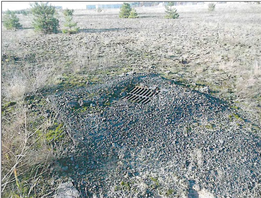
Foto 8: verbliebener Regenwassereinlauf im Westbereich der ehemaligen Kreuzlandebahn
