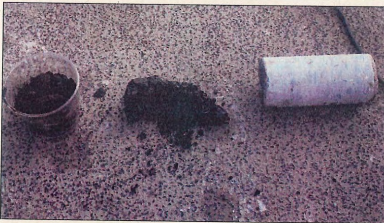
Bohrkern KB 2 (Kernbohranteil bis 0,40 m unter GOK) mit Teerablagerungen unterhalb der Betondecke
