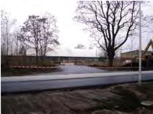
Grundstückszufahrt von der verl. Pappelallee (Bauzustand 23.11.2007)
