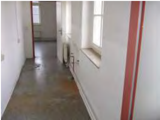
Seitenfluransicht mit zurückgebauter Waschbeckenlösung, 1. OG
