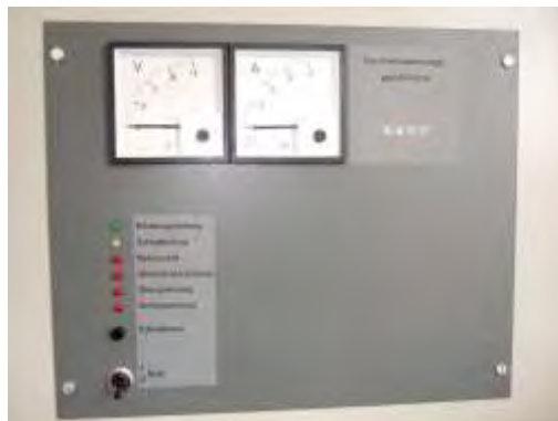
Konstantspannungsgleichrichter (Schrankgröße), 1. OG
