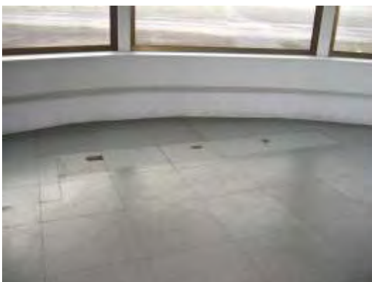
Tower-Turm mit aufgeständertem Fußboden, 2. OG
