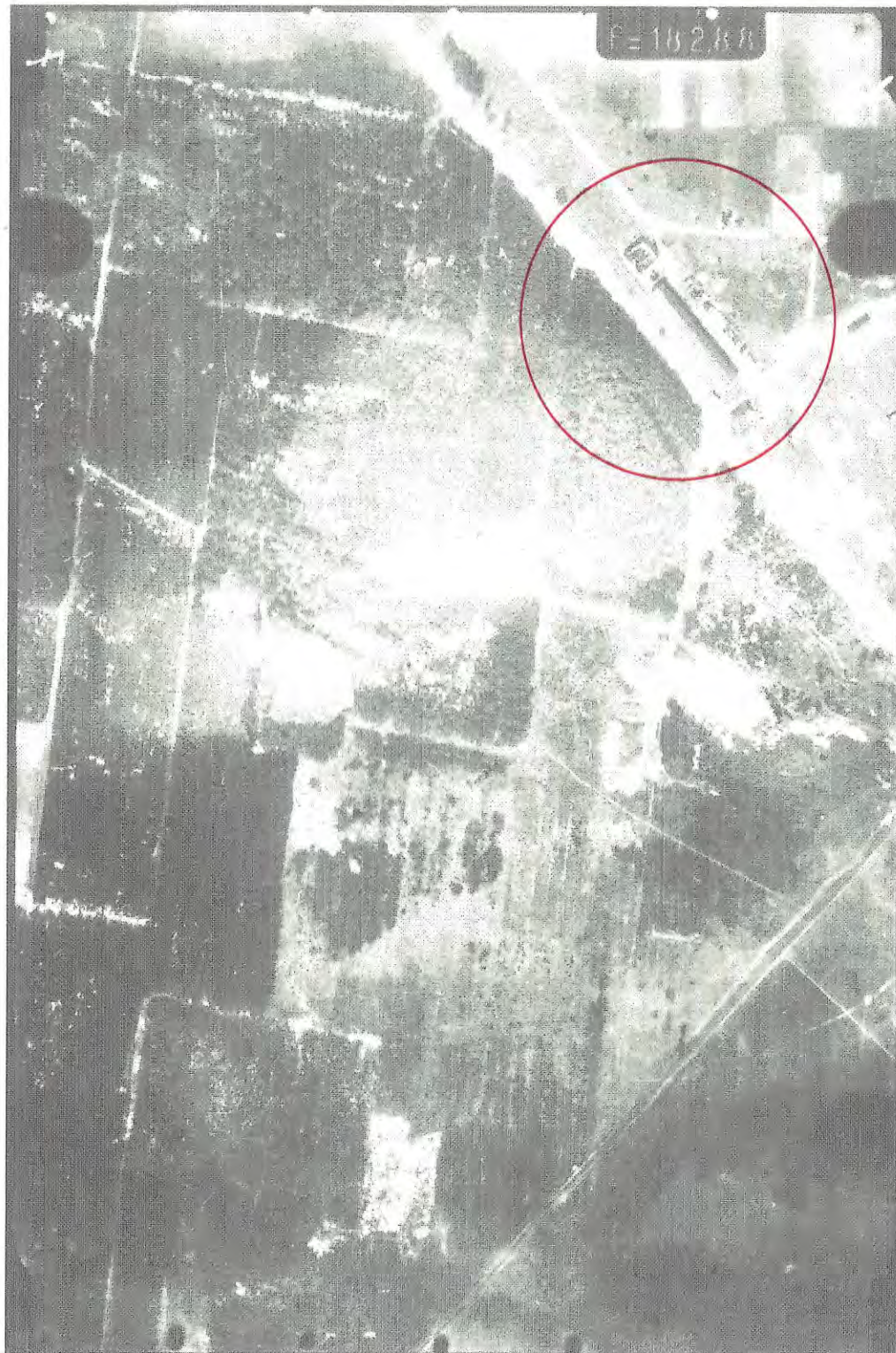
Abbildung 3: Luftbildaufnahme von 1928, Westlicher Teil Kennzeichnung der Gebäude Kraftverkehrsgesellschaft Marken
