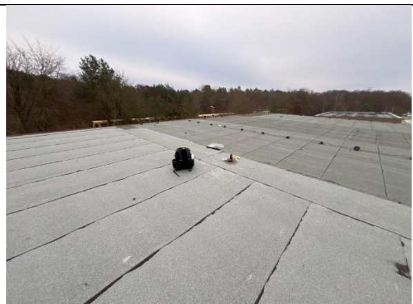
Sporthalle – obere Dachfläche
