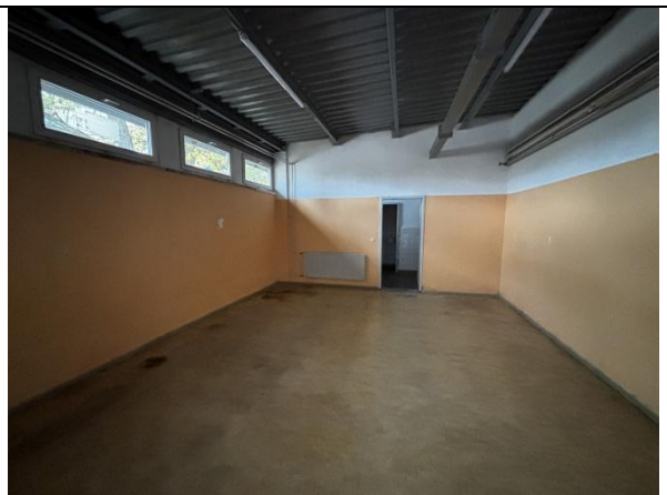
Sozialtrakt – ehem. Umkleidebereich
