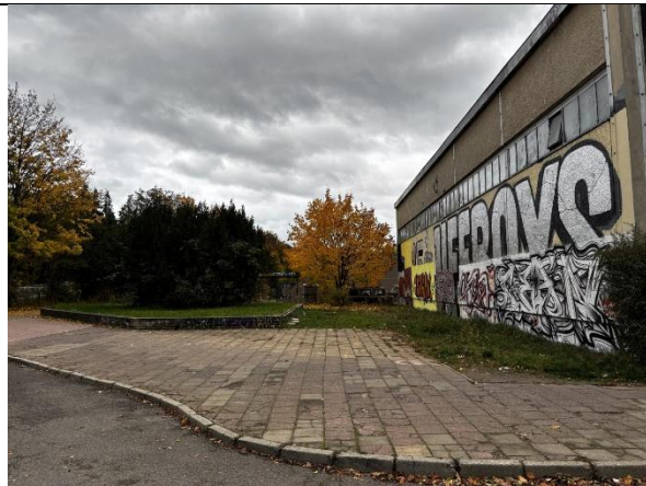
Sporthalle – Fläche hinter Westseite
