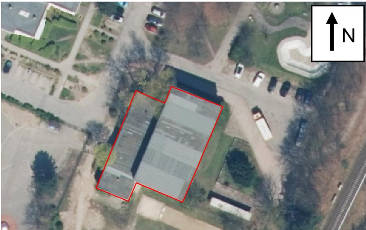
Abbildung 1: Satellitenbild vom untersuchten Gebäude (Quelle: Geoportal Brandenburg).
