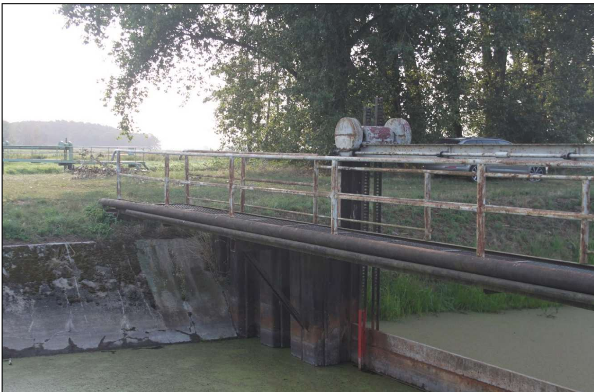
Abbildung 21: Schutzrohre am Bediensteg, unterwasserseitig (08/2018)
