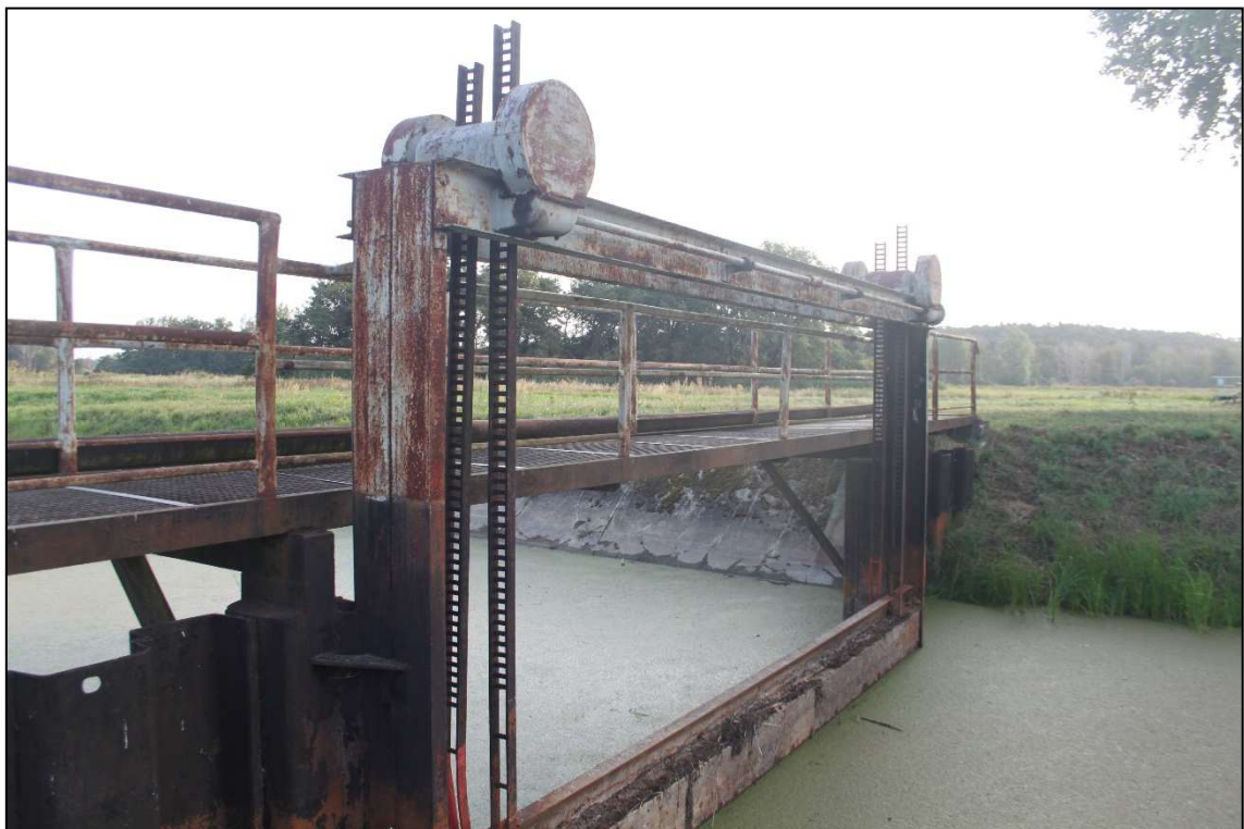
Abbildung 16: Wehransicht vom OW, Wehr- und Maschinenrahmen (08/2018)
