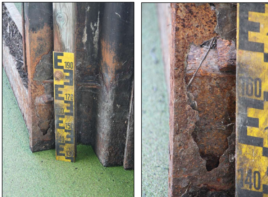
Abbildung 14: Durchrosteter Wehrrahmen rechte Seite (08/2018)
