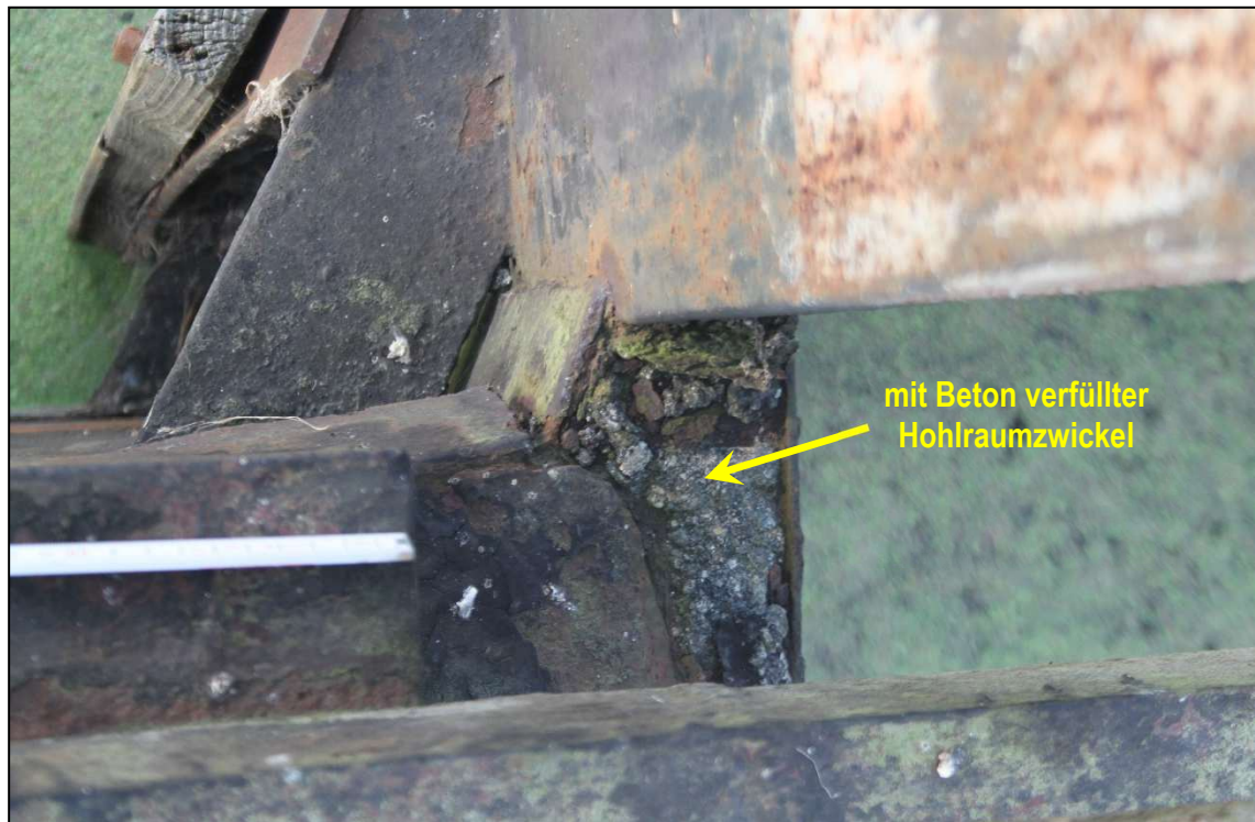
Abbildung 15: Befestigung Wehrrahmen an Spundwandpfahl, verfüllter Hohlraumzwickel (08//2018)
