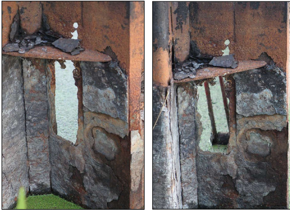
Abbildung 13: Durchrosteter Wehrrahmen, linke Seite (08/2018)
