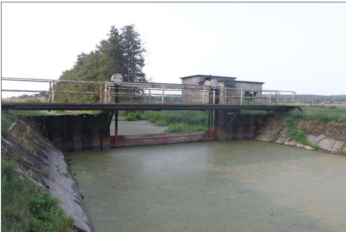
Abbildung 20: Böschungssicherungen Tosbeckenbereich, Blick ins OW (08/2018)
