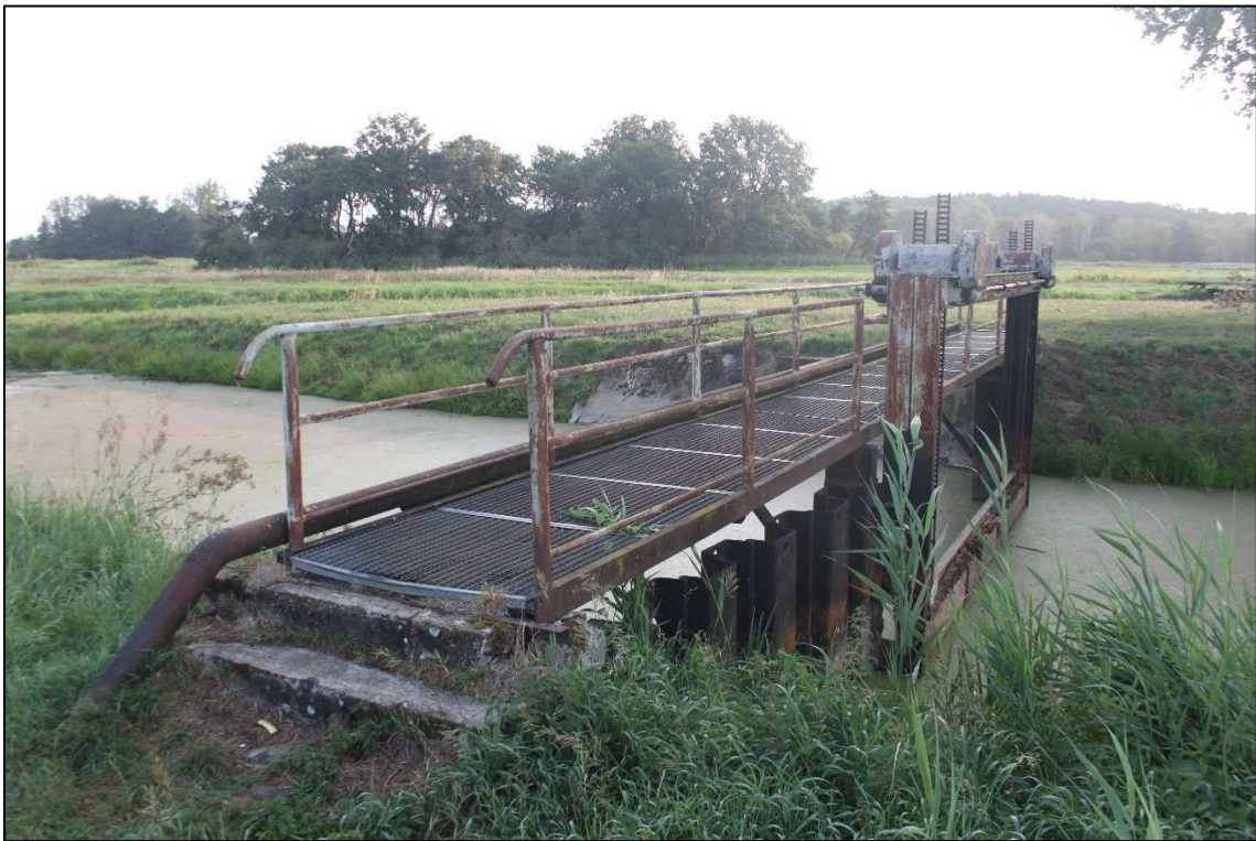
Abbildung 18: Wehrbediensteg, Ansicht in Richtung UW, re. Ufer (08/2018)
