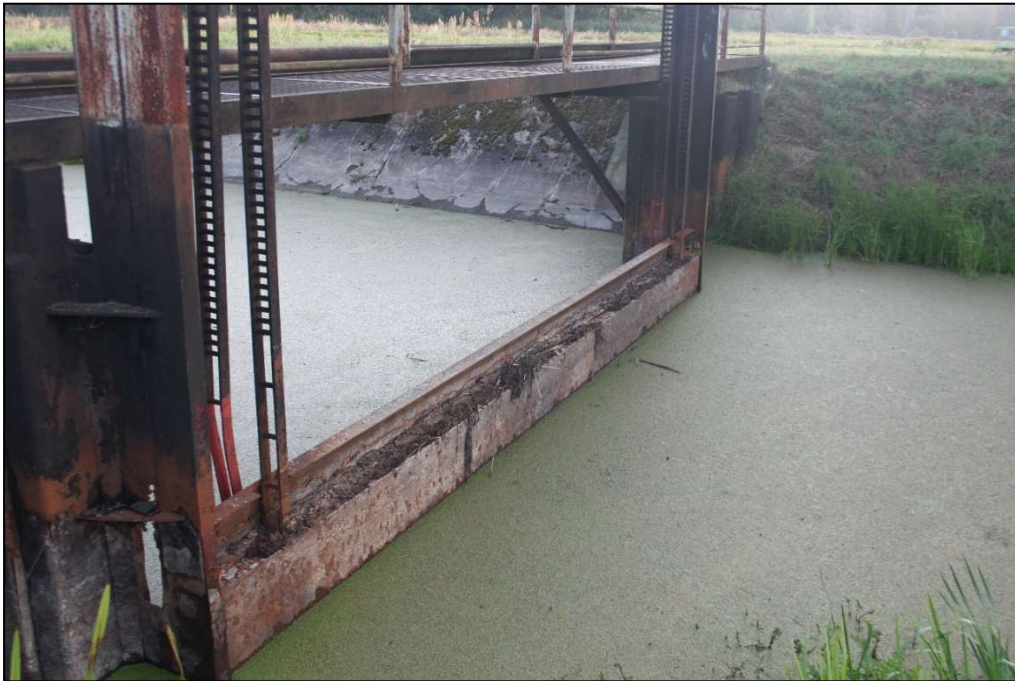
Abbildung 11: Doppelschützverschluss, Oberschütz, Blick in Richtung UW (08/2018)
