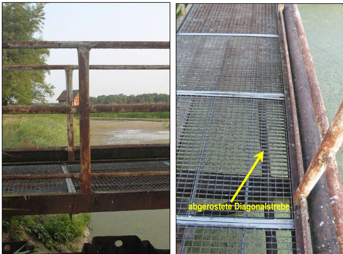
Abbildung 17: li. Bediensteg mit Geländerpfosten; re. Gitterrostbelag (08/2018)
