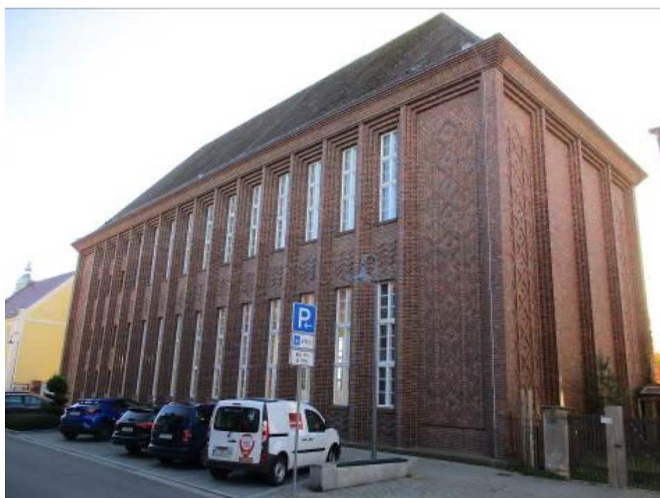
Ansicht Stirnseite Bereich Nebentreppenhaus
