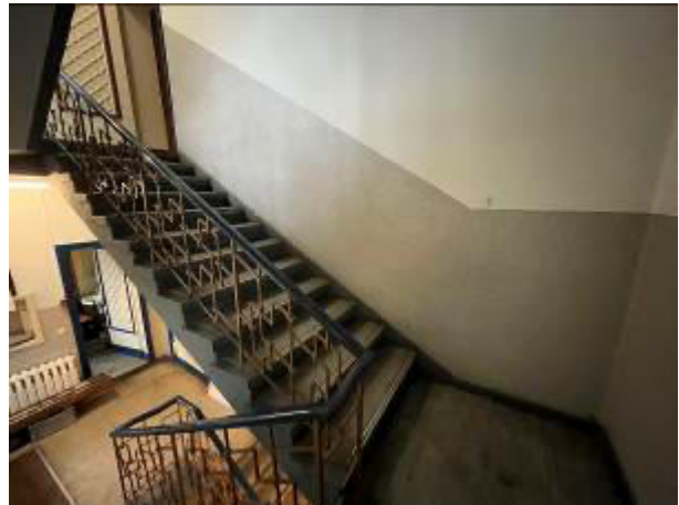
Zwischenpodest ins 1. Zwischengeschoss
