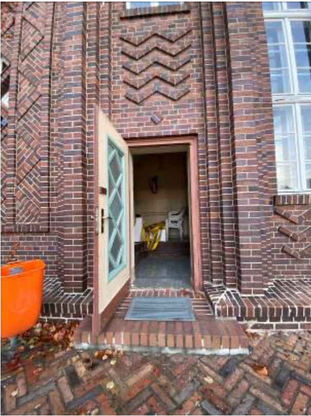
Zugang über Rückseite Gebäude
