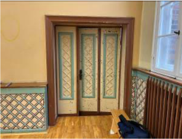
Blick aus Halle unten
