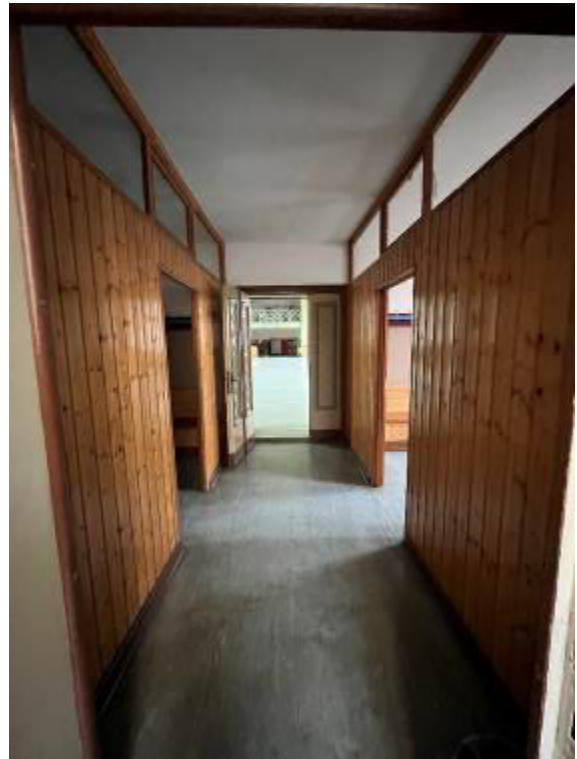
Blick Richtung Turnhalle OG
