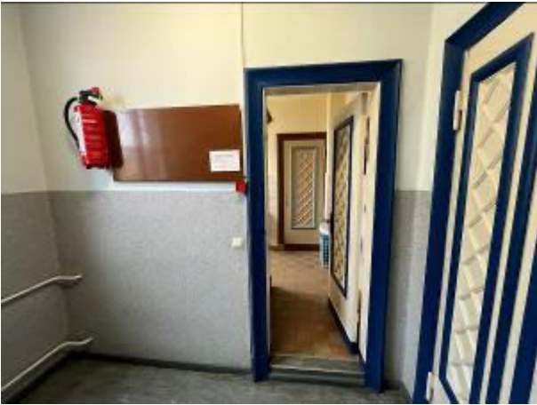
Blick aus Treppenhaus
