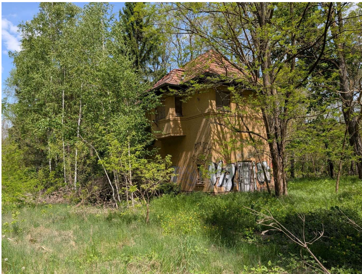
Abbildung 13: Ehemaliges Stellwerk Jamlitz
