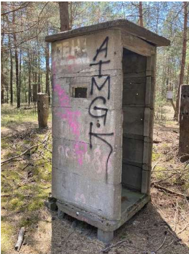
Abbildung 10: Telefonhäuschen 2 auf ehemaligem Bahndamm
