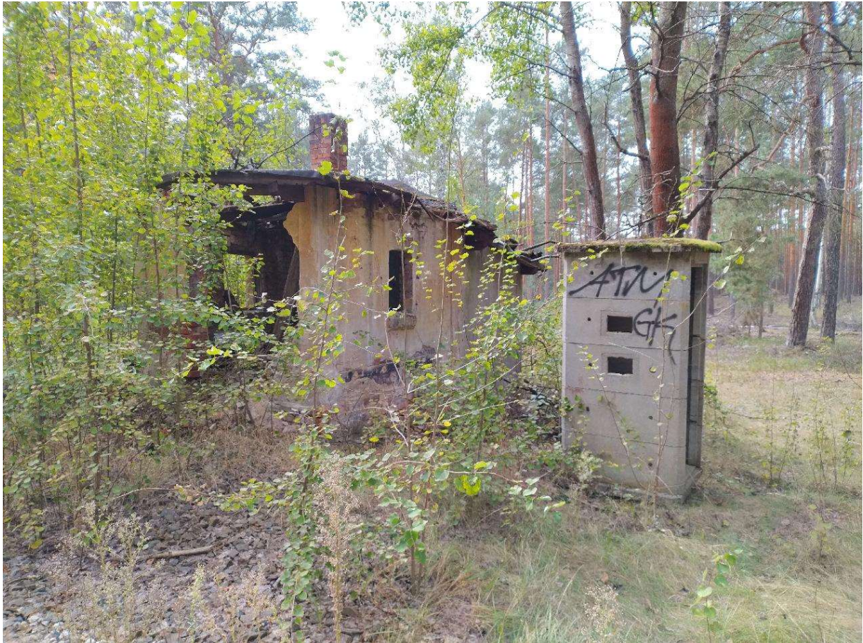
Abbildung 15: Bahnwärterhäuschen und Telefonhäuschen
