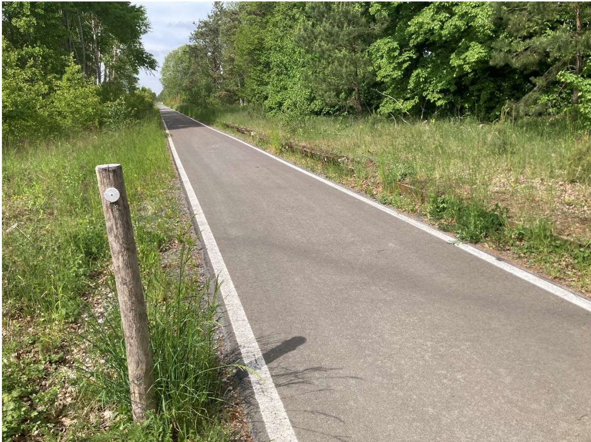
Abbildung 16: Radweg am ehemaligen Bahnhof Ullersdorf mit originaler Bahnsteigkante
