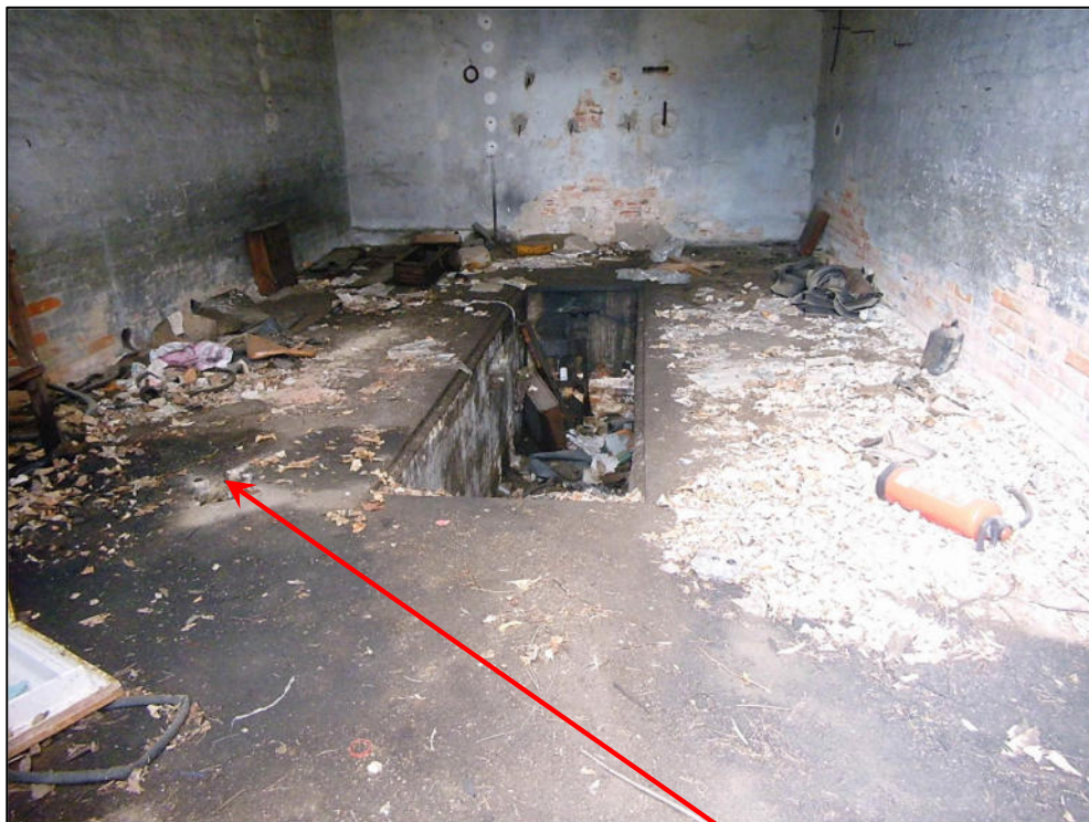
Bild 1 : Ansicht von der mittleren Garage, Anbau Sägewerk, Probe 23059 - 7
