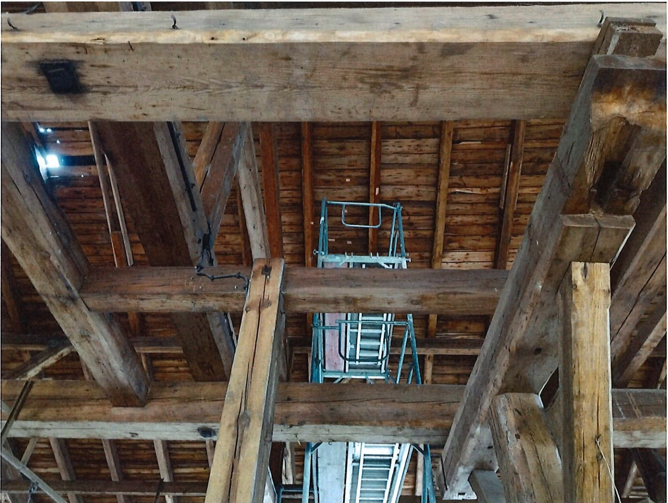
Bereich Gerüsttum = Bebrobungsstellen
