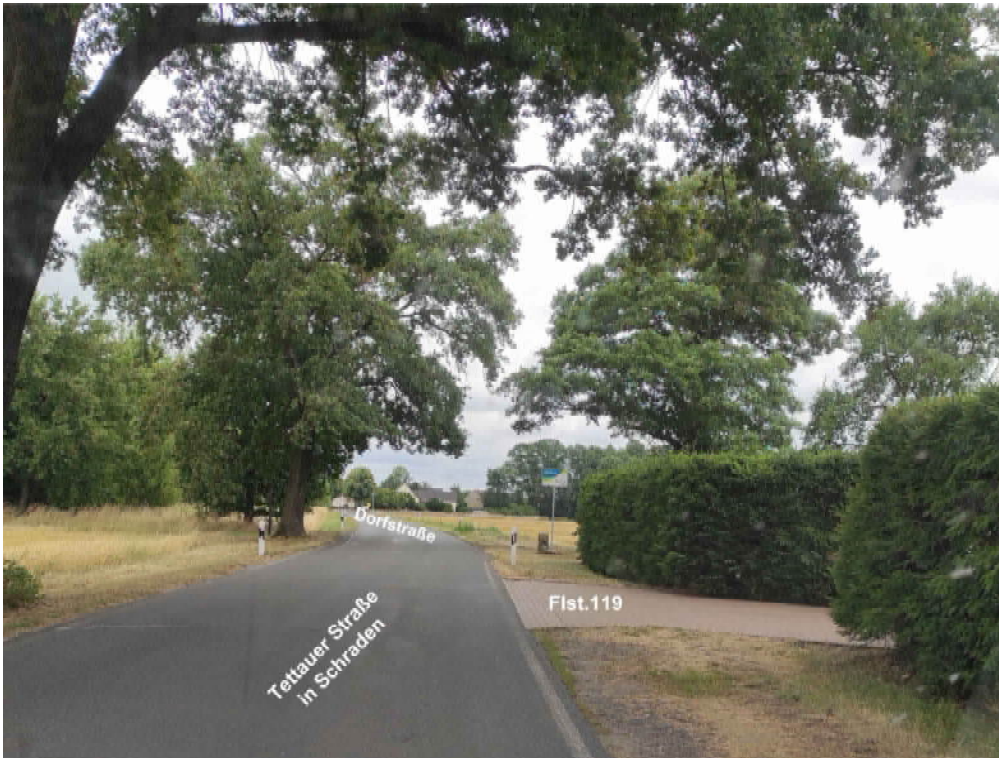
Abbildung 4: Bauende BA2 – Dorfstraße / Tettauer Straße Blick in Richtung Tettau
