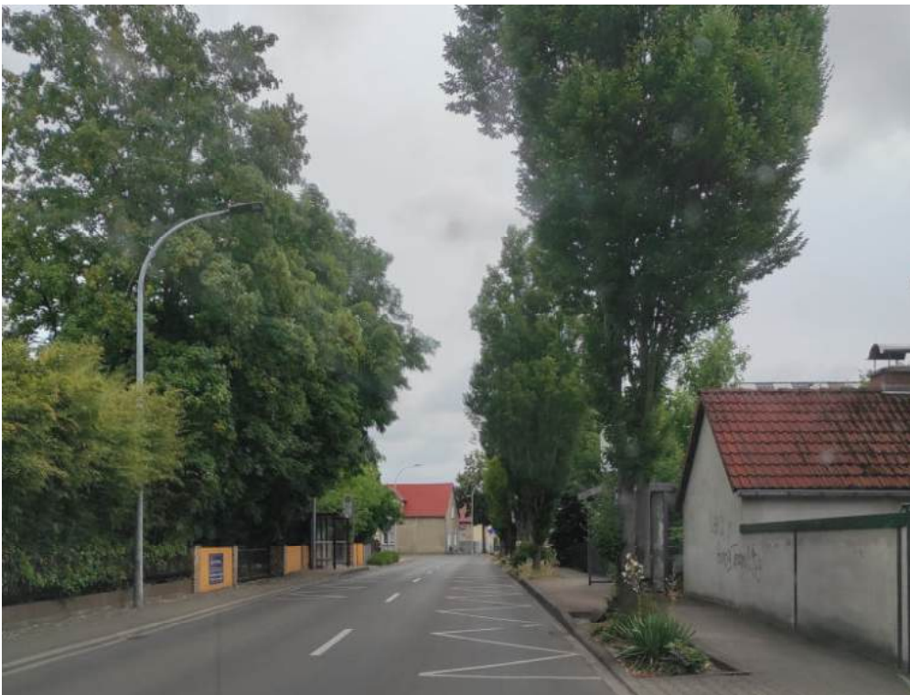
Abbildung 6: Lauchhammer Straße Stat. 0+40,00 Blick in Stationierungsrichtung
