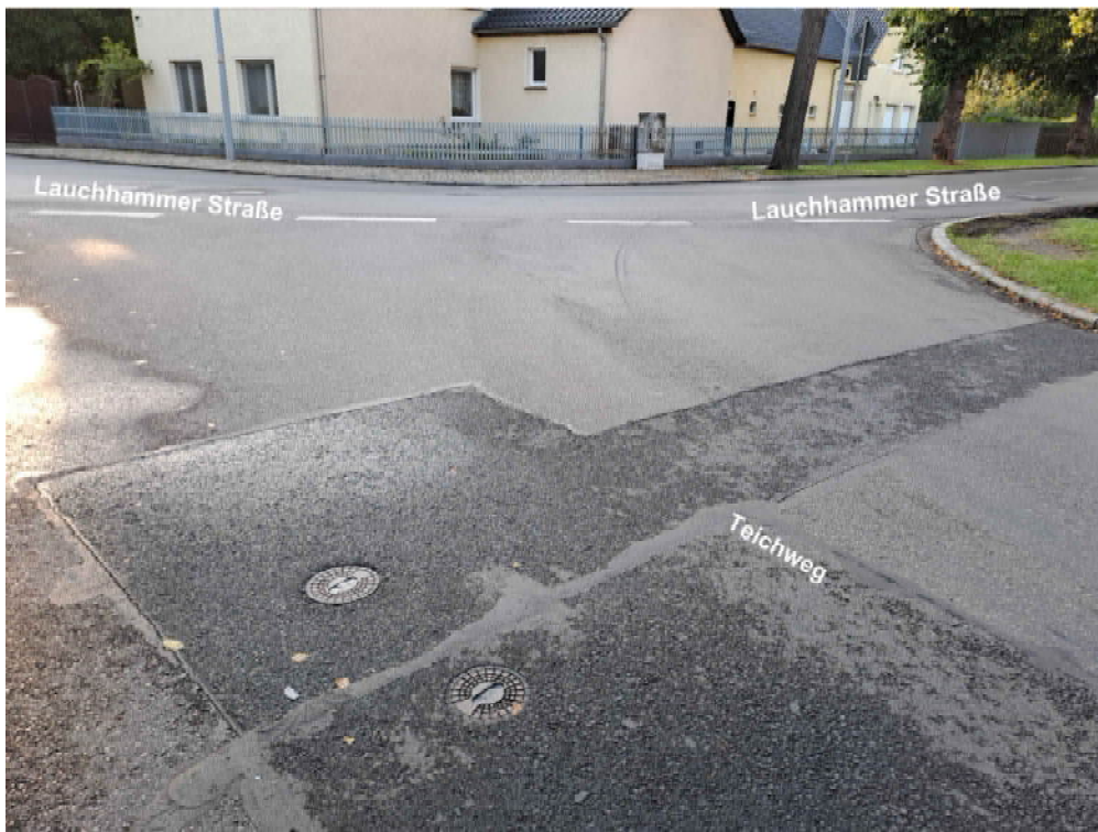
Abbildung 3: Bauende BA1 – Kreuzung Lauchhammer Straße / Teichweg
