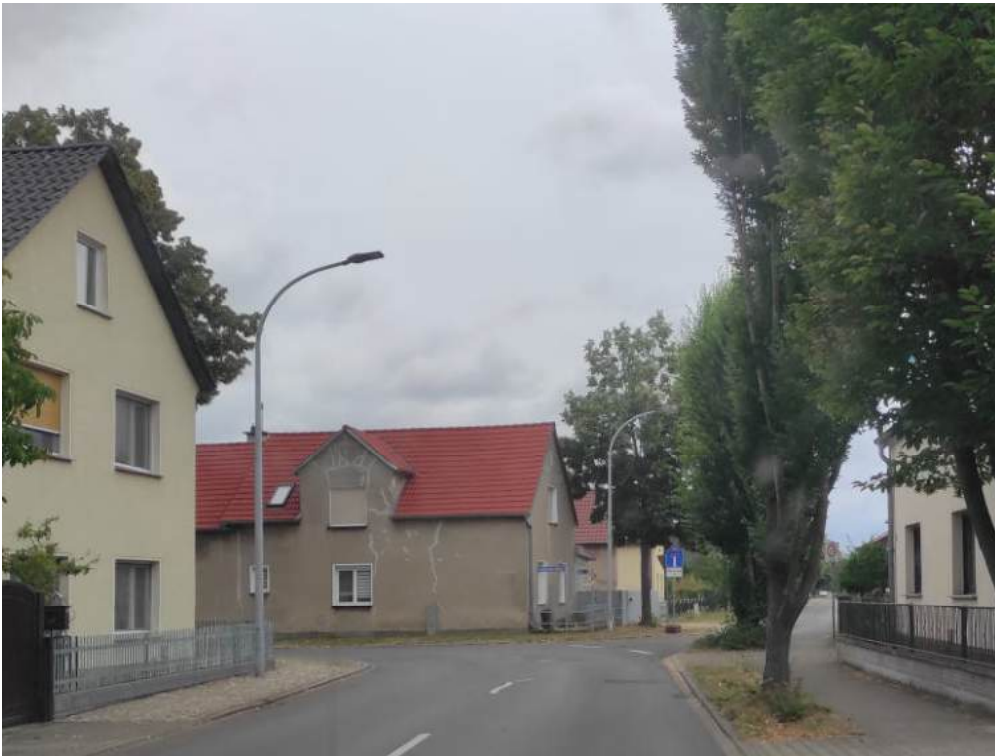
Abbildung 7: Lauchhammer Straße Stat. 0+100,00 Blick in Richtung Teichweg
