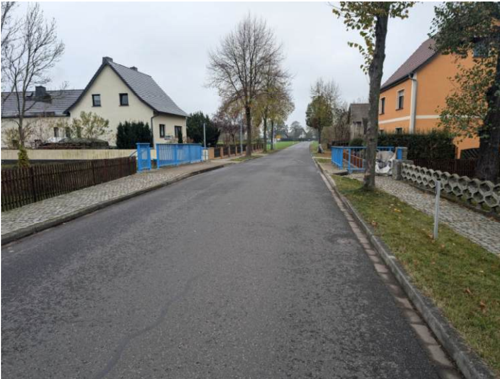
Abbildung 11: Dorfstraße Stat. 0+440,00 Blick in Stationierungsrichtung
