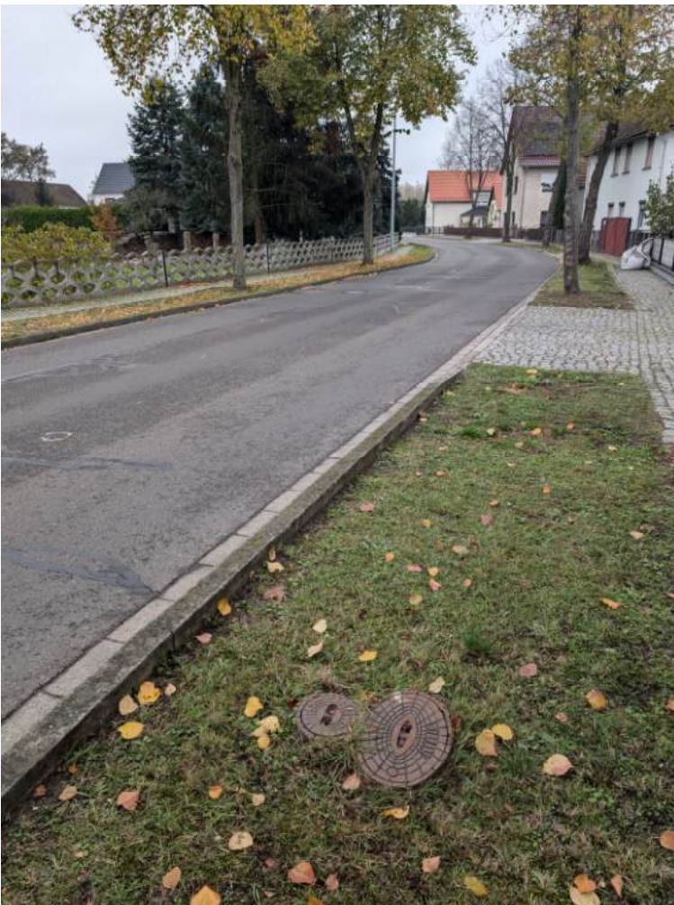
Abbildung 10: Dorfstraße Stat. 0+320,00 Blick in Stationierungsrichtung
