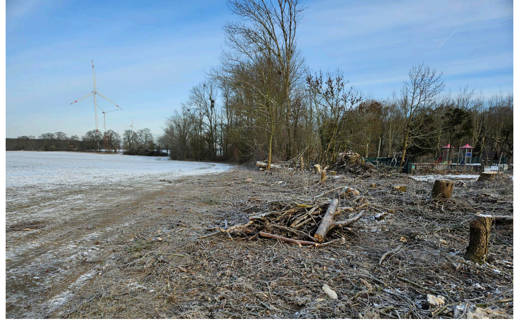
Baugrundstück (Blick Richtung Norden)
