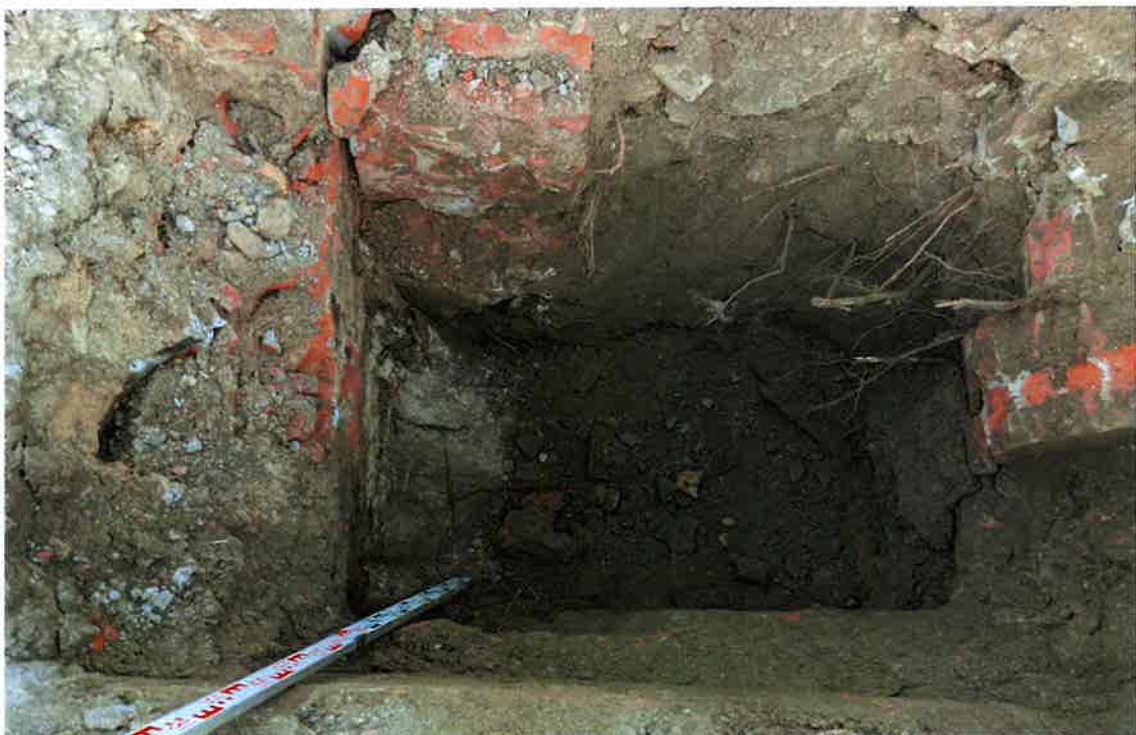
Bild 06: Ansicht Mauerwerk in von Schurf 13/26
