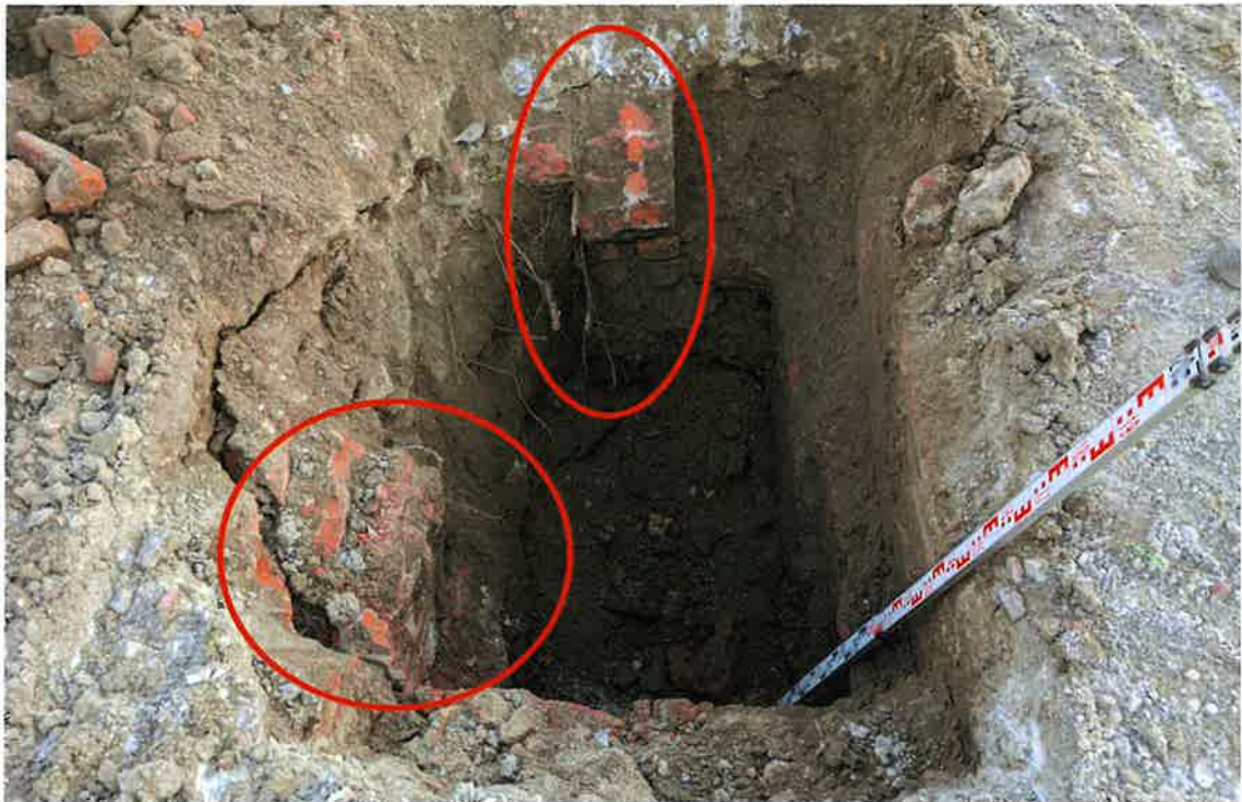
Bild 07: Ansicht Mauerwerk in von Schurf 31/26
