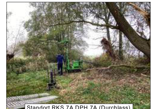
Standort RKS 7A DPH 7A (Durchlass)
