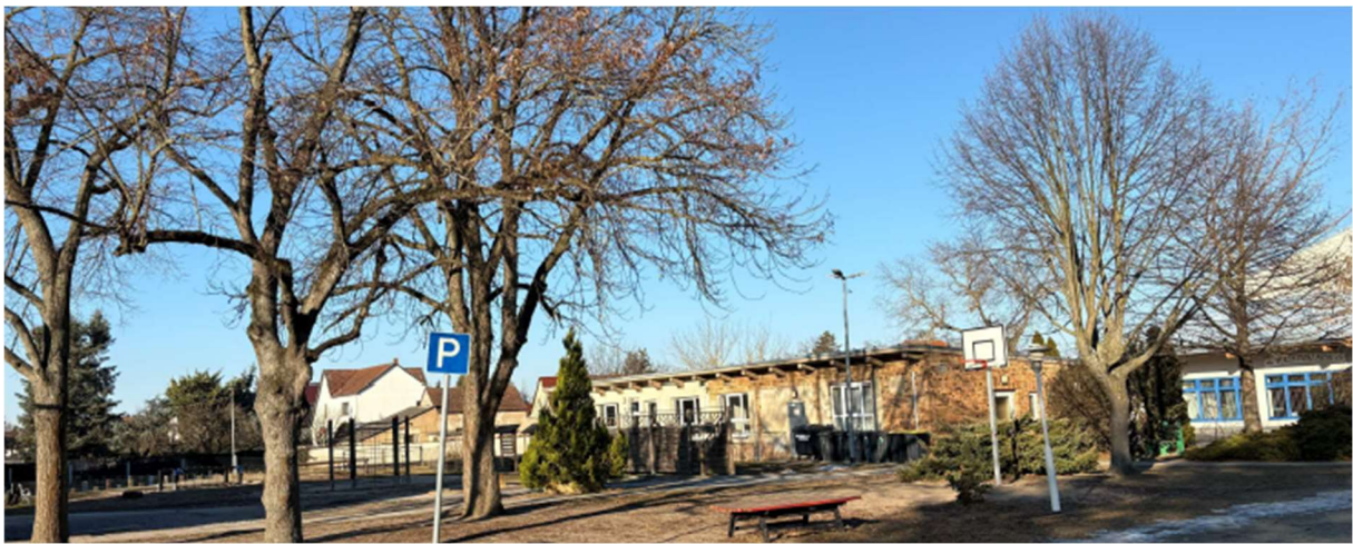
Werkenraum mit Hausmeisterwerkstatt
