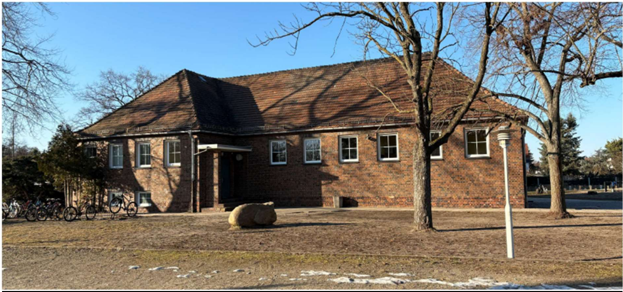
2-Klassen-Grundschulgebäude mit Sekretariat – Ostansicht
