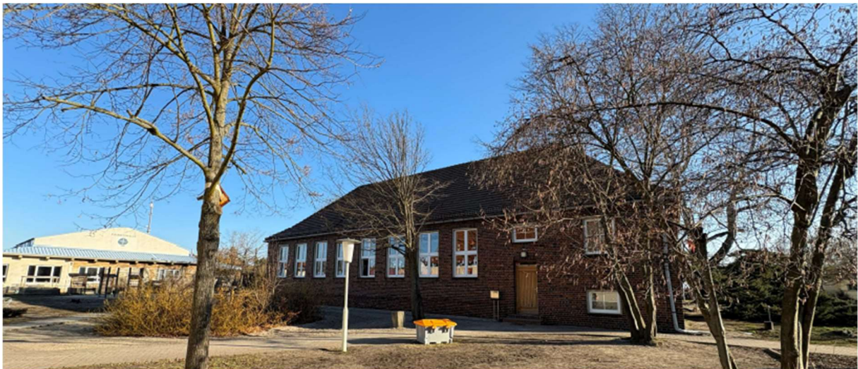
2-Klassen-Grundschulgebäude mit Sekretariat – Westansicht
