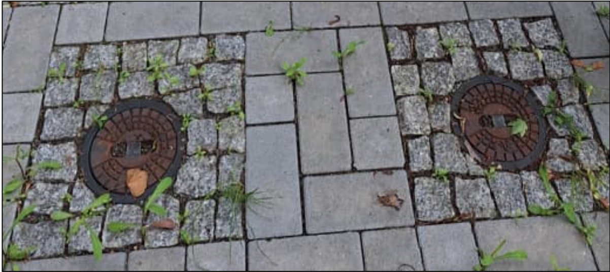
Abbildung 2 – Beispiel für Umpflasterung von Schieberkappen
