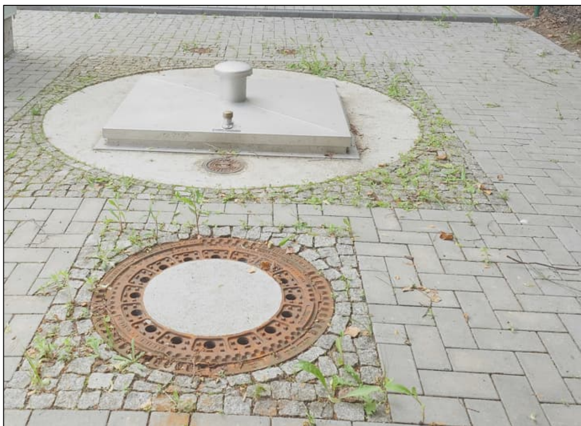
Abbildung 1 - Beispiel Oberflächenherstellung am PW
