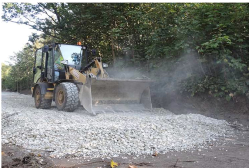
Abb.: Unterbau aus Grobschotter im Vor-Kopf-Einbau
