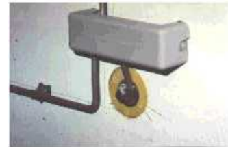
Bild 7: Erdungsfestpunkt für Potentialausgleichschiene
