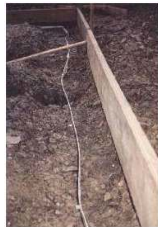
Bild 1: Fundamenterder in unbewehrtem Fundament
