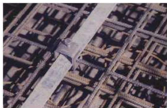
Bild 4: Blitzschutz-Fundamenterder auf Bewehrung
