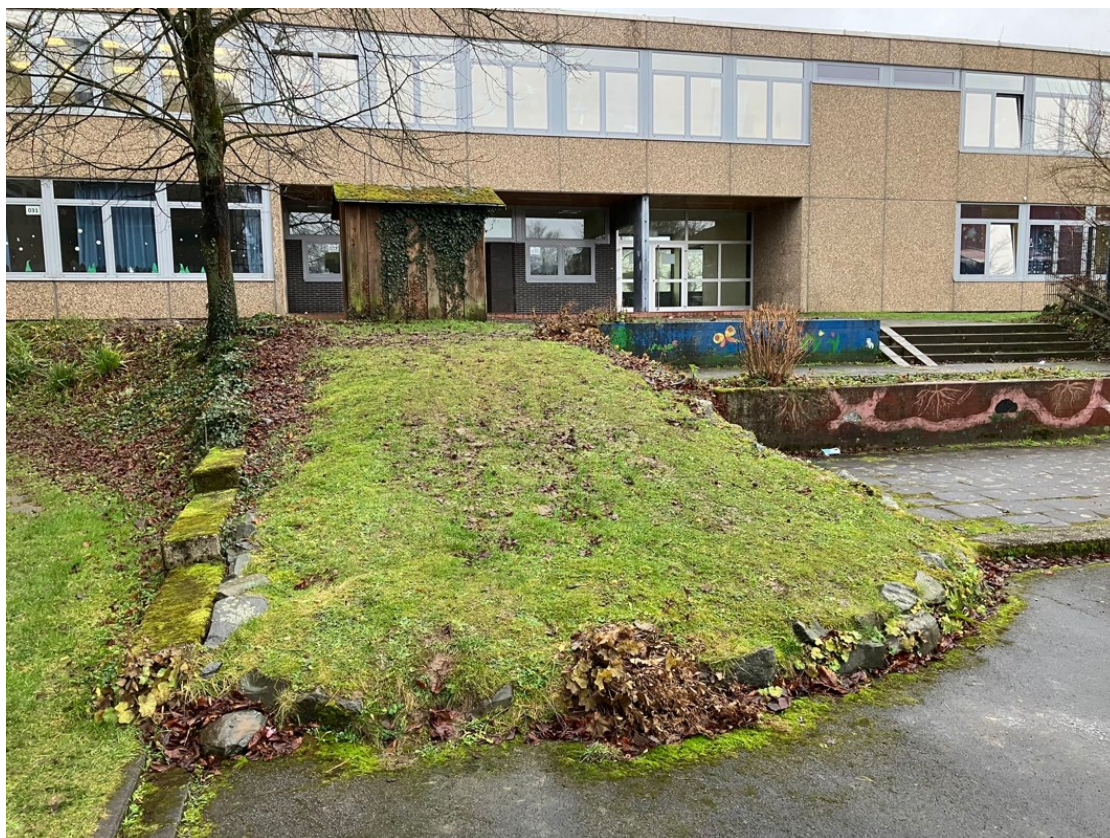
Böschung im Schulhof West wird erweitert/ Betonbeete abgebrochen, Treppe bleibt erhalten
