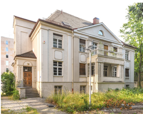
Abb. 6 Gesamtansicht von Südwesten mit regelmäßiger Anordnung identischer Fensterformate
