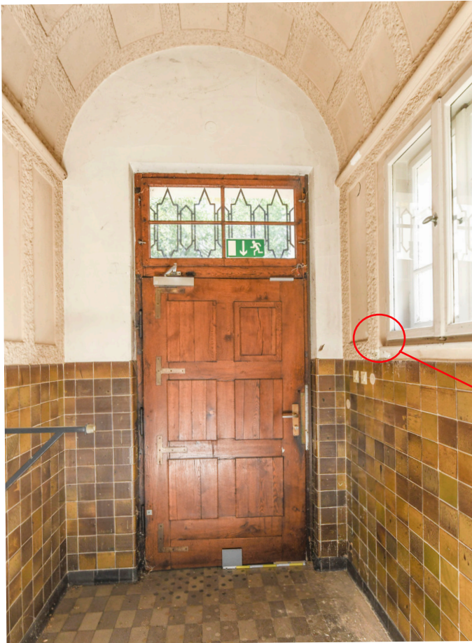
Abb. 12 Windfang, Blick nach Süden Kassettierte Gewölbe- und Wandoberflächen Gefliester Sockel und Boden
