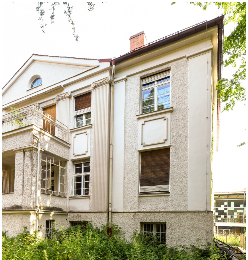
Abb. 5 Ansicht von Südosten Die kannelierten Pilaster des Risalits (links) unterscheiden sich deutlich von den schlichten Formen der anderen Pilaster.
