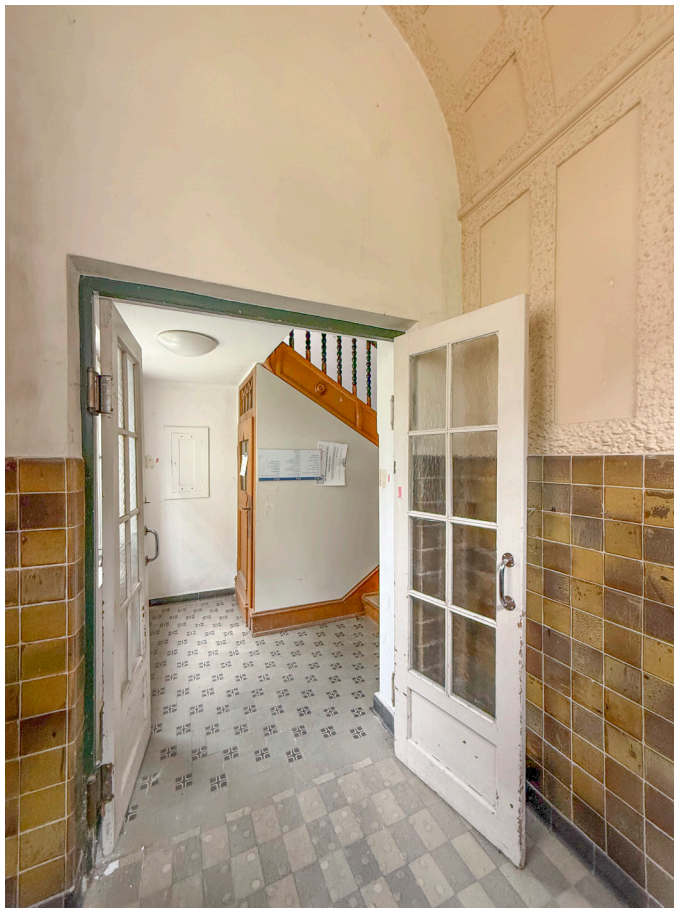
Abb. 14 Windfang, Blick nach Norden Kassettierte Gewölbe- und Wandoberflächen Gefliester Sockel und Boden
