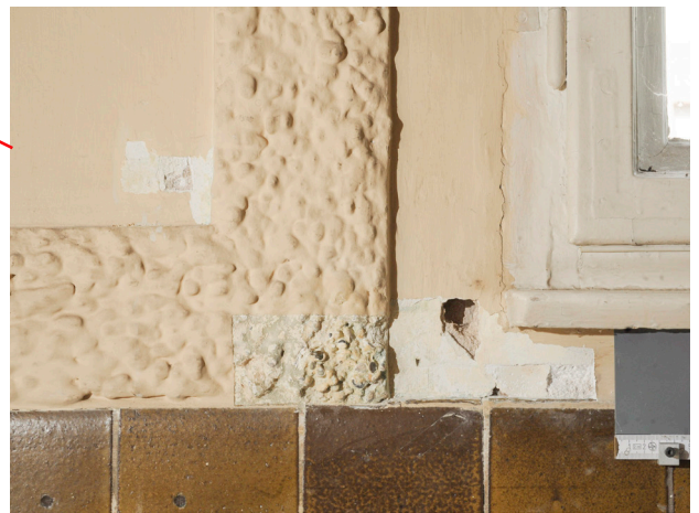
Abb. 13 Detail der Kassettierung Die Rahmen sind mit einem sehr rauen Mörtel (vgl. Fassade) ausgeführt. Sie springen bis zu 15 mm aus der glatten Wandebene vor.
