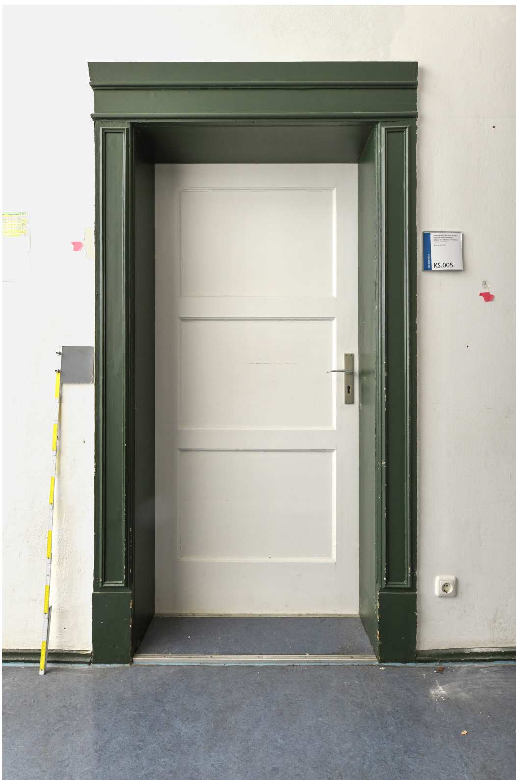
Abb. 24 Raum KS.000a Nordseite
