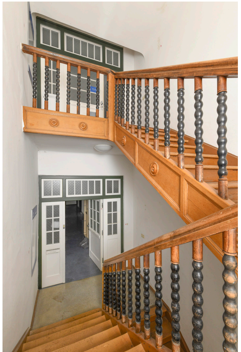
Abb. 16 Treppenlauf vom Geschosspodest des Obergeschosses zum Podest des 1. Dachgeschosses
