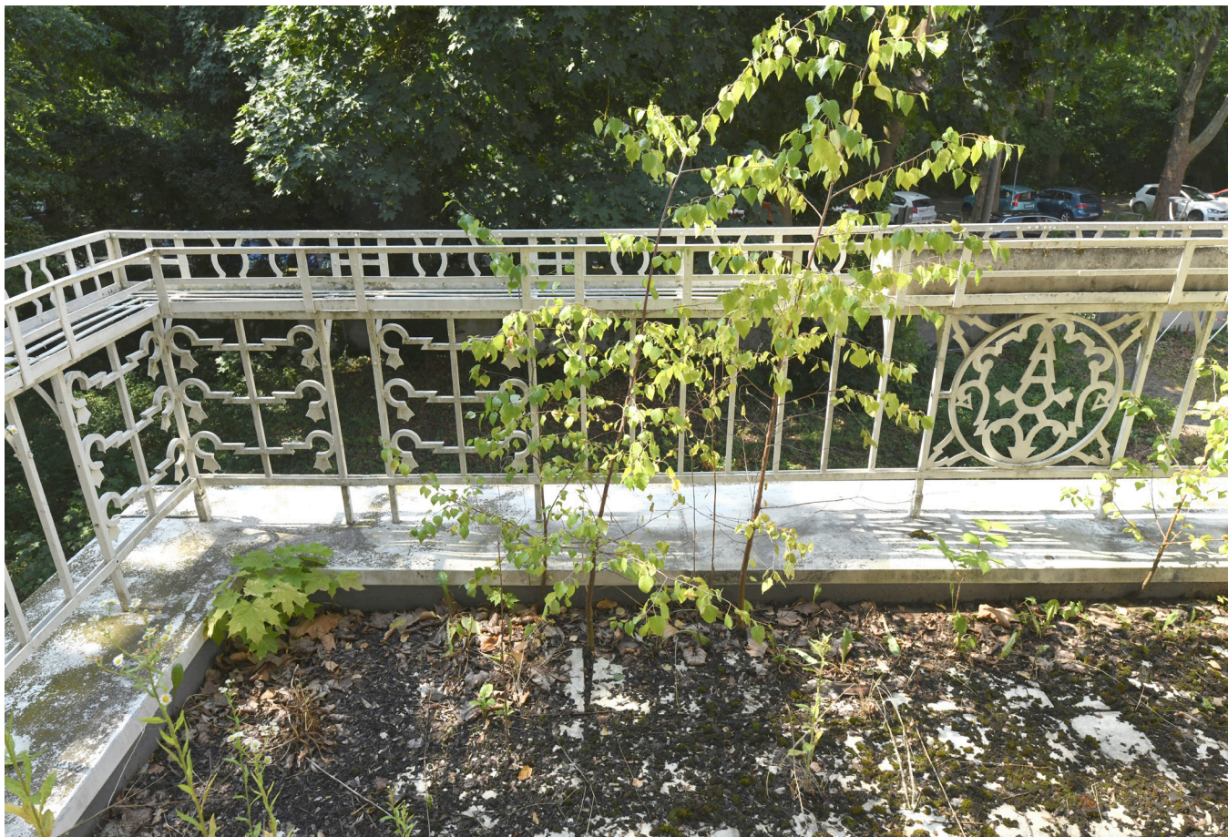
Abb. 27 Obergeschoss, südliche Altane Reich verziertes Terrassen-Geländer
