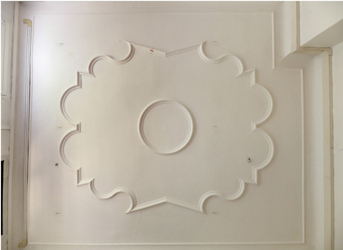
Abb. 17 Stuckdecke mit profilierter Hohlkehle in Raum KS.009
