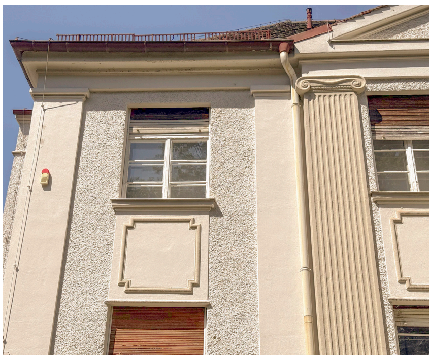
Abb. 10 Südfassade, westliche Hälfte Raue und glatte Oberflächen Im Obergeschoss glatte Brüstungszonen mit stuckierten Rahmen
