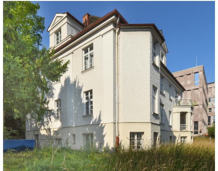
Abb. 7 Ansicht von Nordosten
