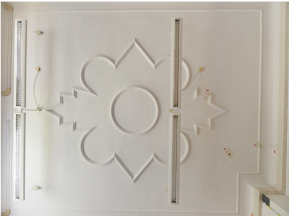
Abb. 18 Stuckdecke mit profilierter Hohlkehle in Raum KS.010
