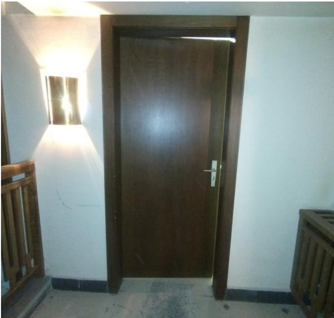
KG, TÜR K03-1: Einflüglige Tür. Türblatt und Bauteile der Zargen aus Eiche furnierter Spanplatte. Profilleisten aus Vollholz Eiche. Abmessungen: B x H =ca. 0,915 x 2,01m
