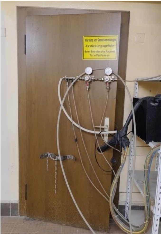
KG, TÜR K03-1: Einflüglige Tür. Türblatt und Bauteile der Zargen aus Eiche furnierter Spanplatte. Profilleisten aus Vollholz Eiche. Abmessungen: B x H =ca. 0,915 x 2,01m
