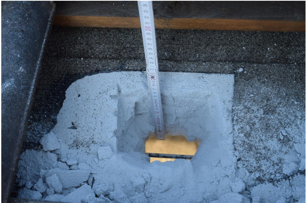
Bild 63: Ansicht Lagerhalle Flussmeisterstelle - Porenbetondecke
