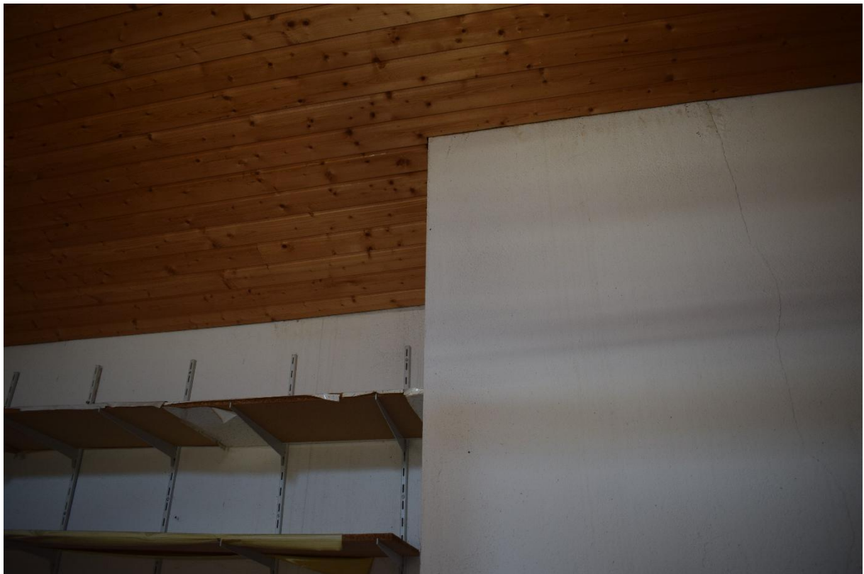
Bild 42: Innenansicht Wohngebäude Dachboden
