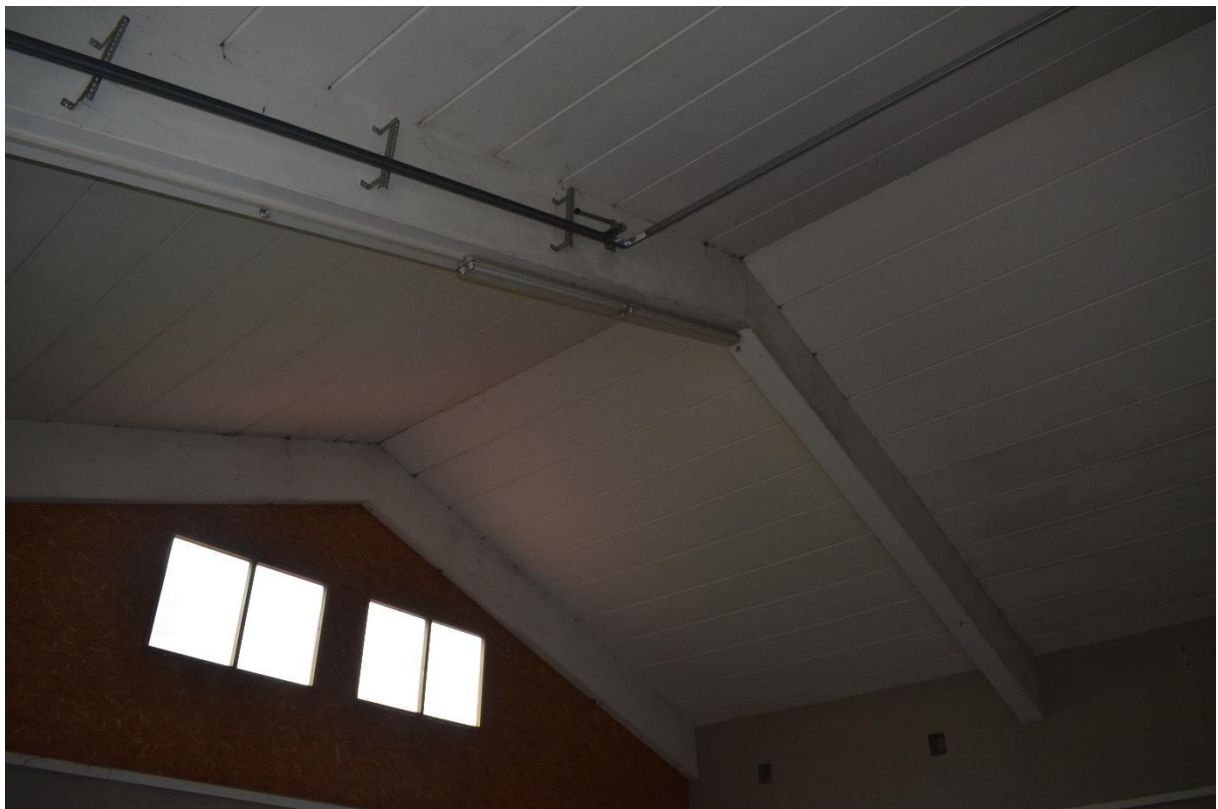
Bild 62: Ansicht Lagerhalle Flussmeisterstelle - Porenbetondecke
