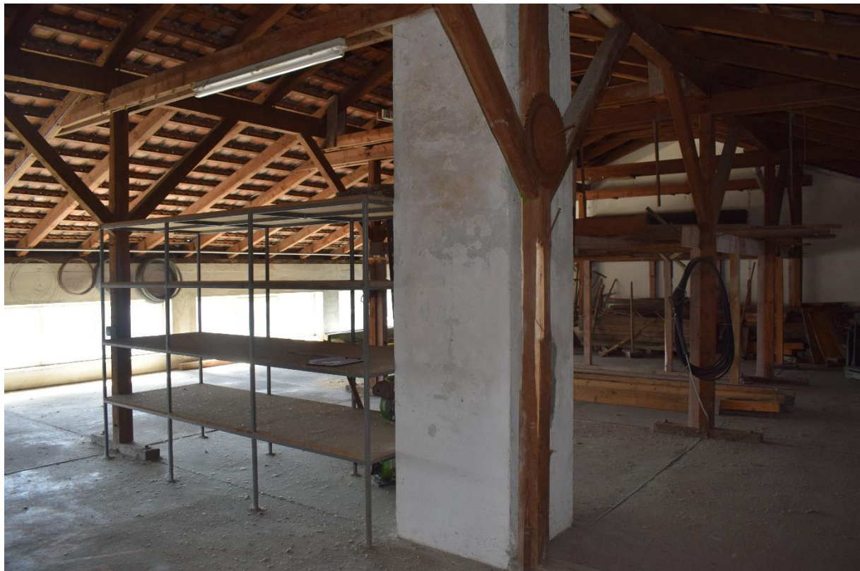
Bild 66: Ansicht Lagerhalle Flussmeisterstelle - Teilausbau Dachboden
