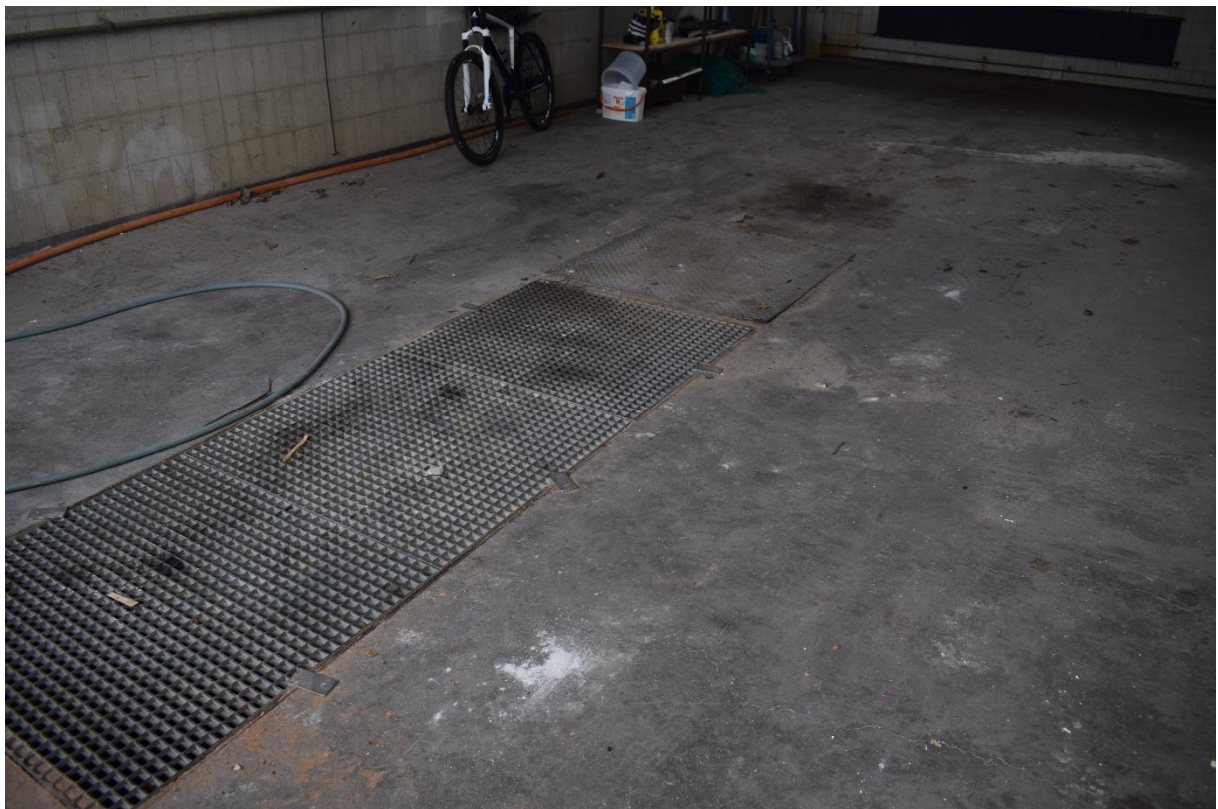
Bild 60: Ansicht Lagerhalle Flussmeisterstelle - Abscheideanlage
