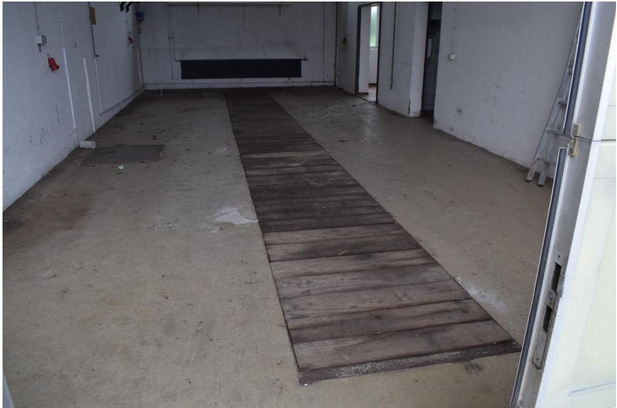
Bild 59: Ansicht Lagerhalle Flussmeisterstelle - Montagegrube
