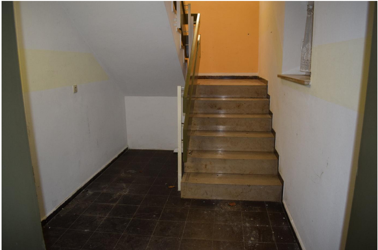
Bild 13: Innenansicht Wohngebäude Flur Keller
