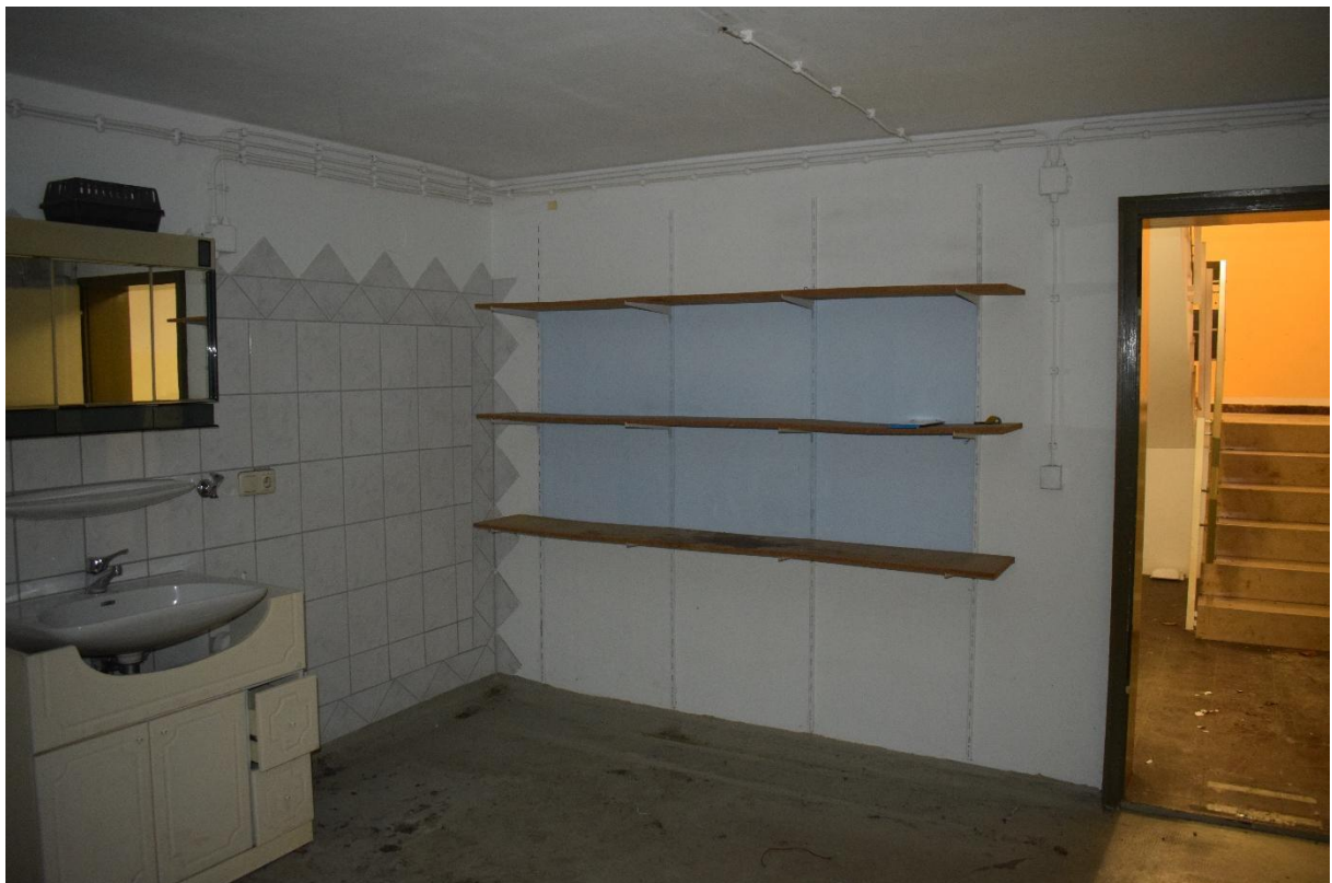
Bild 14: Innenansicht Wohngebäude - Kellerraum
