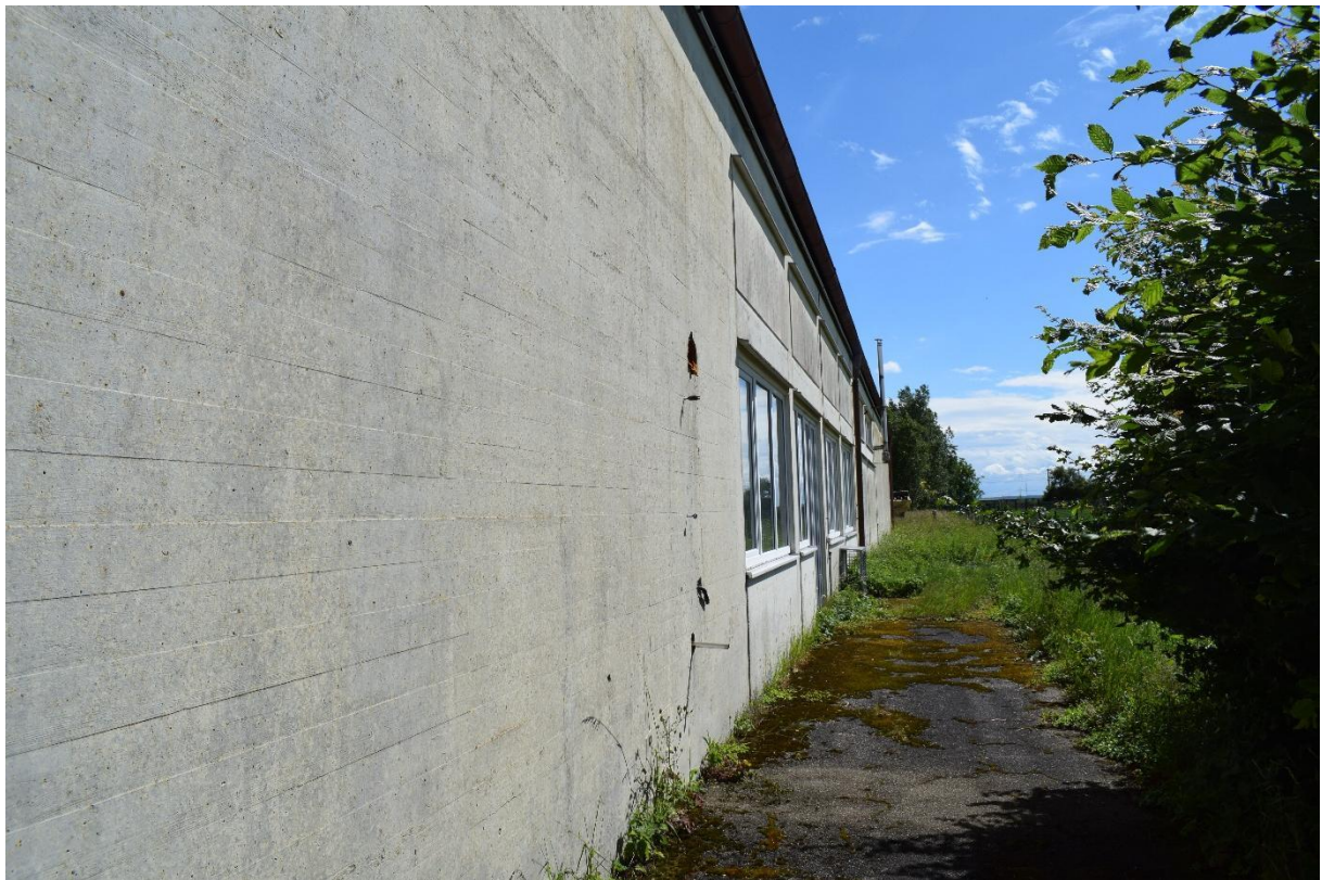
Bild 55: Ansicht Lagerhalle Flussmeisterstelle
