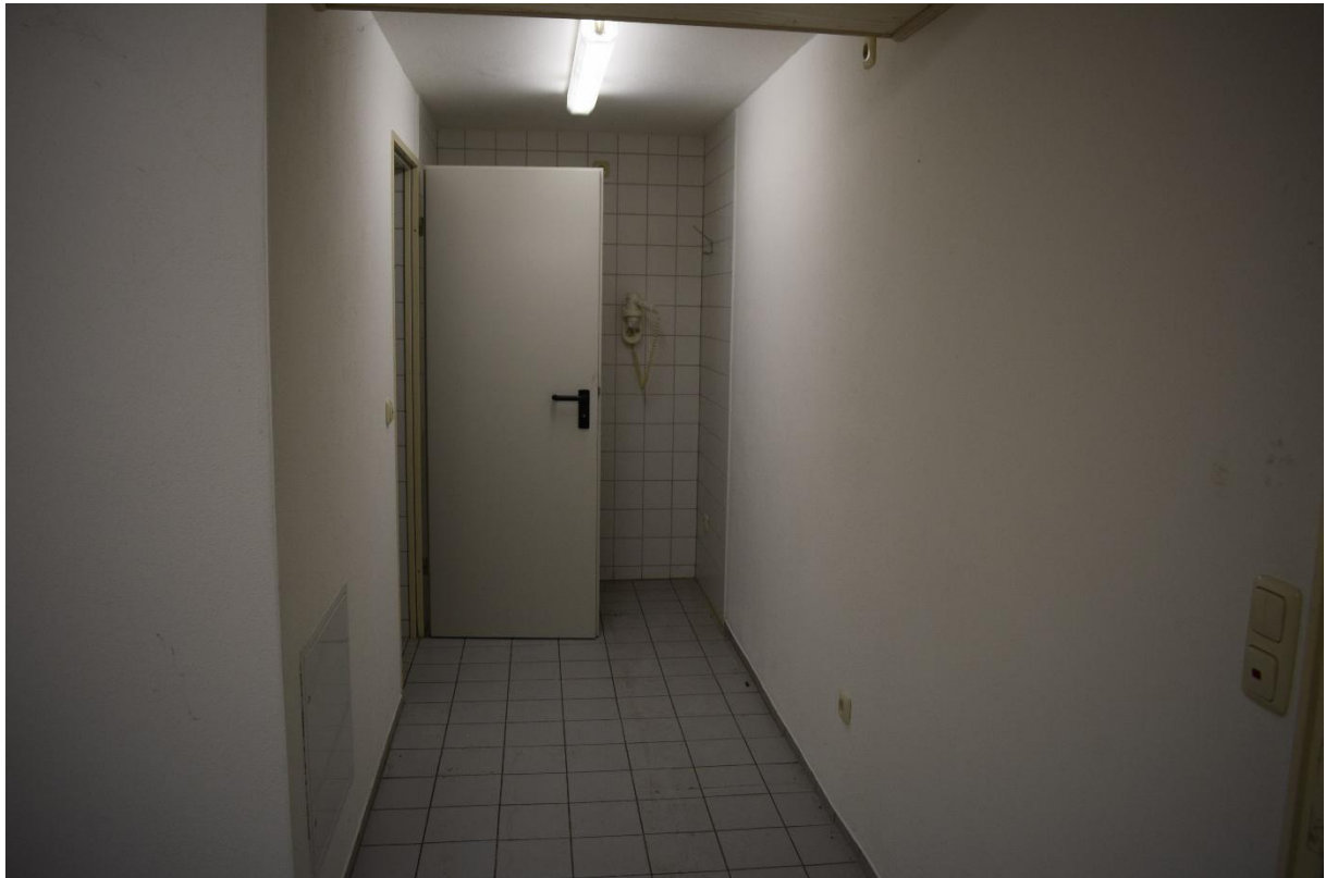
Bild 11: Innenansicht Wohngebäude – Keller Nassbereich
