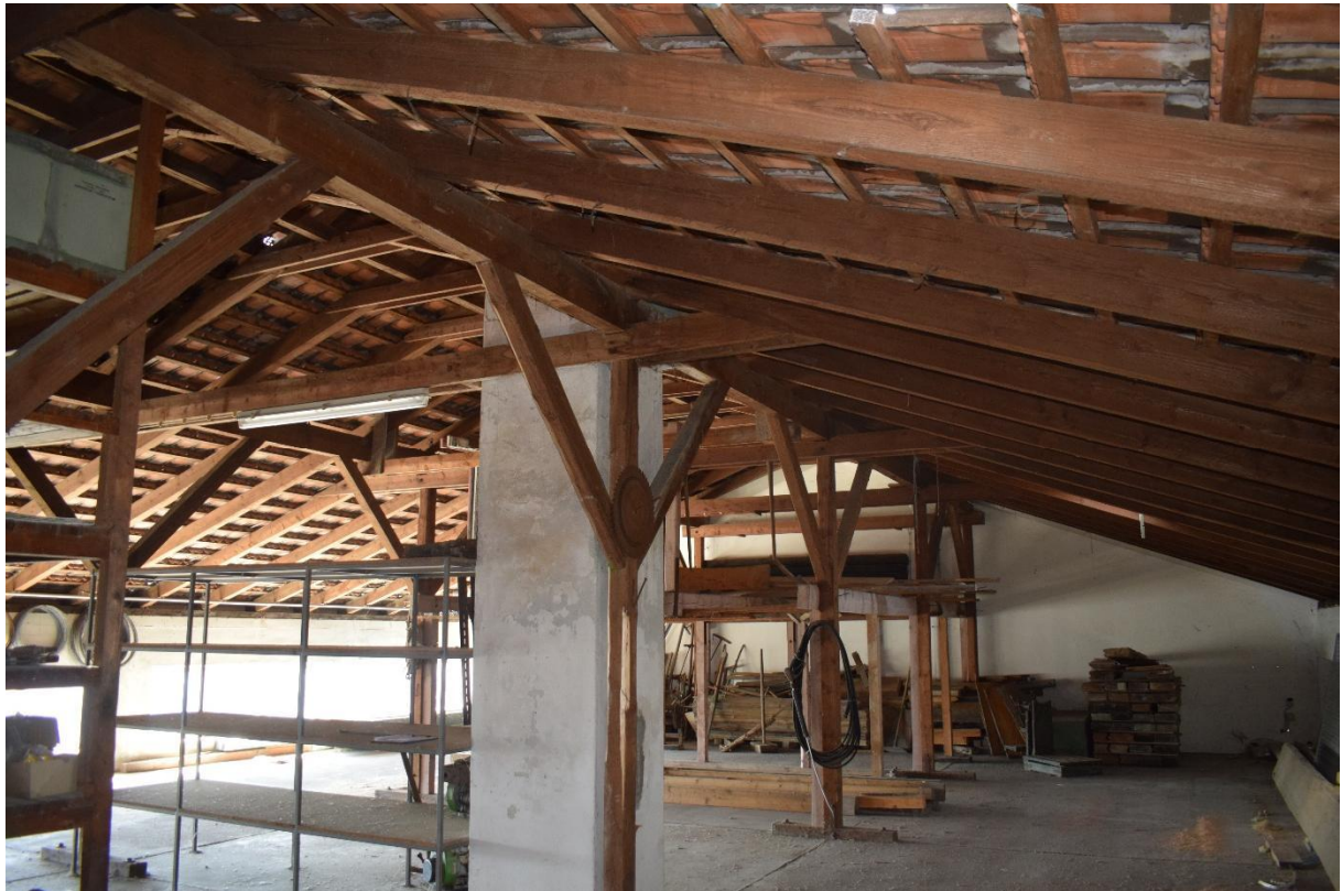
Bild 67: Ansicht Lagerhalle Flussmeisterstelle – Teilausbau Dachboden
