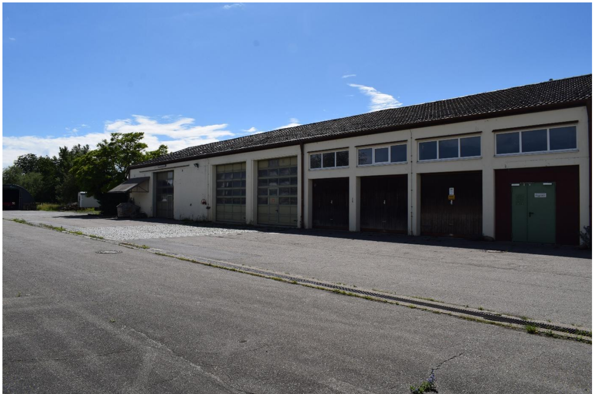
Bild 56: Ansicht Lagerhalle Flussmeisterstelle
