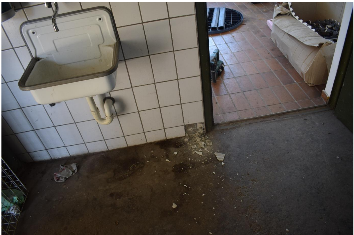
Bild 64: Ansicht Lagerhalle Flussmeisterstelle - Raum
