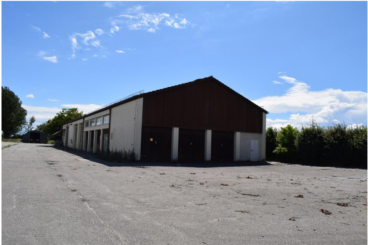
Bild 53: Ansicht Lagerhalle Flussmeisterstelle
