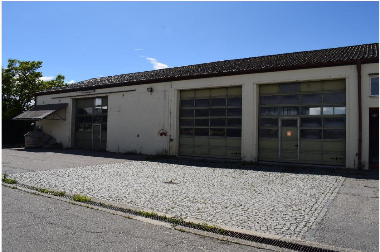
Bild 57: Ansicht Lagerhalle Flussmeisterstelle
