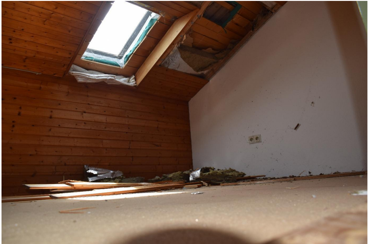
Bild 41: Innenansicht Wohngebäude Dachboden
