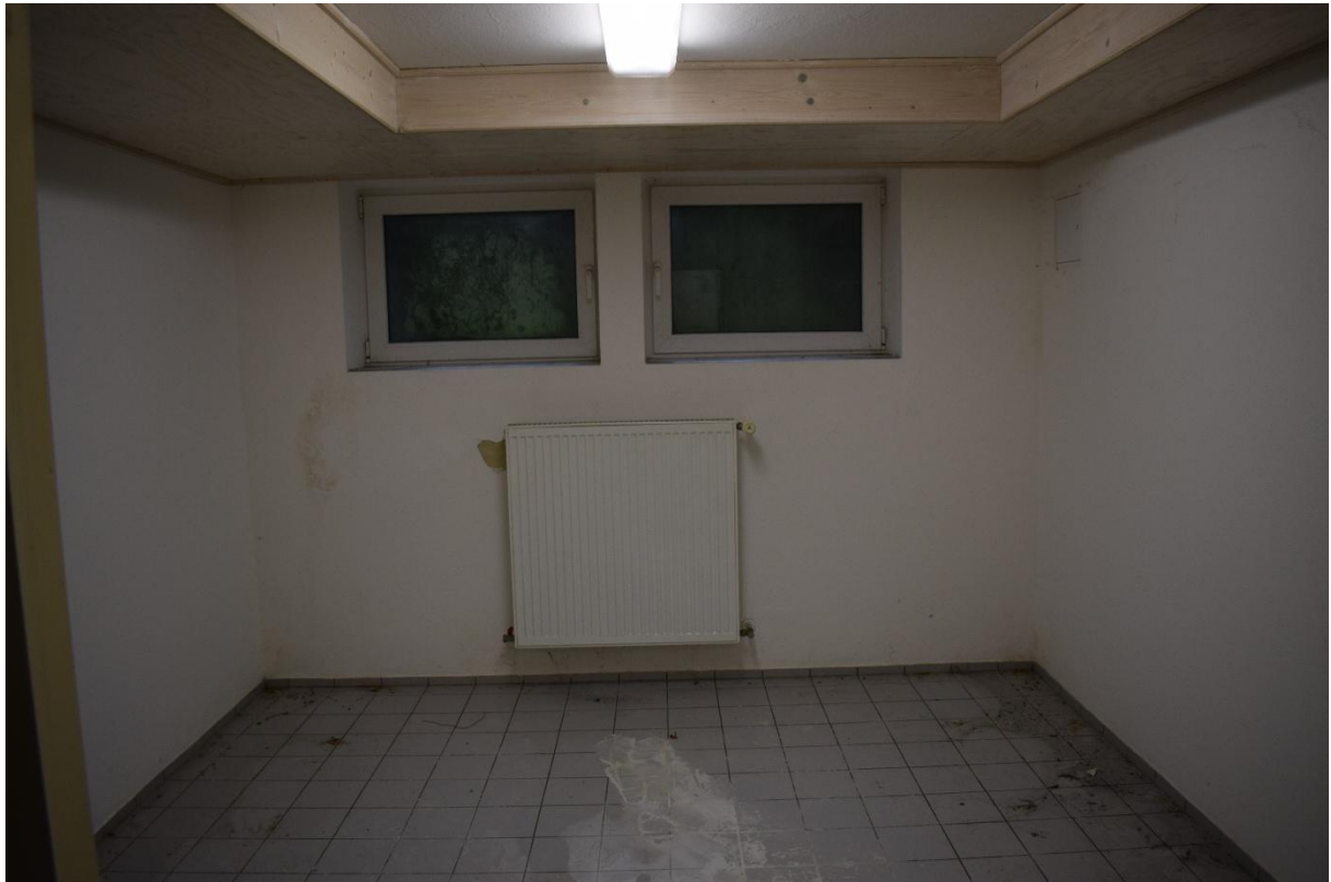
Bild 09: Innenansicht Wohngebäude - Kellerraum
