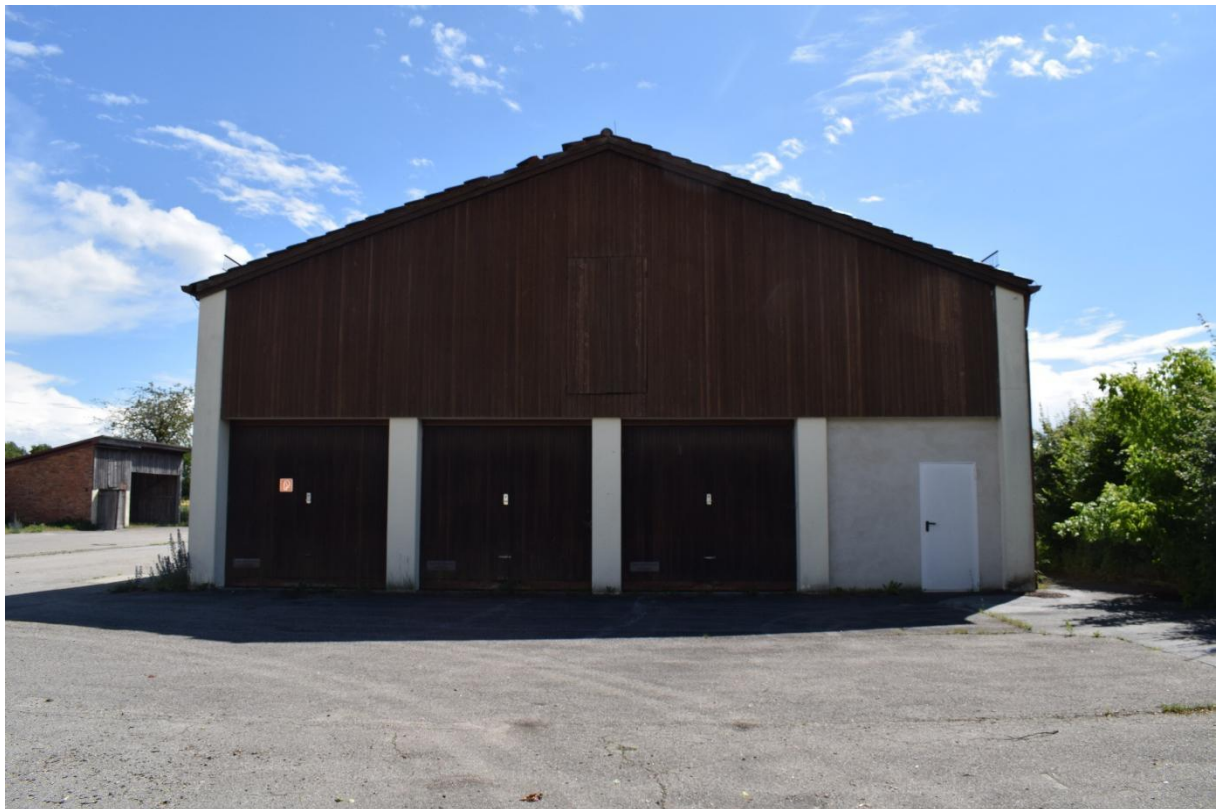
Bild 54: Ansicht Lagerhalle Flussmeisterstelle
