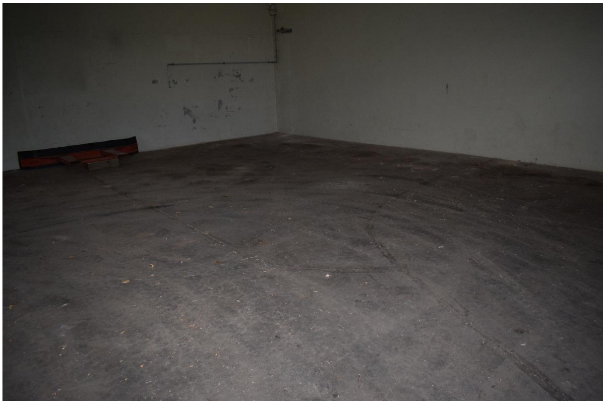
Bild 58: Ansicht Lagerhalle Flussmeisterstelle - Gussasphaltfläche
