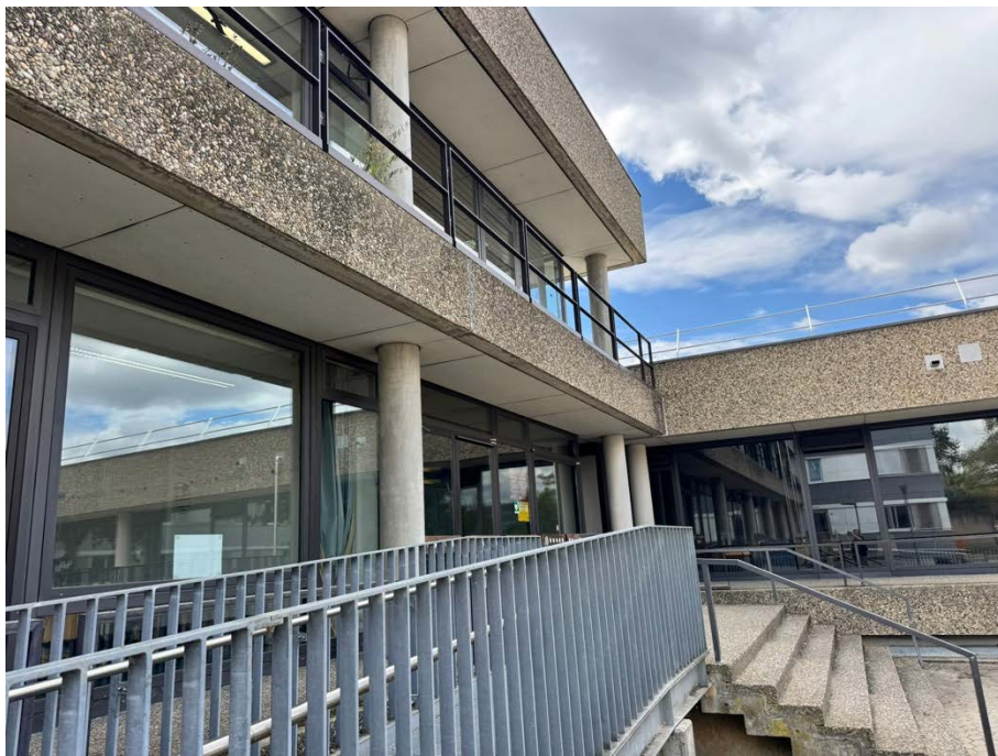
Abbildung 9: Rampe (Demontage + Remontage)
