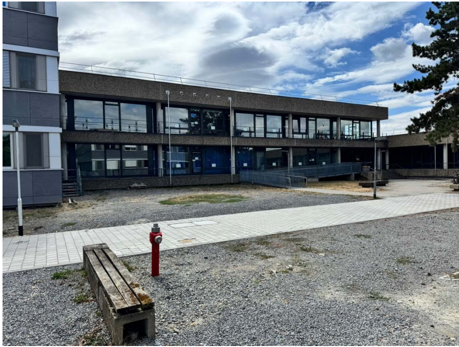
Abbildung 6: Rampe (Demontage + Remontage)
