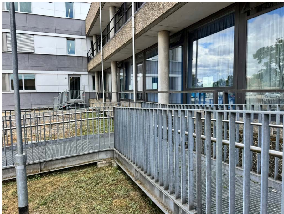
Abbildung 4: Rampe (Demontage + Remontage)
