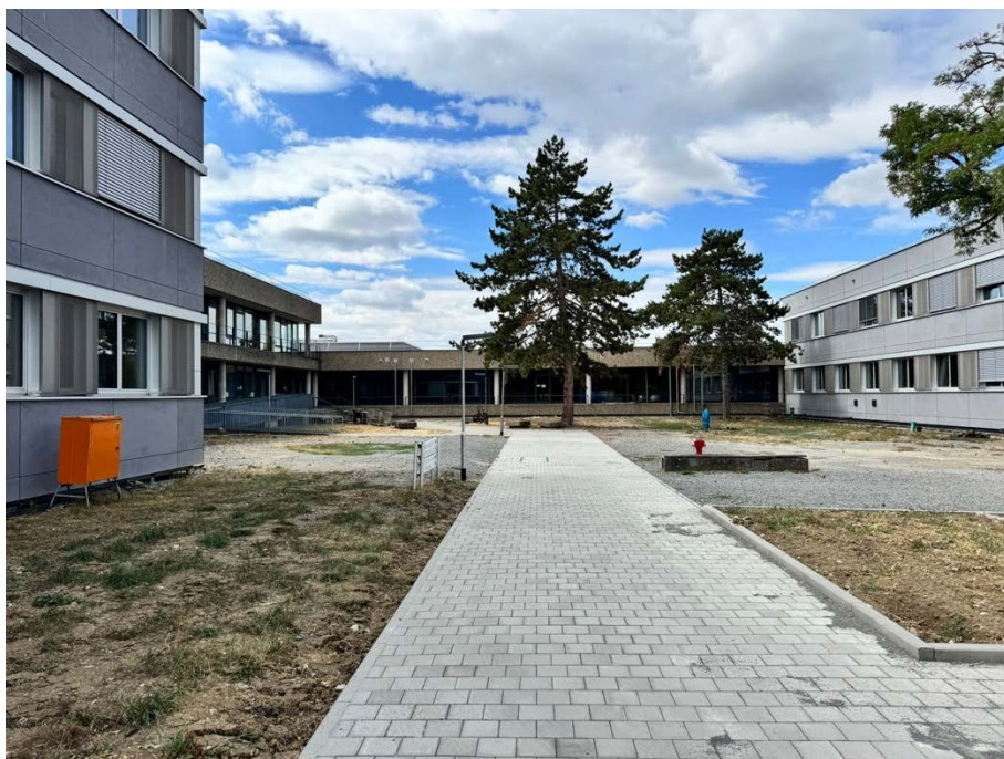
Abbildung 22: Zugang Bauteil 3 UG
