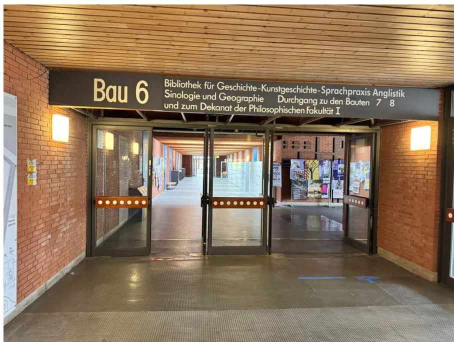
Abbildung 16: Zugang Bauteil 3 zu Bauteil 6
