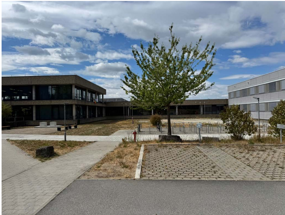
Abbildung 19: Fläche Baustelleneinrichtung Bauteil 2 / 3
