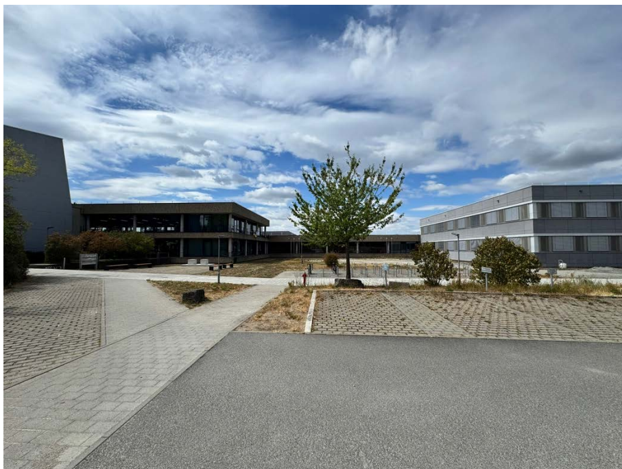
Abbildung 20: Fläche Baustelleneinrichtung Bauteil 2 / 3
