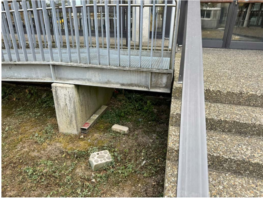
Abbildung 12: Rampe (Demontage + Remontage)
