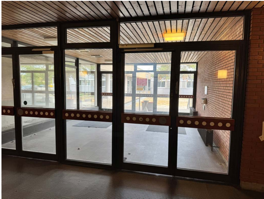
Abbildung 15: Zugang Bauteil 3 (Baustellenzugang UG)
