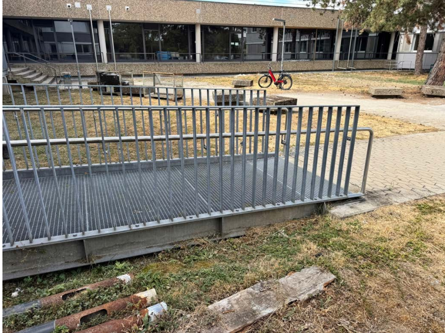
Abbildung 1: Rampe (Demontage + Remontage)
