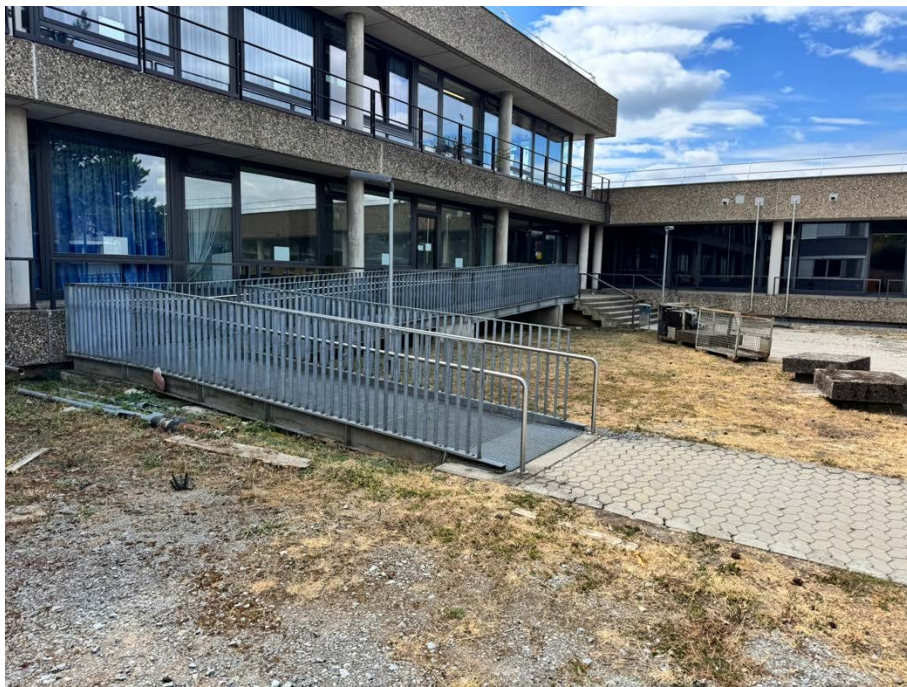
Abbildung 11: Rampe (Demontage + Remontage)
