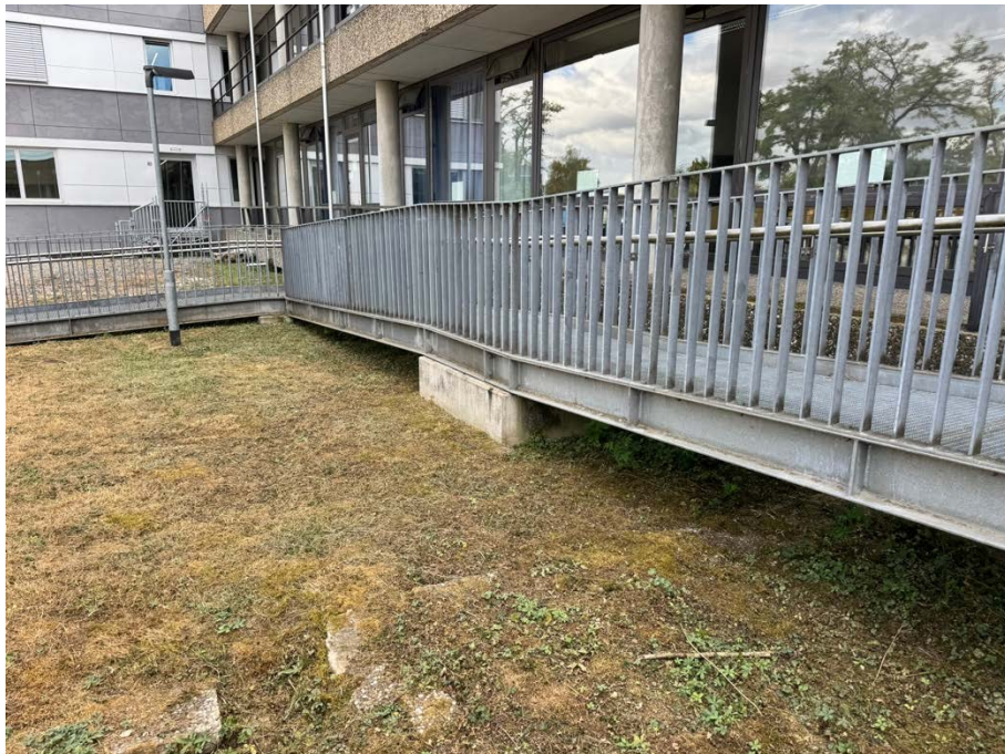
Abbildung 2: Rampe (Demontage + Remontage)
