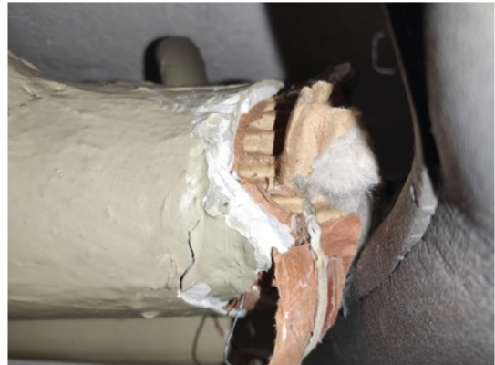
Abbildung 16: Gipsummantelung mit KMF
