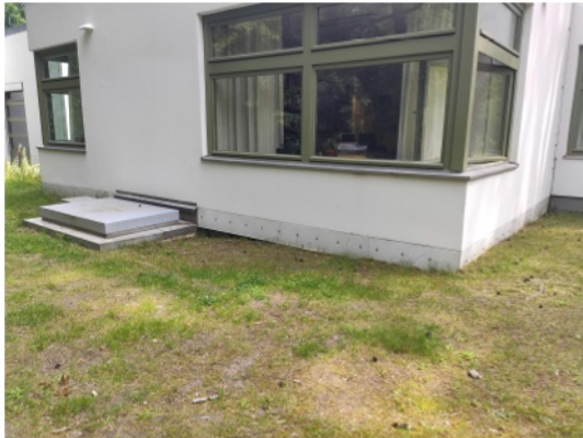
Abbildung 25: Bereich mit Sperrschicht
