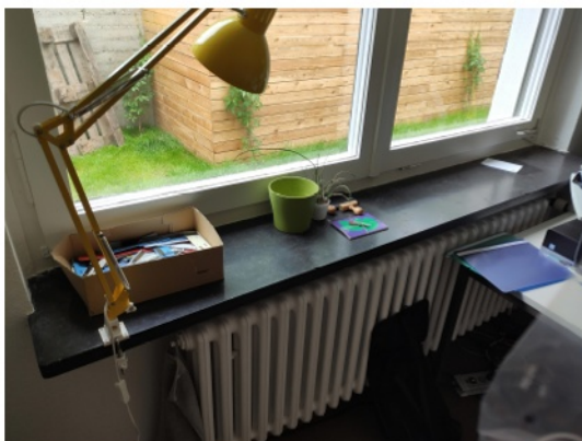
Abbildung 28: Fensterbank mit Asbest
