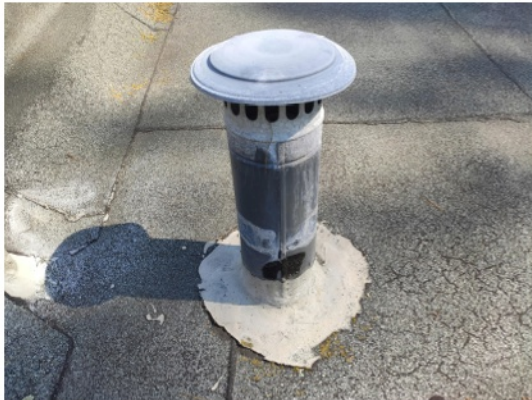
Abbildung 5: Entlüftungshaube
