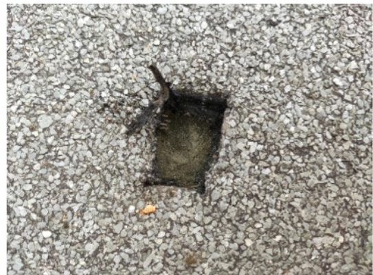
Abbildung 28: Dachpappe und Foamglas
