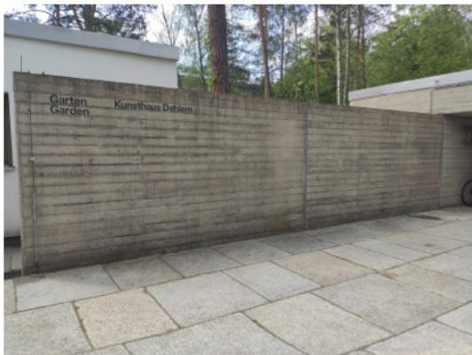
Abbildung 21: Sichtbetonwand
