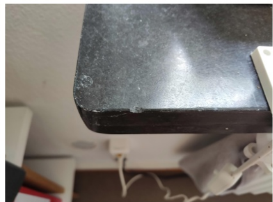
Abbildung 29: Fensterband mit Asbest nah
