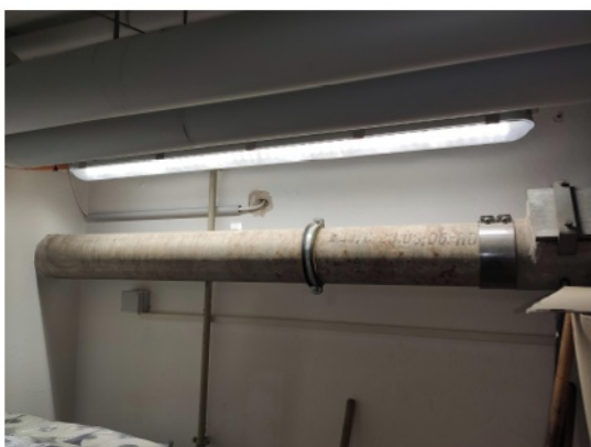
Abbildung 19: Asbestzementrohr
