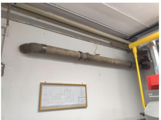
Abbildung 20: Asbestzementrohr 2
