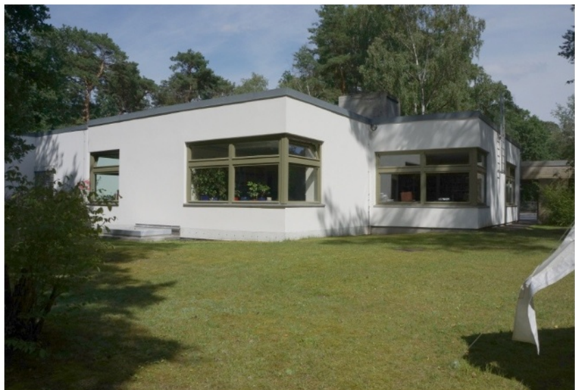
Abb. 5: Ansicht von Nordwesten mit Erwei- terungsbau, 2017.
