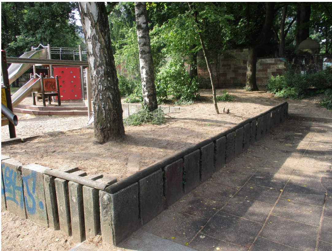
Abb.5 Baumbeeteinfassung (Rückbau Halbrundholz)
