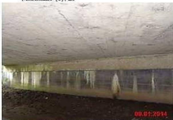
3649001 0 14E ZUSTAND DES VORDEREN WIDERLAGERS
