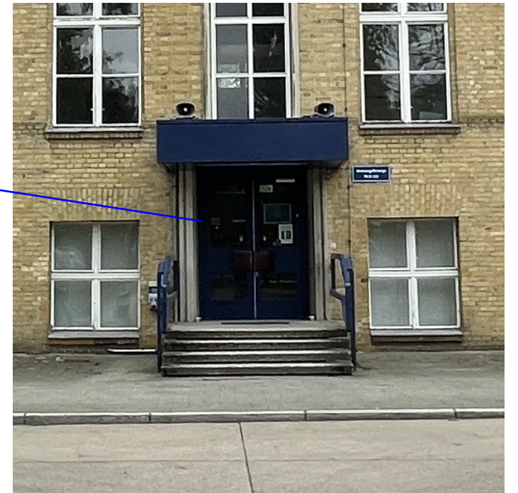
Einbauort Eingangstür Nord
