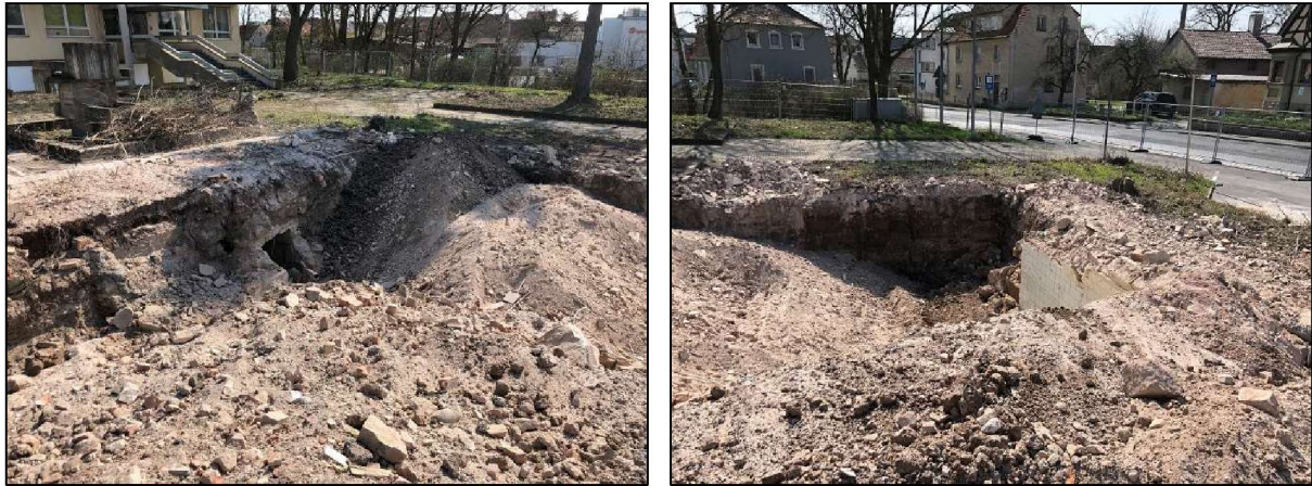
Abbildung 3: Fotos während des Rückbaus des historischen Eingangsgebäudes des Kreiskrankenhauses vom 01.04.2019 [Dokumentation Abriss].
