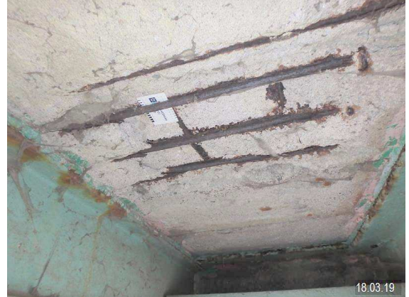
3446219_0_19E_ABPLATZ MIT FREIL BEWEHRUNG
