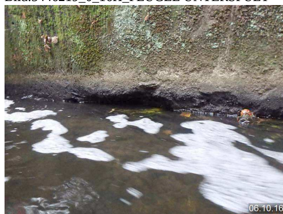
3446219_0_16H_FLÜGEL UNTERSPILT
