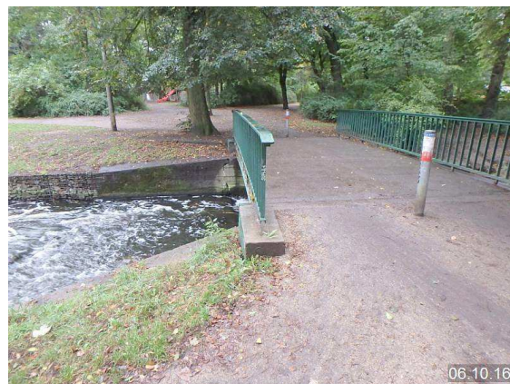
3446219_0_16H_FEHLEN ANSCHLUSSGELÄNDER
