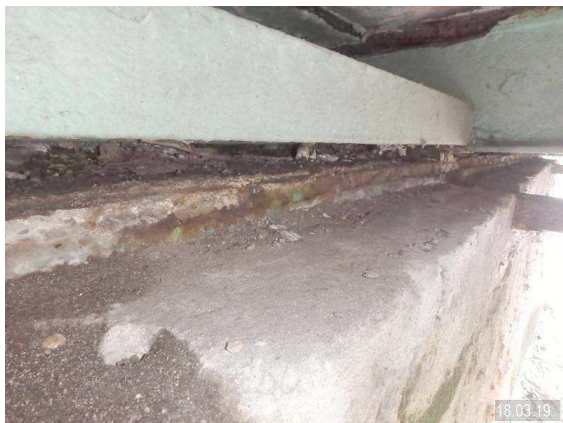
3446219_0_19E_LAGERUNG VERROSTET
