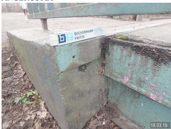
3446219_0_19E_KANTENSCHUTZWINKEL ANGEROSTET
