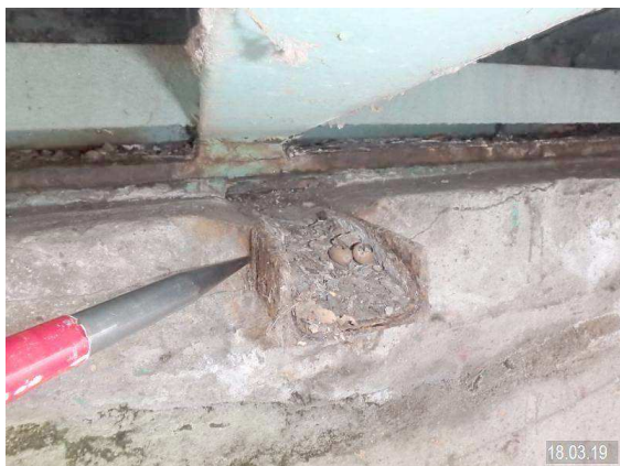
3446219_0_19E_ENTWÄSSERUNGSRINNE VERROSTET
