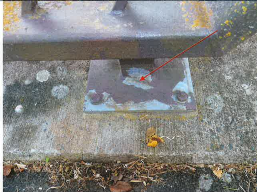
Bild 10 Beschichtung am östlichen Geländer (Probe P2)
