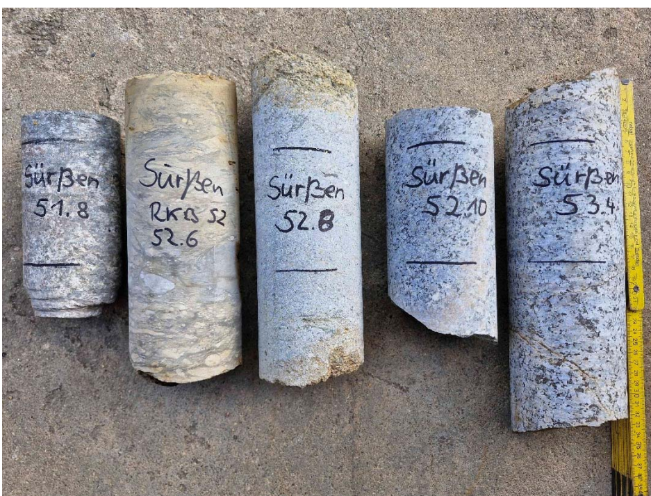
Bild 4: K 8768 Sürßen – Stützwand, Bohrkern für Druckfestigkeitsprüfung
