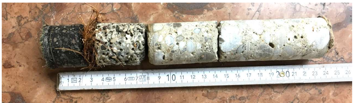
Foto 7: Bohrkern Bk2, links befindet sich die Oberseite
