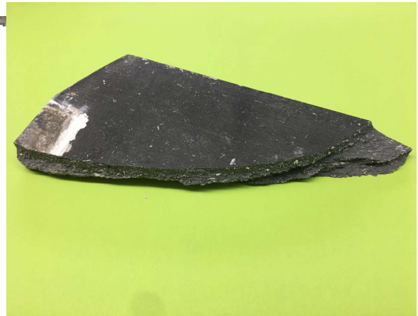
Foto 16: Probe 5 „Bruchstück Fensterbank“
