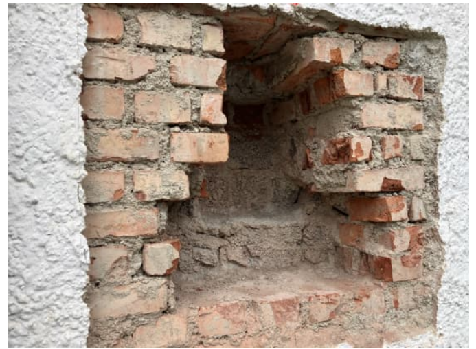
Wandöffnung bei Mauerwerkswand
