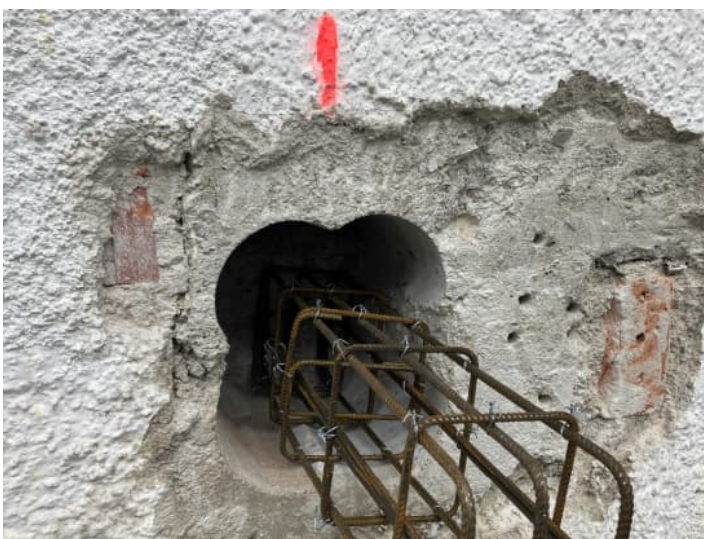
Bei Betonwand (kein Querriegel nötig!)
