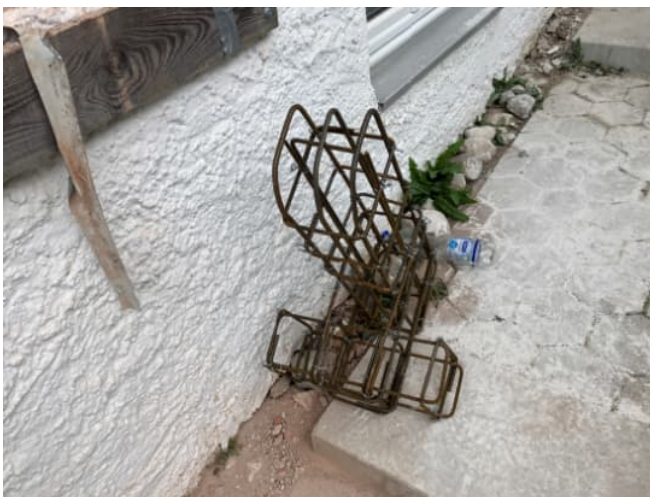
Bewehrung mit Querriegel
