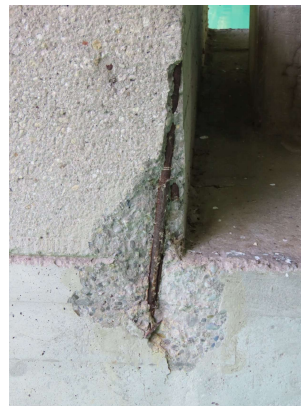
86_2023 PFILER 1 ECKABPLATZUNG MIT BEWEHRUNG
