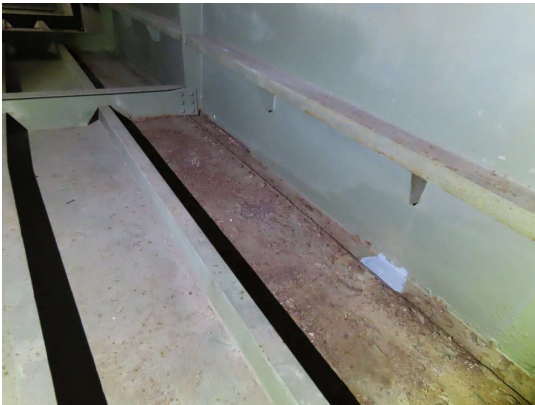
44_2023 BODENBLECHE GROßFLÄCHIG KORRODIERT
