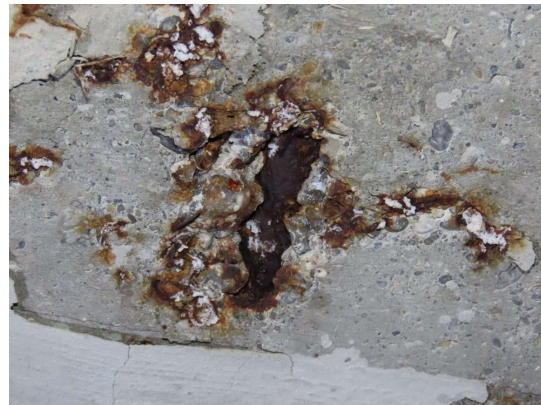
70_2023 FELD 3 INNEN FAHRBAHNPLATTE
