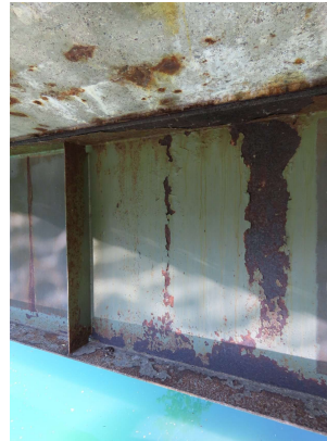
26_2023 STEGBLECH KORRODIERT
