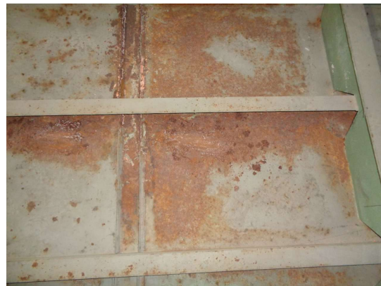
HP2017_KORRODIERTE QUERSTEGE
