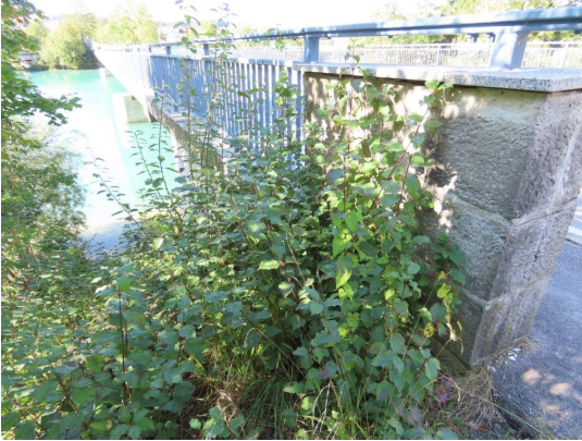
137_2023 BÖSCHUNG BEREICHSWEISE BEWACHSEN
