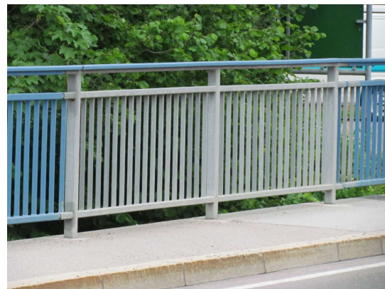
BESCHICHTUNG GELÄNDER NORDOST
