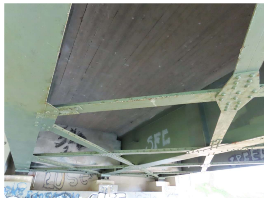
21_2023 DIAGONALSTREBEN KORRODIERT
