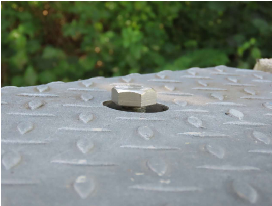
134_2023 KAPPE ABDECKBLECH SCHRAUBE GELÖST
