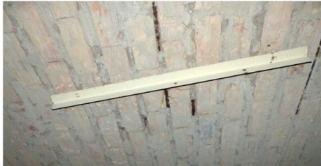
Foto 9: Bewehrungsstäbe teilweise freiliegend
