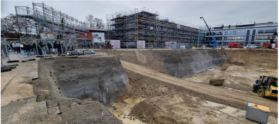
Bild 1: Baustand Realschule Dezember 2025, mit Fußgängerbrücke zur OGTS/Containerschule und Baugrube BS1
