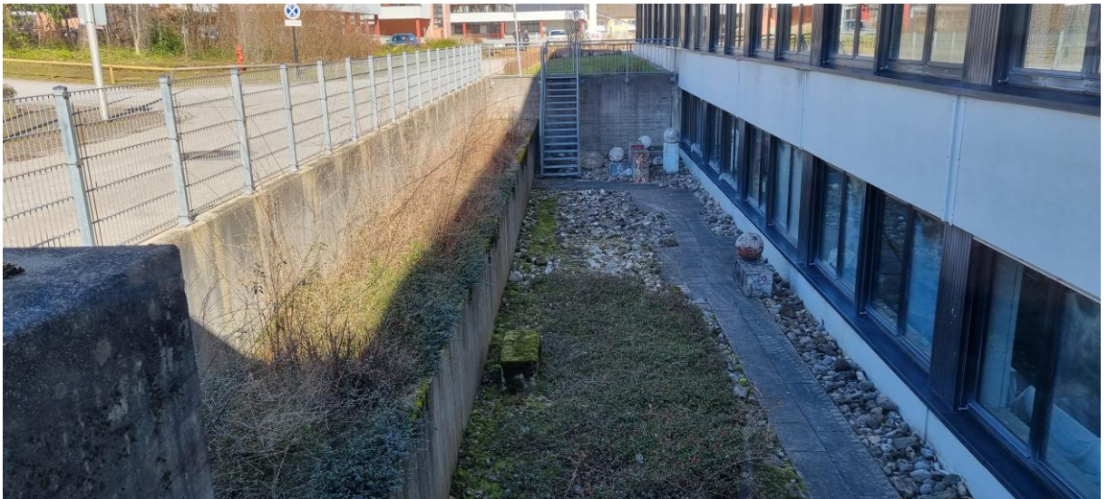
Bild 2: bestehender Lichtgraben Westseite wird neu gestaltet. Hier ein Bild vor der Baumaßnahme
