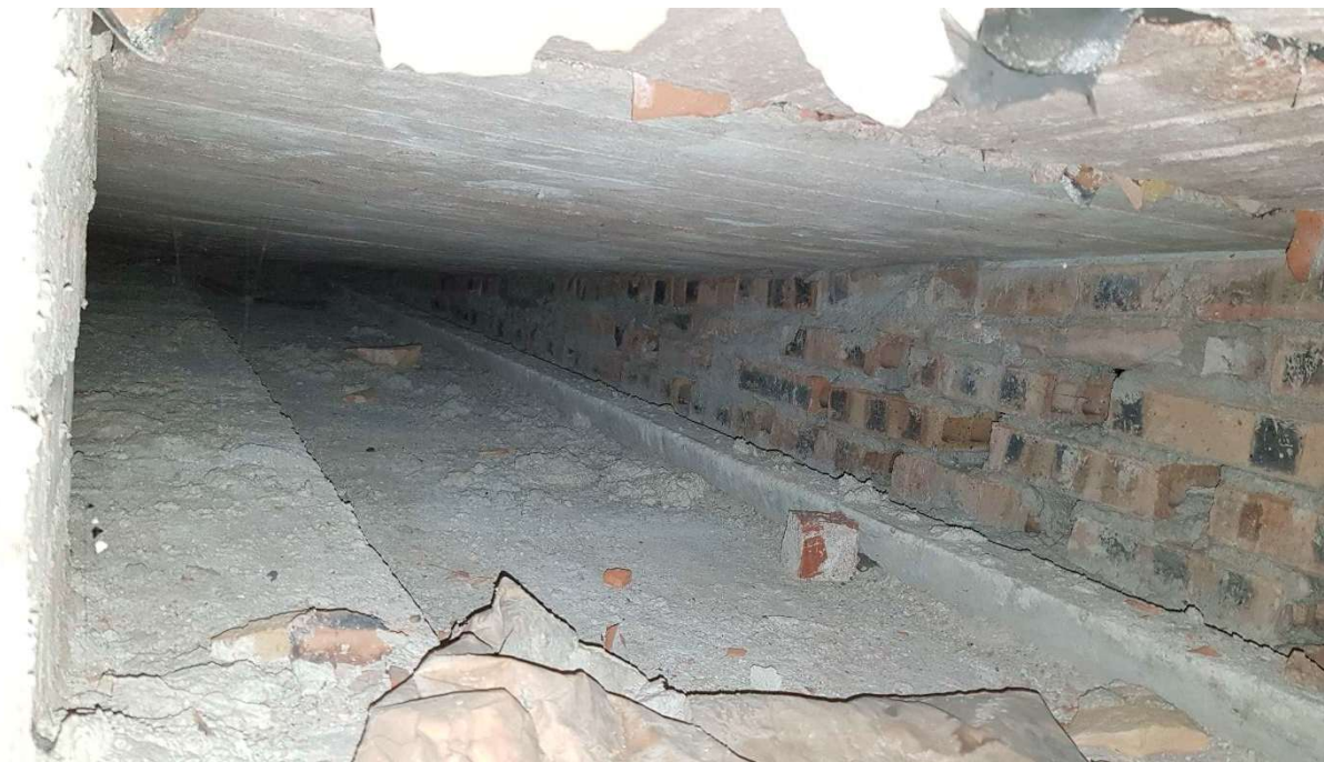
Blick in den geöffneten Dachraum
