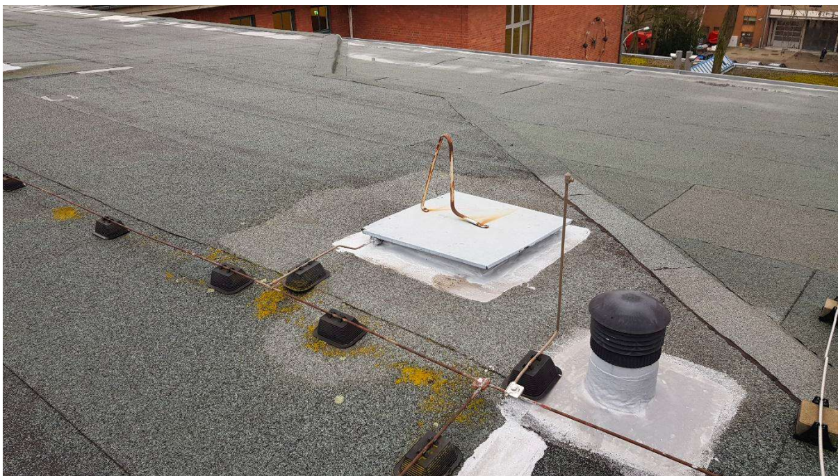
Zugang über Dachluke
