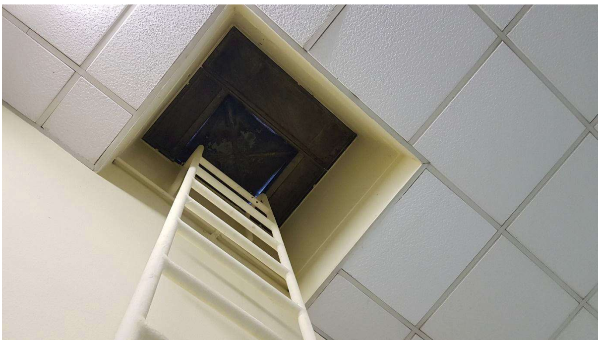
Zugang Dachluke im Innenbereich
