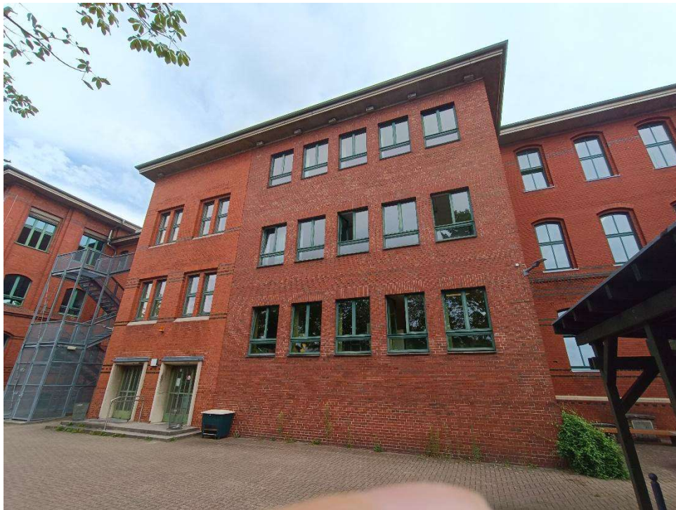
Westfassade – Nebeneingänge mit Fluchttreppe
