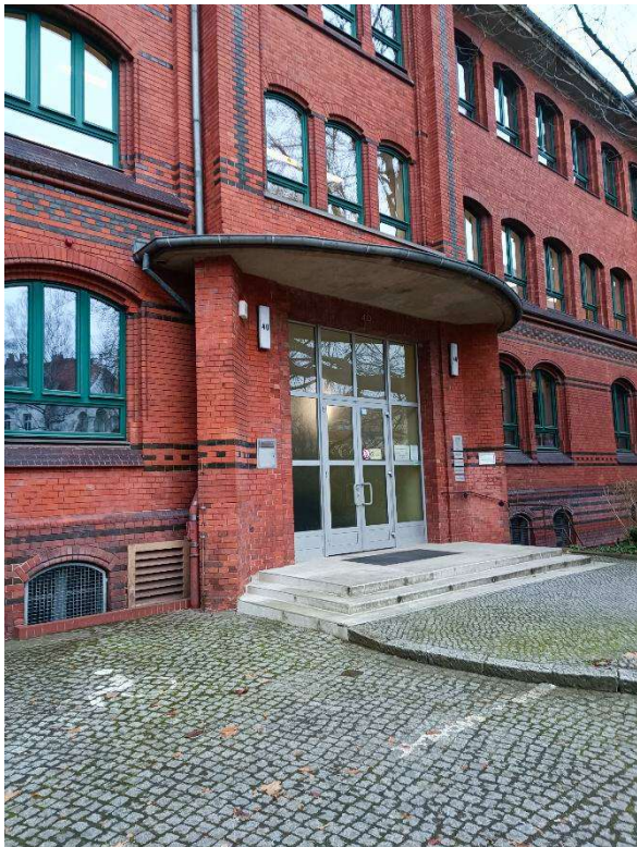
T.EG.001 Bestand Straßenseite
