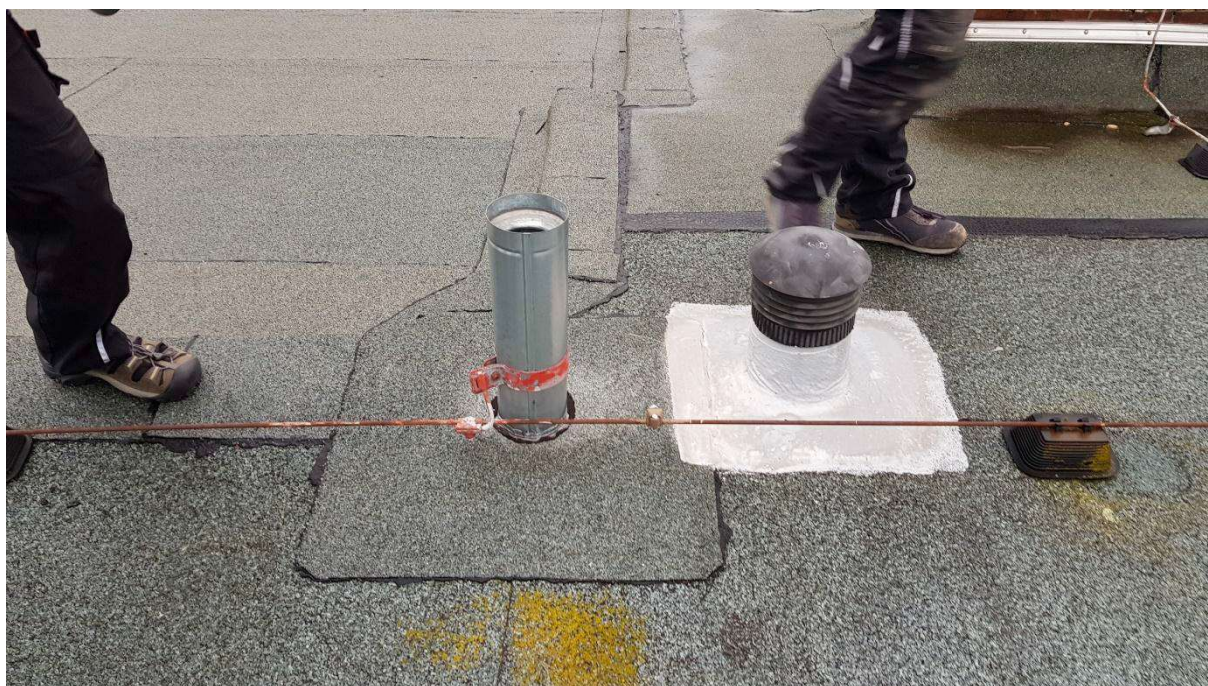
Belüftung für Dachraum und Dachaufbau
