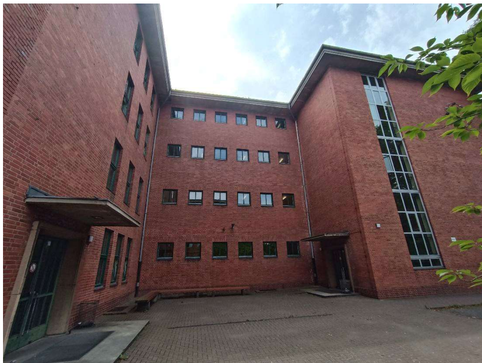
Nordfassade - Innenhof Westseite
