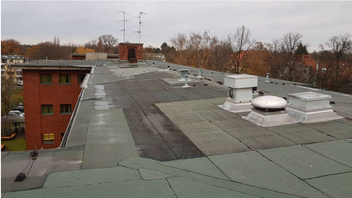
Teil der Dachfläche
