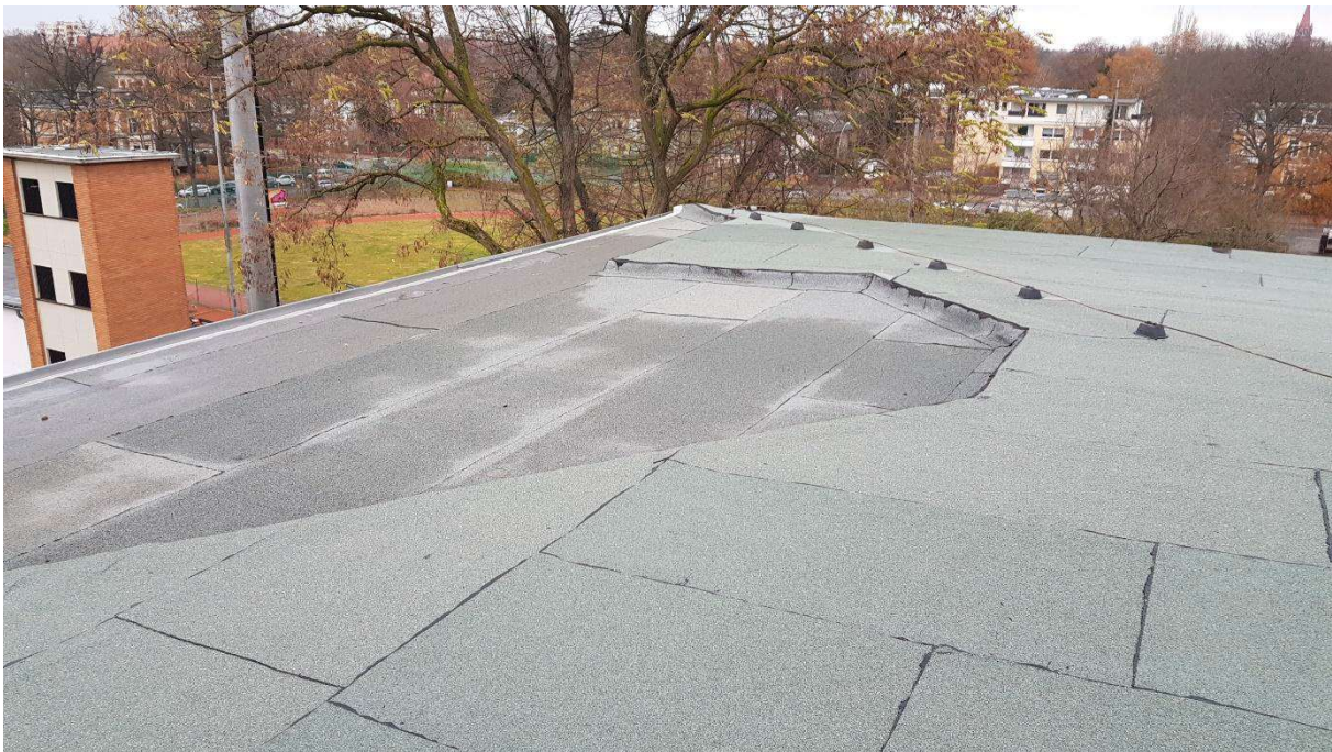
Sanierung nach Sturmschaden
