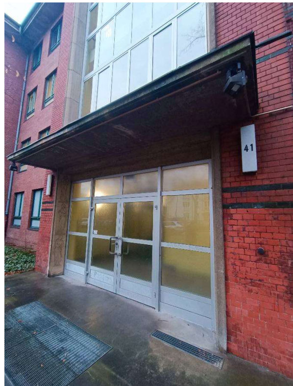
T.EG.057 & F.OG01.038 Bestand Straßenseite
