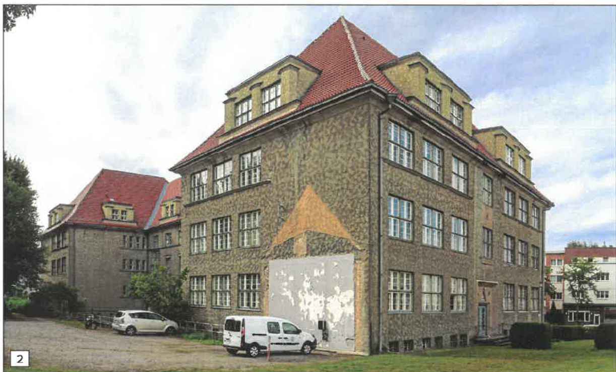
Bilder 1 und 2: Universitätsgebäude - Blick von Nordwesten (Bild 1) und von Südosten (Bild 2).
