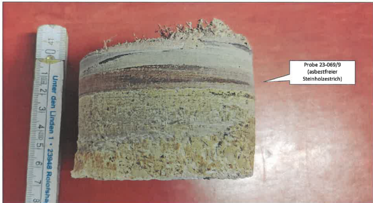
Bild 15: 2. OG, Flur – Kernbohrung 23-069/9 zeigt Fußbodenaufbau mit asbestfreiem Steinholzestrich.
