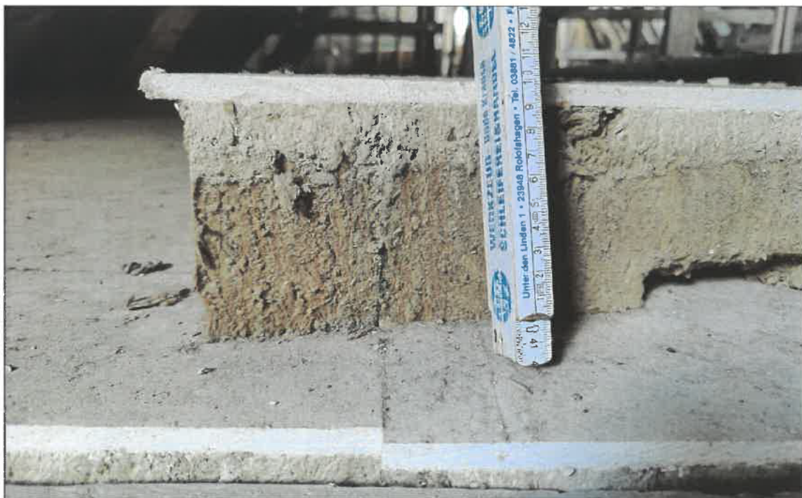
Bild 4: Dachboden, Zentralbereich – Fußboden mit Fußbodenelementen mit Steinwolle-Dämmung unter Fermacell.
