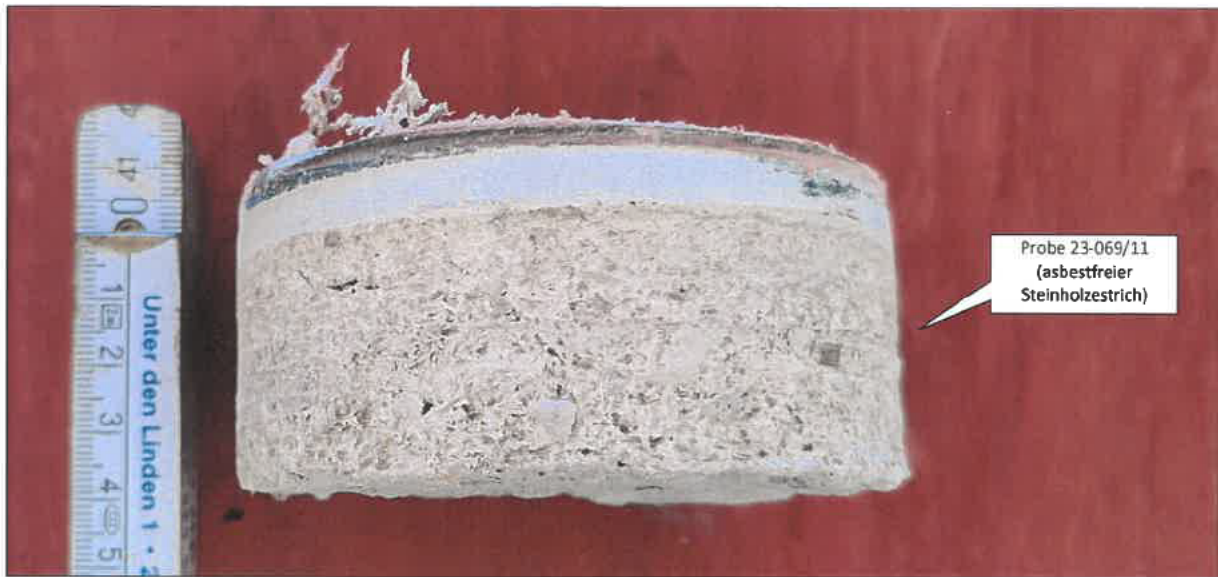
Bild 17: 2. OG, R 201, Hörsaal HS 3 – Kernbohrung 23-069/11 zeigt Fußbodenaufbau mit asbestfreiem Steinholzestrich.
