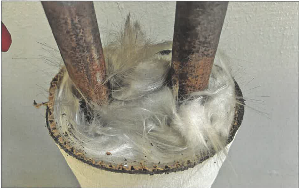
Bild 9: Kellergeschoss, Flur – Heizleitungen mit Dämmung aus Glaswolle.
