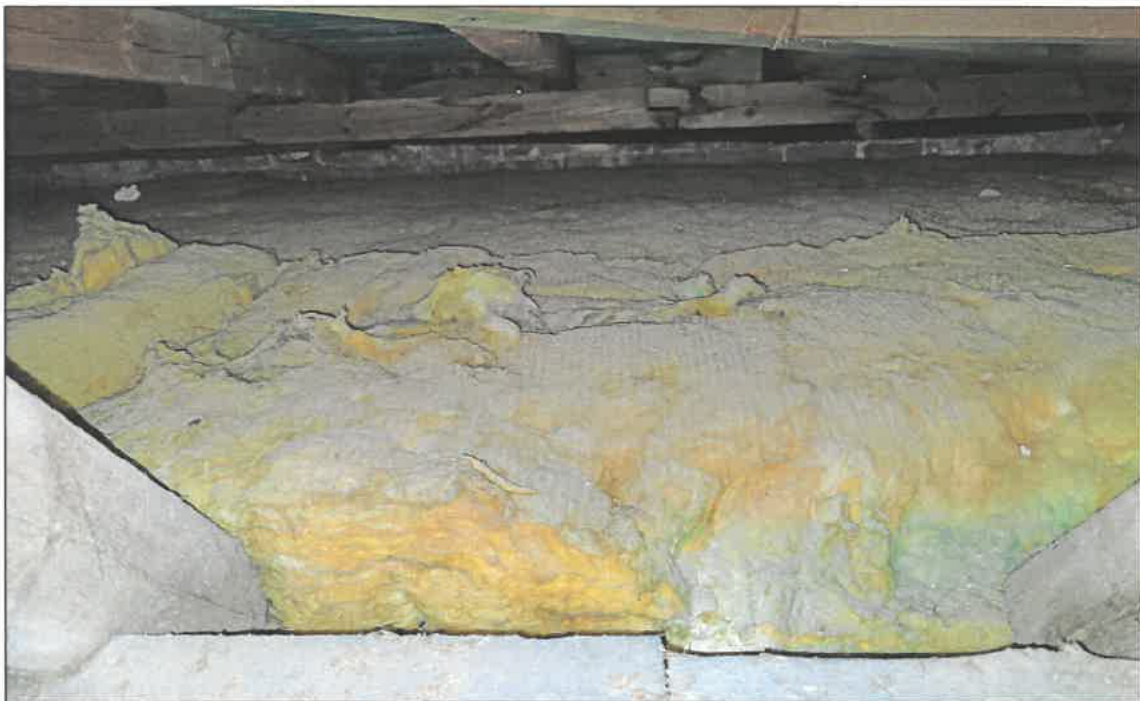
Bild 6: Dachboden, Südseite – Dachüberstände über Abseiten mit Steinwolle-Dämmung.
