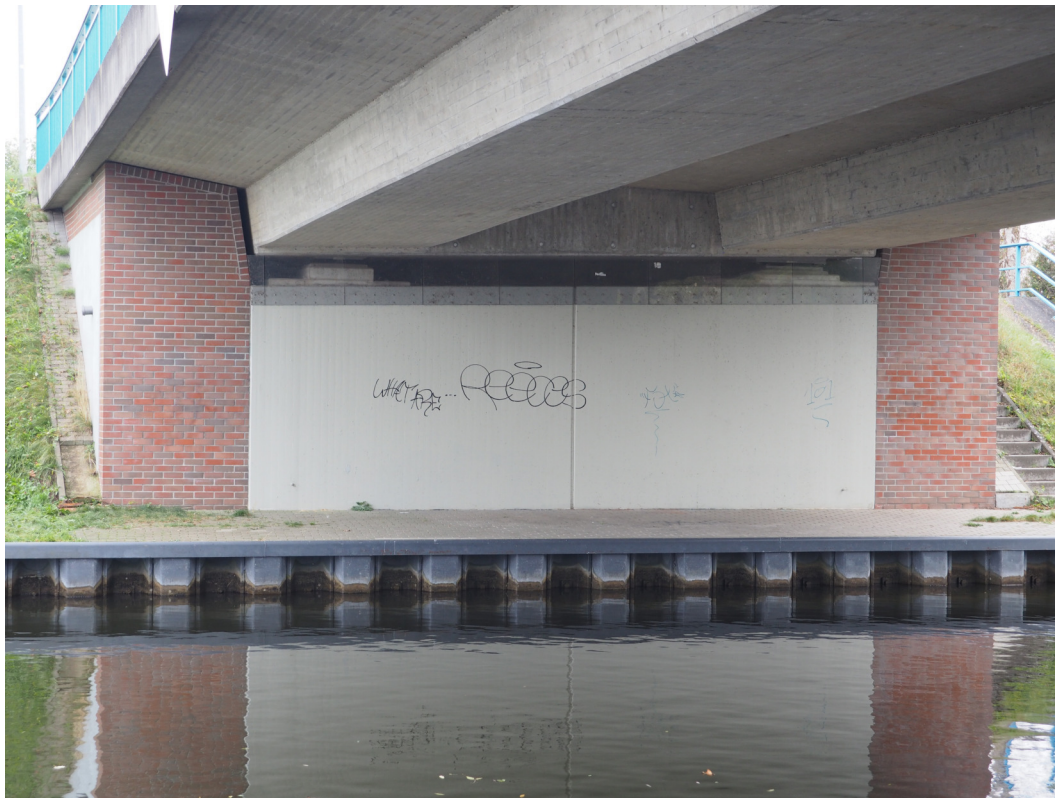
Brücke B 198, OD Mirow (UF Alte-Müritz-Havel-Wasserstraße) Verklinkerung – Farbton Rotbunt (herbstlaub)
