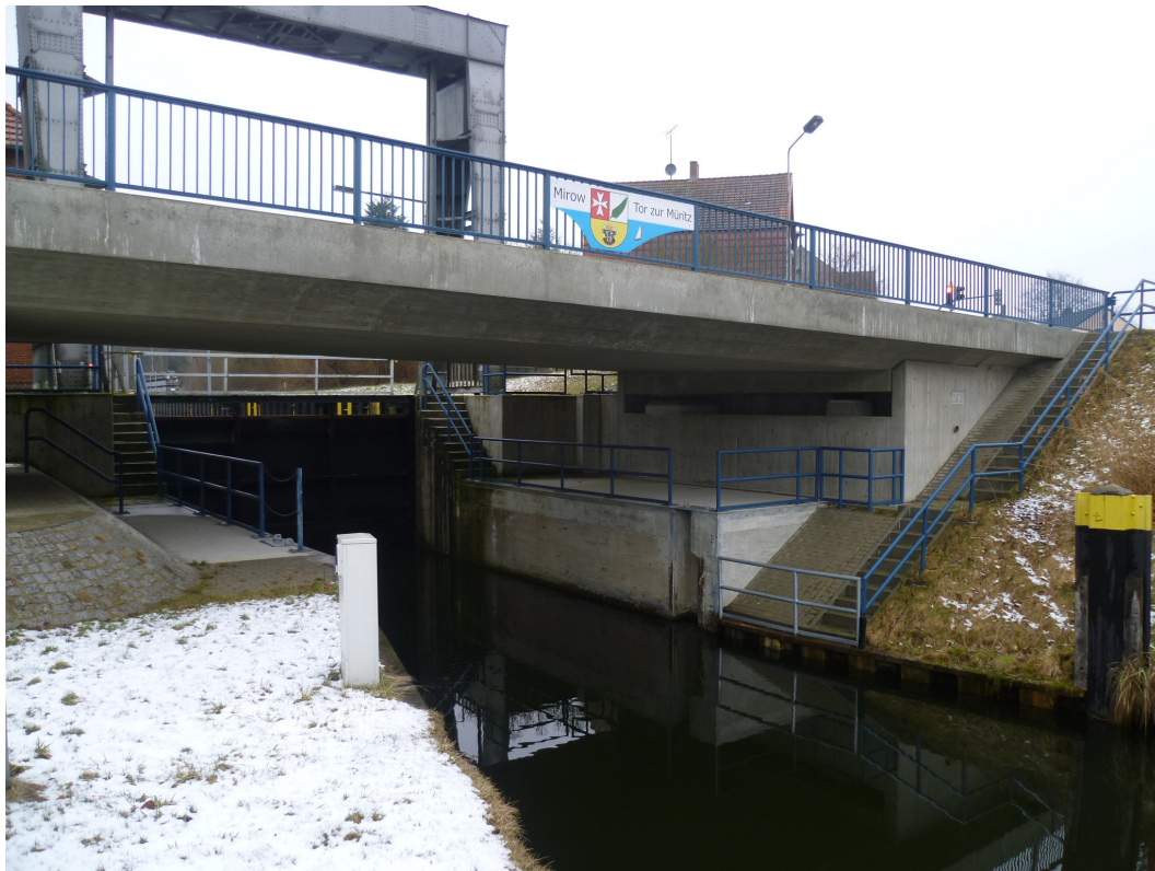
Schleusenbrücke Mirow (UF Müritz-Havel-Wasserstraße)
