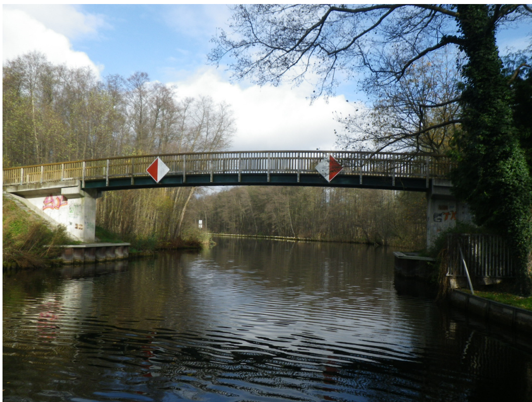
Hohe Brücke Mirow (UF Müritz-Havel-Wasserstraße)
