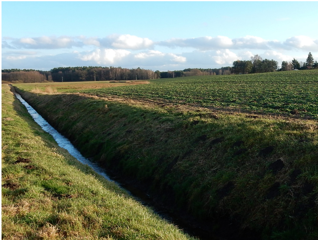
Graben L 03 bei Starsow – Standort Bauwerk BW 1 S
