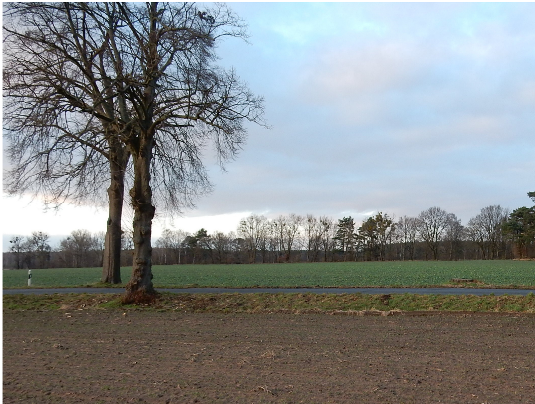
Kreisstraße MSE 18 – Standort Bauwerk BW 2 W
