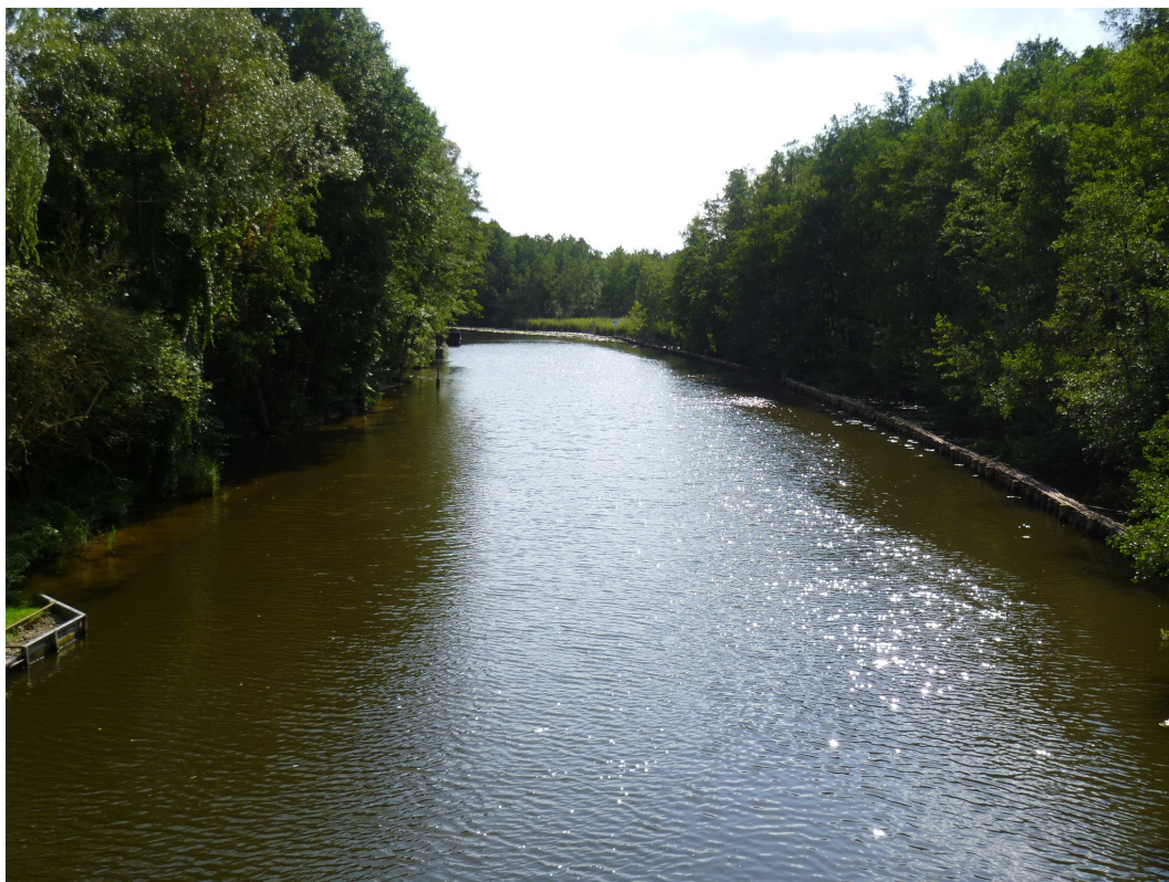
Blick von der Hohen Brücke Ri Süden – Standort Bauwerk BW 5 S
