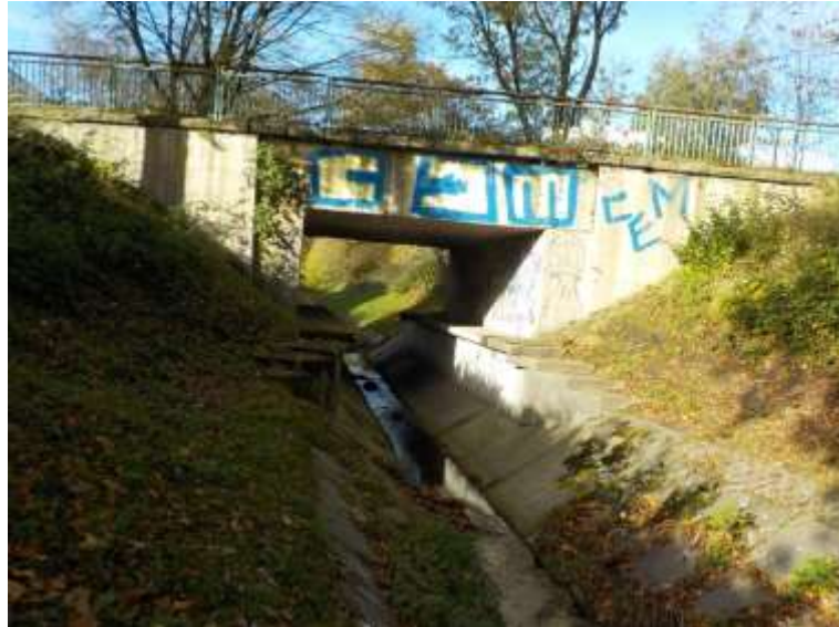
Bild 6 Privates Brückenbauwerk bei km 1+400
