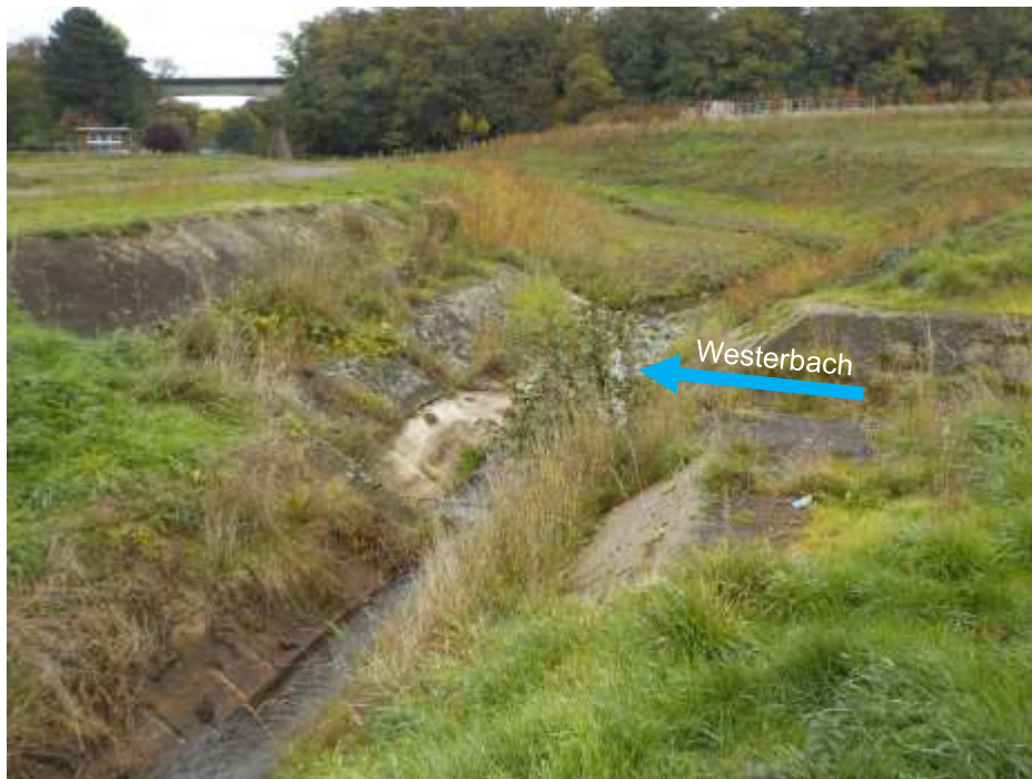
Bild 17 Befestigter Mündungsbereich Westerbach in Steinrapener Bach
