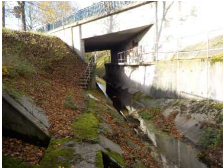
Bild 10 Brückenbauwerk Verbandsstraße WS
