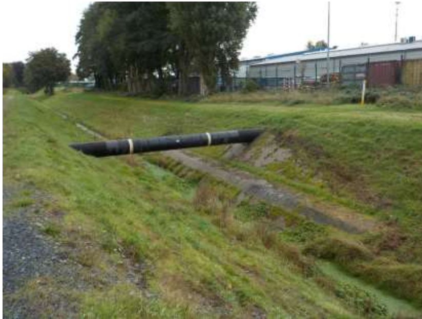
Bild 3 Gasleitung DN 400 der Fa. Thyssen Gas
