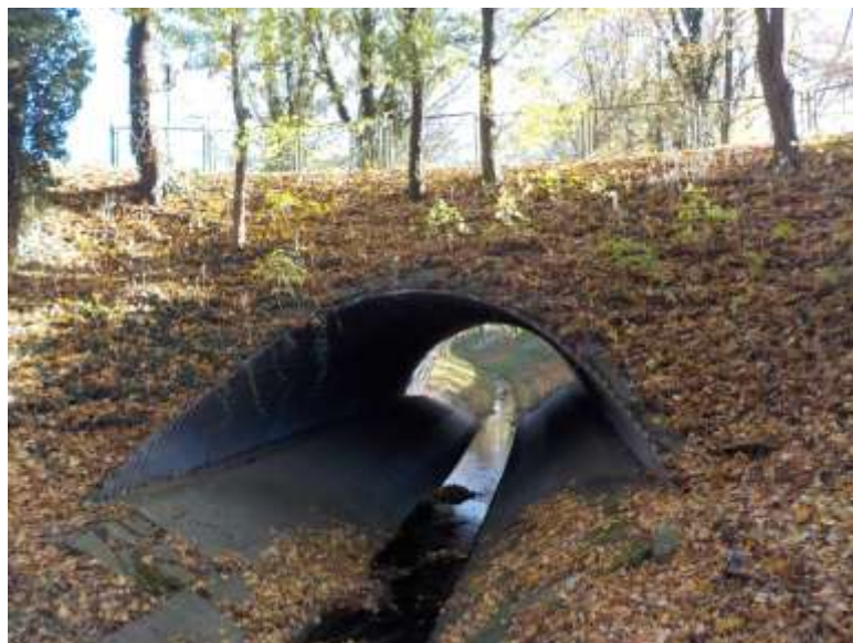
Bild 9 Durchlass bei km 1+300
