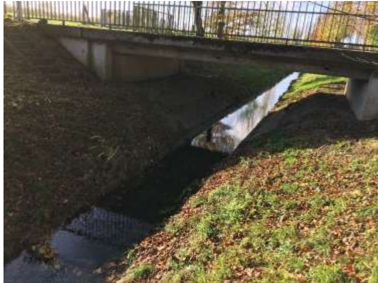
Bild 12 Brückenbauwerk bei km 0+200 östlich des Hofes Gutacker
