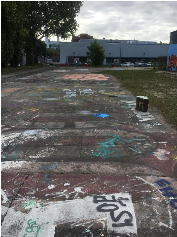
Bild 2: Betonflächen vor bestehender Betonwand
