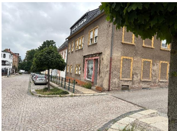
Eckbebauung nach Einfahrt August-Bebel-Straße
