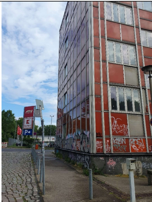
Stirnseite mit Fläche für Bauaufzug / Asbestzementplatte hinter Glasvorhangfassade
