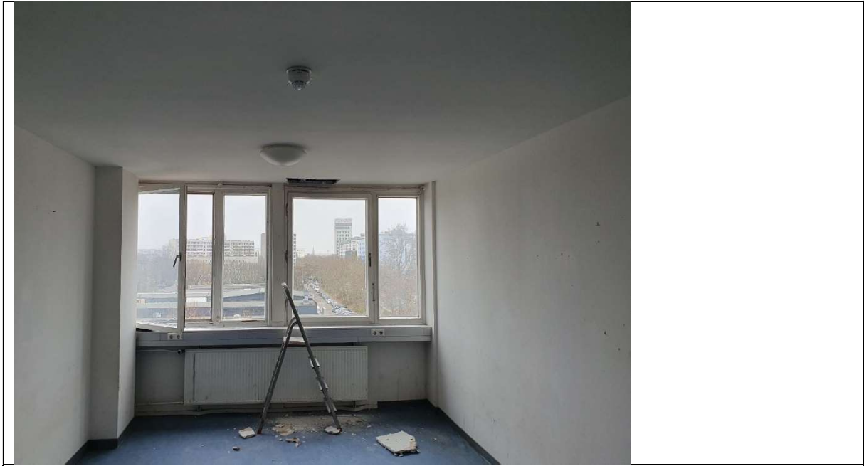
Kleiner Raum mit links ein Teil einer Stütze + GK-Wänden und -Decke. Unterhalb und oberhalb der Fenster befinden sich AZ-Platten + KMF im Fassadenbereich
