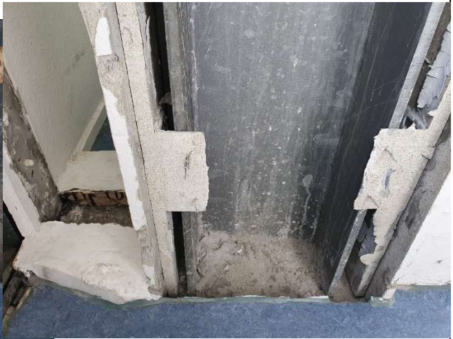
Asbesthaltige Leichtbauplatten (Sokalit) in Stärke 2cm um Stahlstützen aus einer Probesanierung
