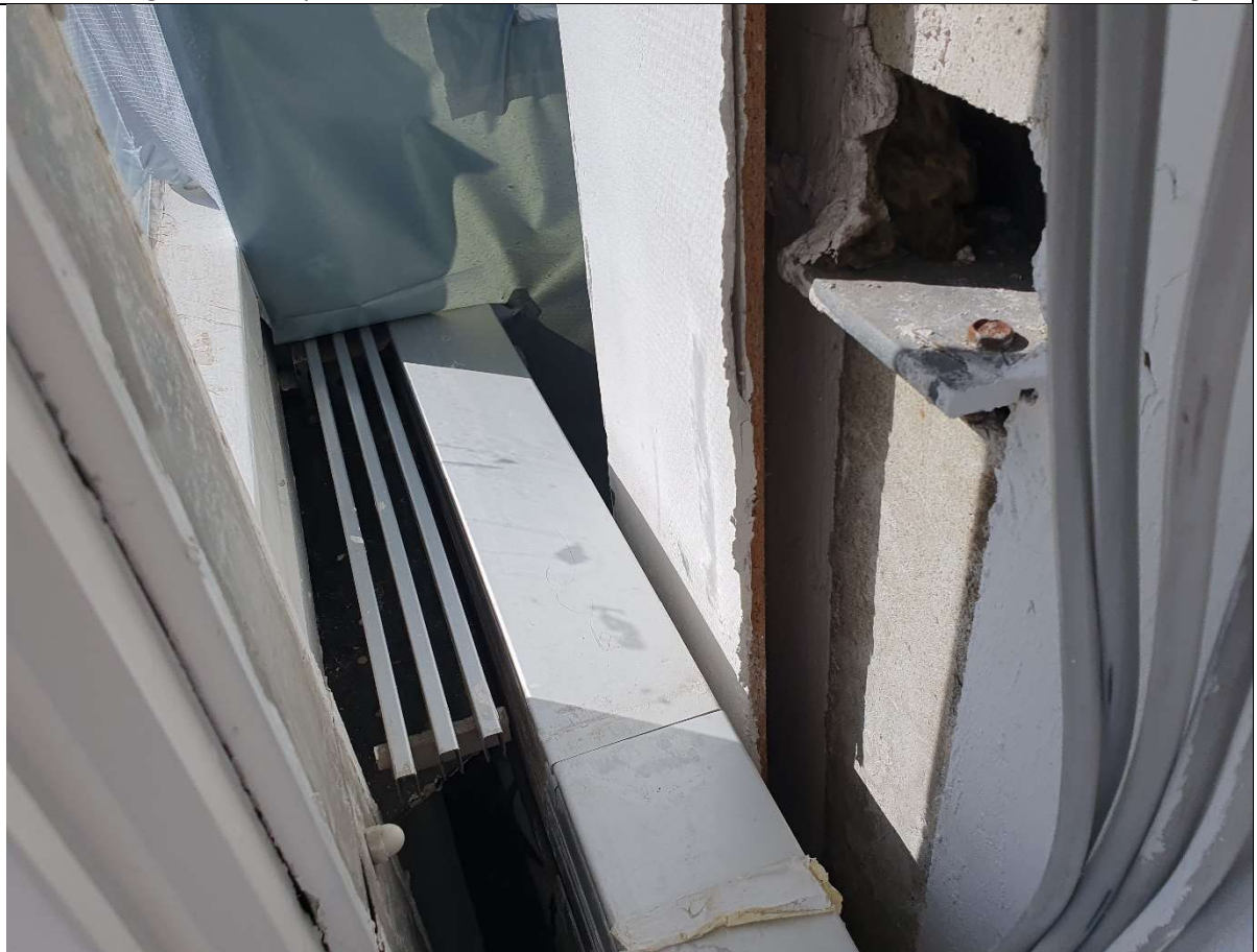
Fensterbereich: Aluminium Kabelkanal / OSB-Platten / Sokalit
