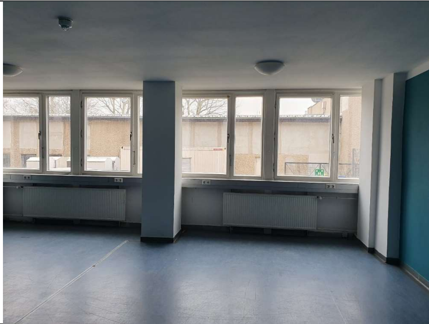
Großer Raum mit u.a. einer der mit Gipskarton und Sokalit umwickelten Stützen
