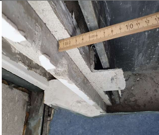
Asbesthaltige Leichtbauplatten (Sokalit) in Stärke 2cm um Stahlstützen aus einer Probesanierung
