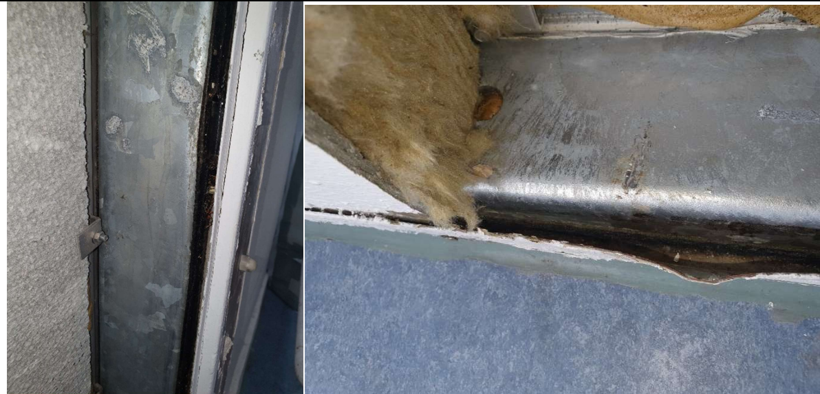
Außere AZ-Platte + Montageschrauben + Schiene innere AZ-Platte vertikal / Innere AZ-Platte + KMF + untere Schiene innere AZ-Platte horizontal im Bodenbereich
