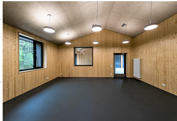
Bsp. Holzwolle- Akustikplatte in Dachneigung (Heradesign superfine) Funktionsgebäude, Landstätten
