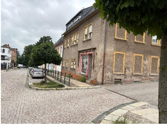
Eckbebauung nach Einfahrt August-Bebel-Straße
