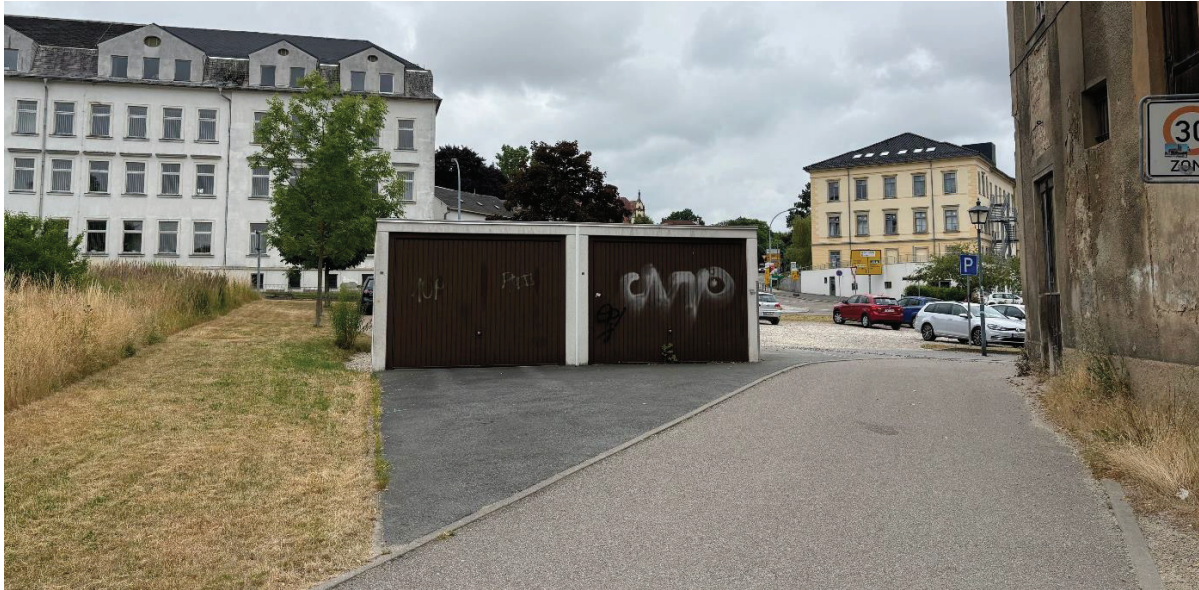
Abbildung 3_Doppelgarage auf Flurstück 492/1
