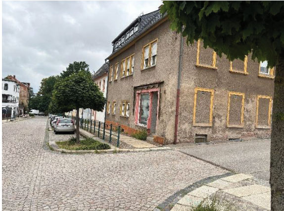
Eckbebauung nach Einfahrt August-Bebel-Straße
