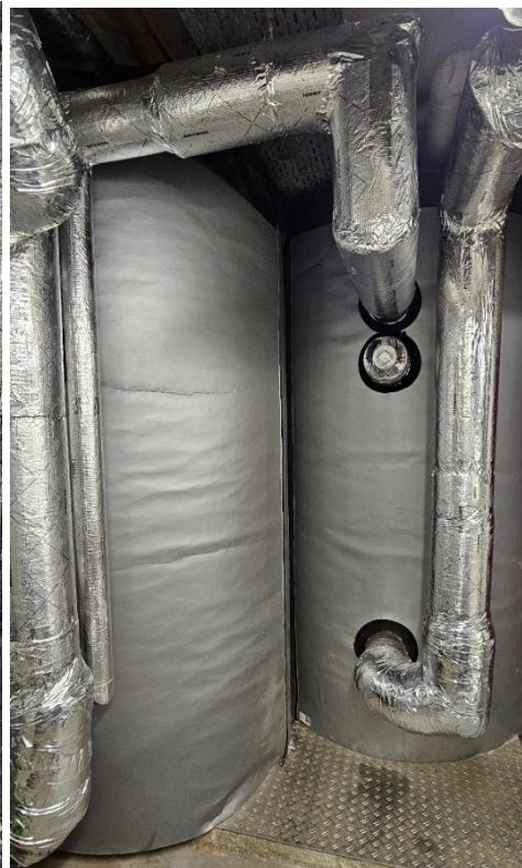
Warmwasserspeicher
