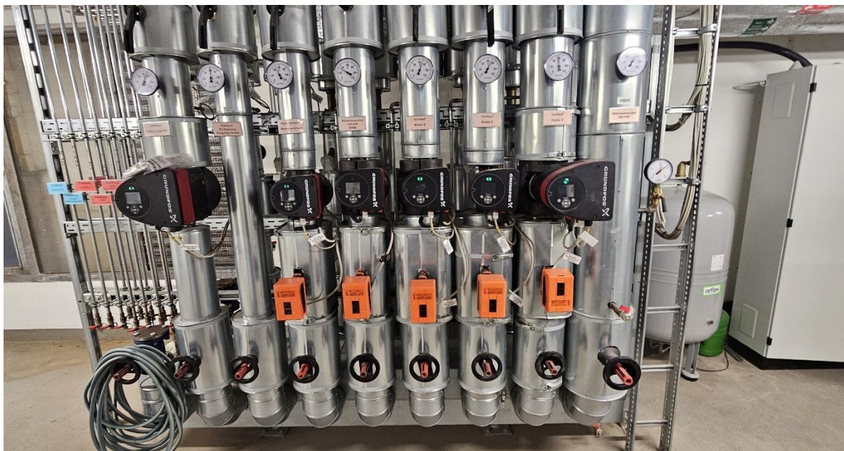
Heizkreisverteiler Bild 1
