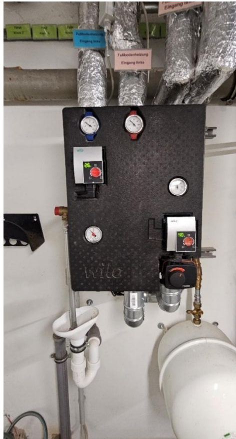
Wilo Systemtrennung Fußbodenheizung
