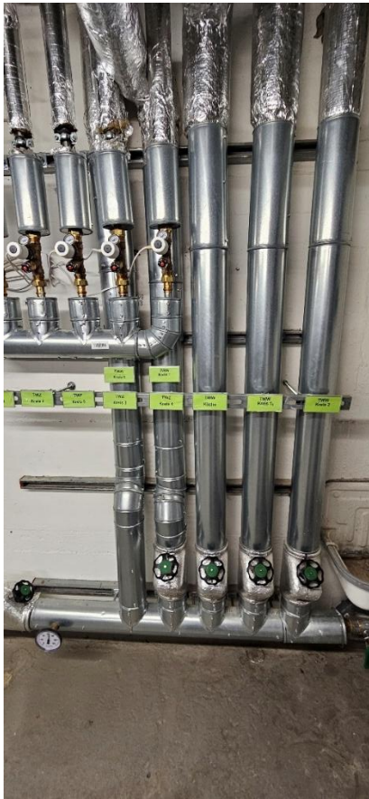
Trinkwasserverteiler
