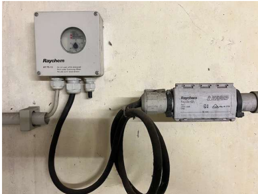
Abbildung 15, Anschlussbeispiel Rohrbegleitheizung Raychem
