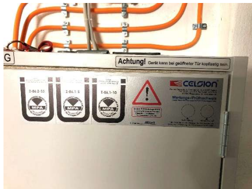
Abbildung 8, Brandschutzschrank Celsion
